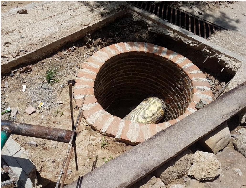
*Figura 29. Construcción pozo de inspección.
