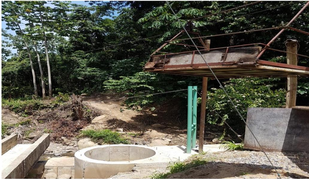
*Figura 28. Pozo de inspección-Sistema de elevador para transporte de materiales.
