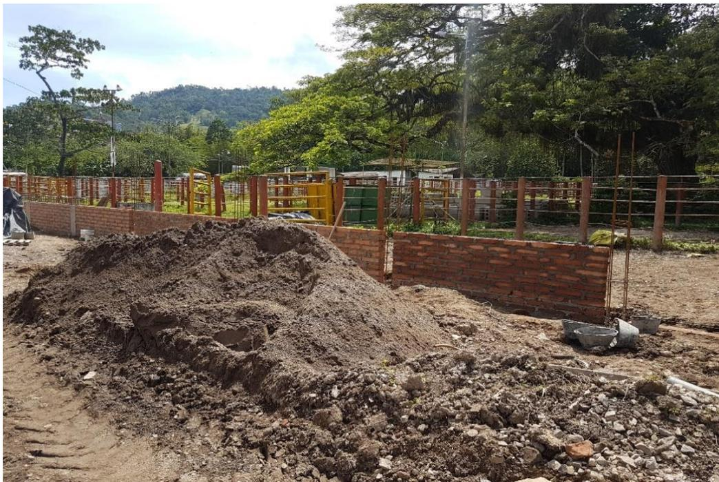
*Figura 33. Construcción del muro de cerramiento del sector plaza de ferias.
