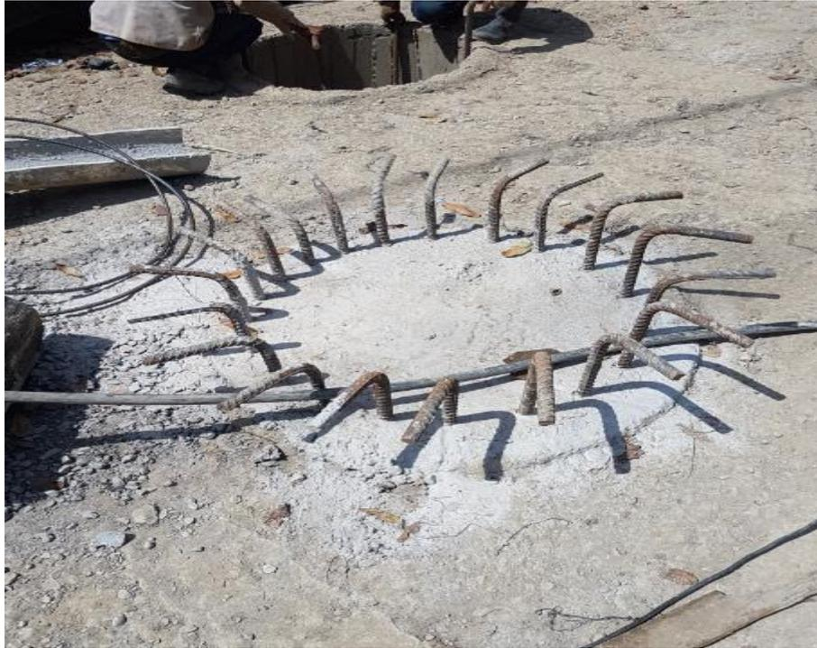
*Figura 40 Terminación de la fundición del pilote- Etapa de fraguado.
