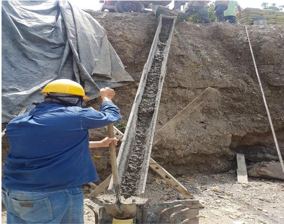
*Figura 38. Operario realizando el vertimiento de concreto en la estructura.
