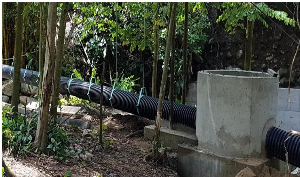
*Figura 26. Pozo de inspección tramo 1.
