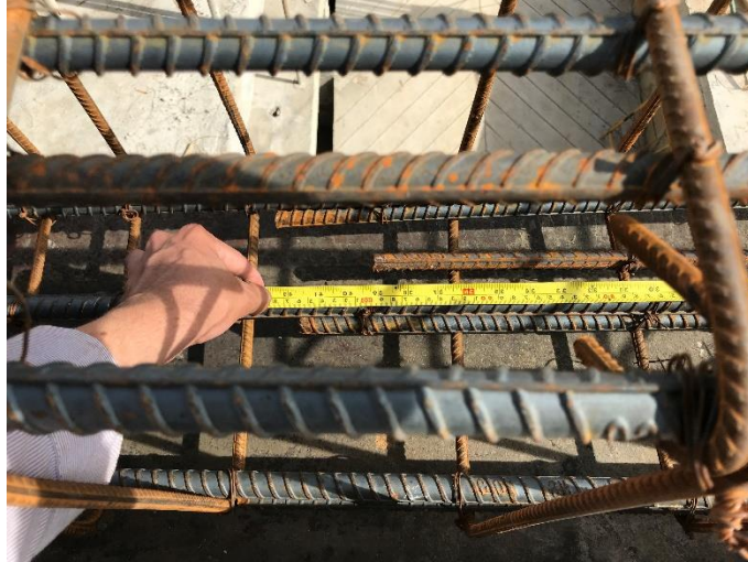
Foto 41. Medida de traslazo en viga
