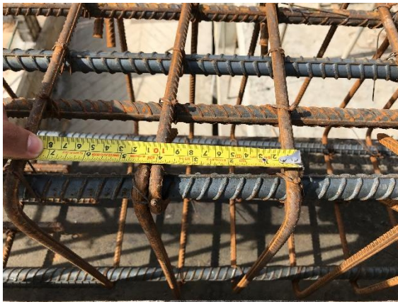
Foto 42. Separación de estribos cada 10cm
