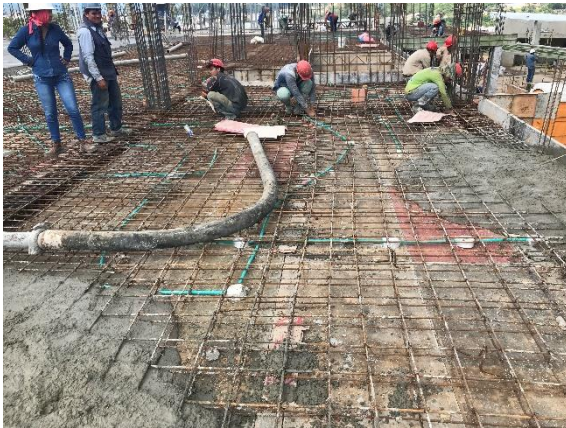
Foto 47. Vertimiento de concreto sobre parrilla de loza maciza
