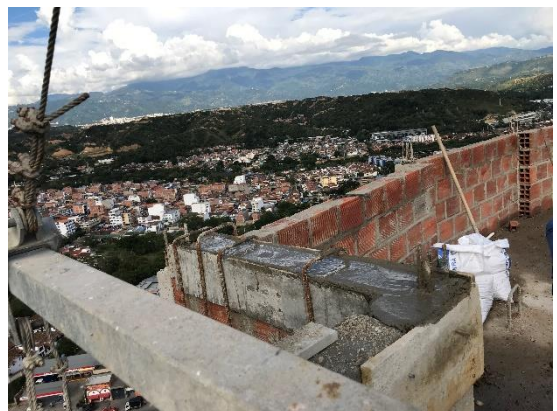
Foto 23. Fundida de viga cinta
