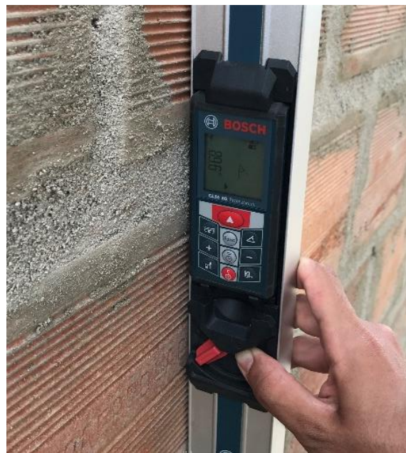
Foto 5. Zona del muro dentro de tolerancias de verticalidad
