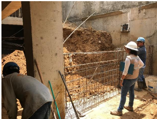
Foto 11. Muro de contención para relleno compactado al 90%
