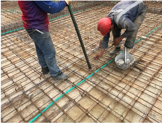
Foto 45. Ubicación de separadores de concreto en parrilla de placa
