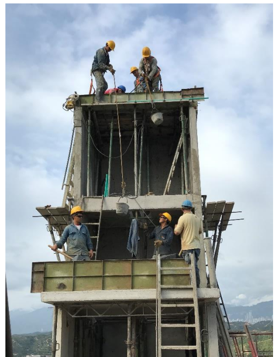
Foto 25. Fundida placa del ascensor
