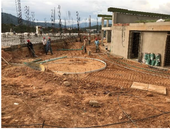
Foto 30. Malla de refuerzo para contrapiso en zona social
