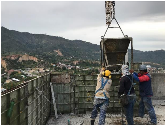
Foto 19. Fundida de antepechos cubierta
