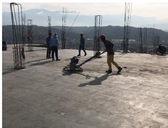
Foto 50. Pulida de la superficie de concreto en placa
