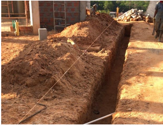
Foto 26. Excavación viga de cerramiento
