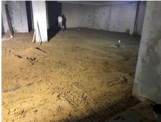
Foto 6. Compactación del suelo en contrapiso sótano 2
