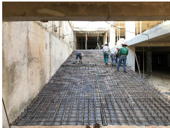
Foto 12. Armado de acero en rampa
