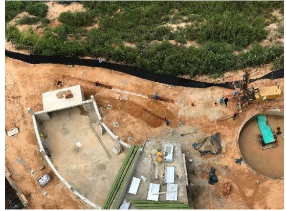
Foto 27. Excavación viga de cerramiento vista superior
