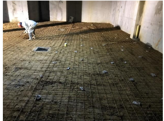
Foto 7. Ubicación de separadores de concreto en contrapiso sótano 2
