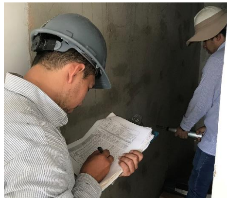
Foto 28. Toma de datos esclerometría
