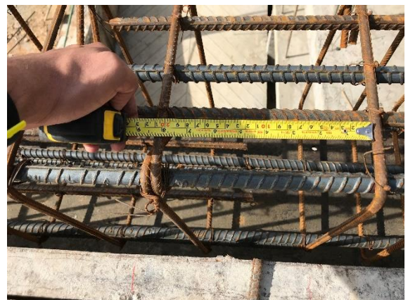
Foto 43. Separación de estribos cada 20cm
