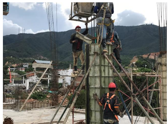
Foto 39. Fundida de columnas
