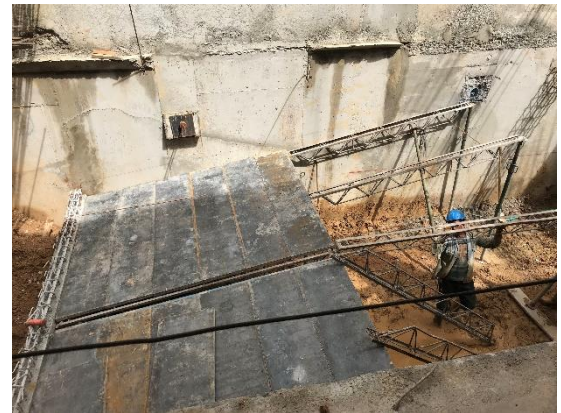
Foto 10. Armado de formaleta de rampa
