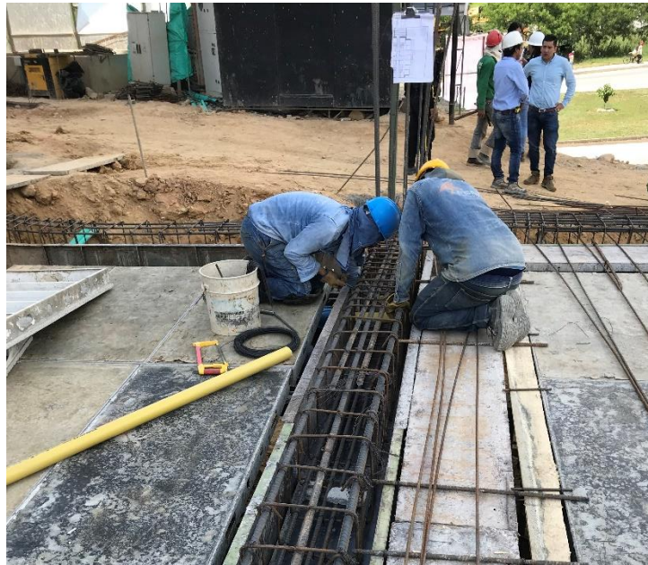
Foto 44. Posicionamiento de separadores de concreto para garantizar recubrimientos en vigas
