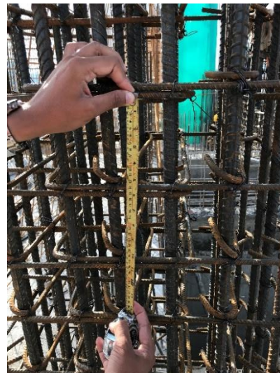
Foto 37. Separación entre estribos de una columna
