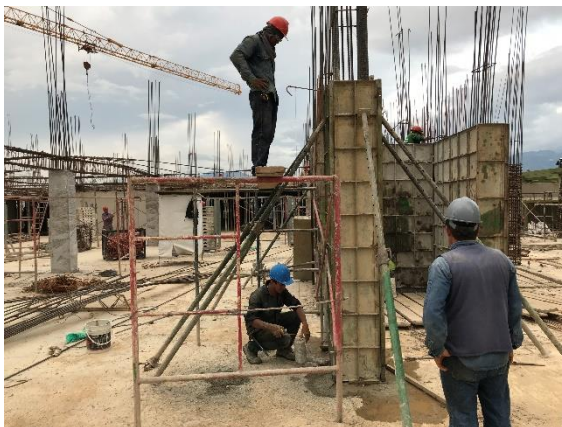
Foto 40. Armado y verticalidad de formaleta para columnas
