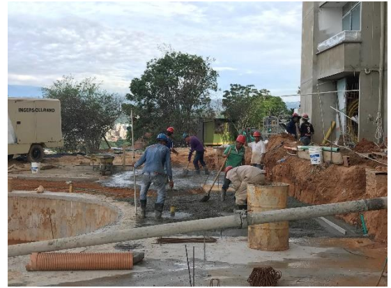
Foto 31. Fundida de contrapiso en zona social
