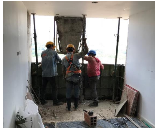
Foto 17. Fundida de antepechos apartamentos
