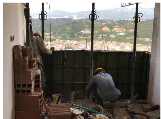
Foto 18. Armado de formaleta para antepechos
