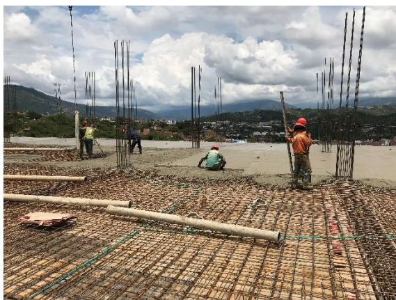
Foto 49. Enrase de la superficie de concreto en placa
