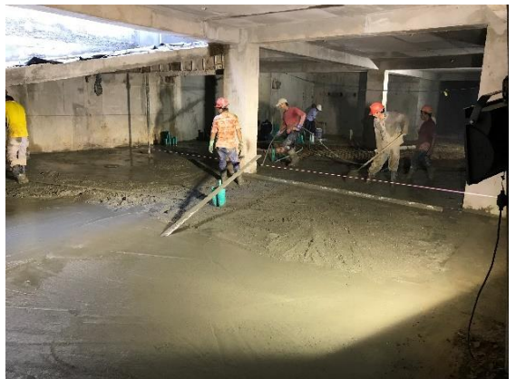
Foto 8. Vibrado y nivelación del concreto contrapiso sótano 2
