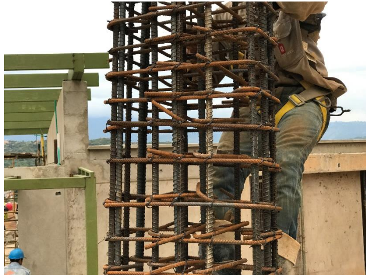
Foto 38. Amarres sin cabeza para garantizar recubrimientos
