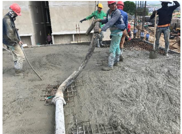
Foto 48. Vibración del concreto para distribución uniforme en la placa
