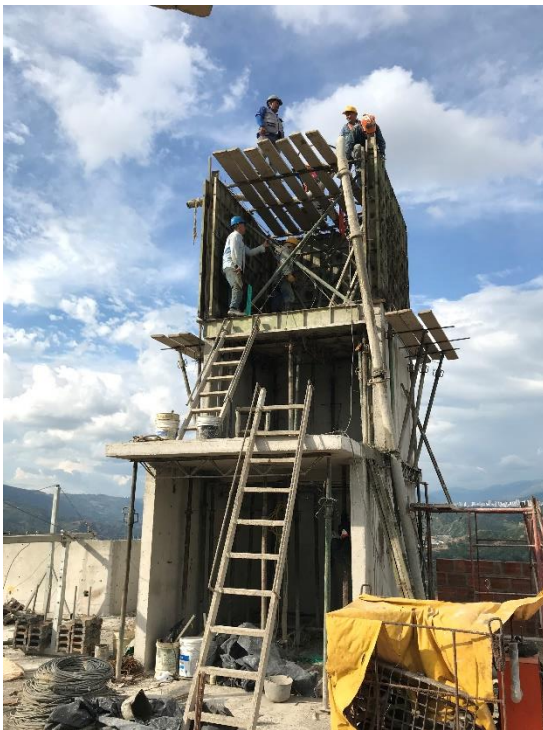
Foto 24. Fundida de muros ascensor
