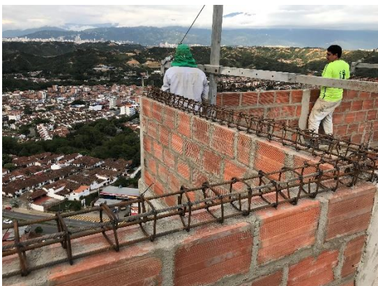
Foto 22. Armado de viga cinta
