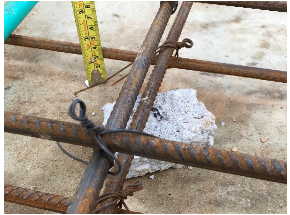
Foto 46. Separador de concreto para garantizar recubrimiento de parrilla en placa maciza
