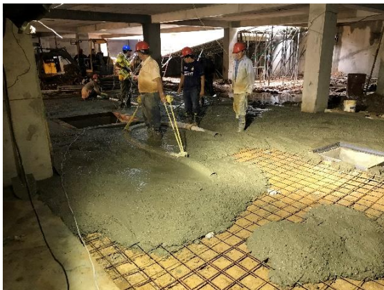
Foto 9. Vertimiento del concreto contrapiso sótano 2
