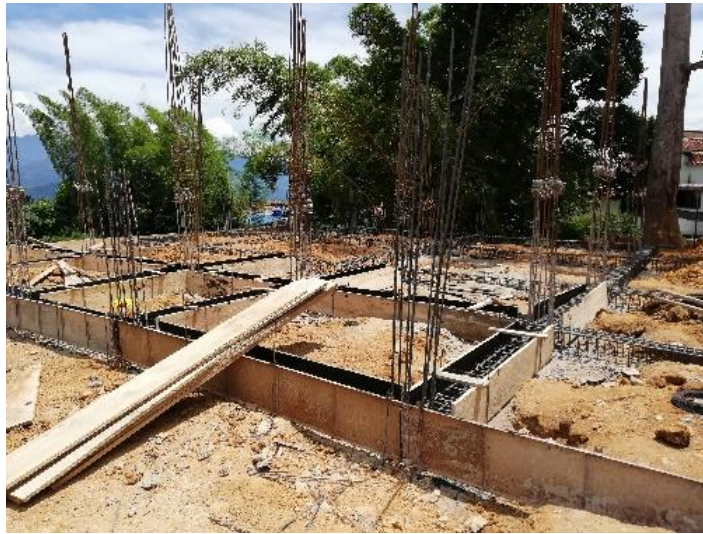
Ilustración 9. Actividades de contención y cimentación de la torre 11.
