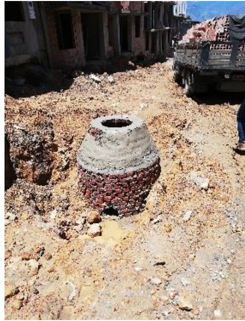
Ilustración 13. Construcción de pozos.
