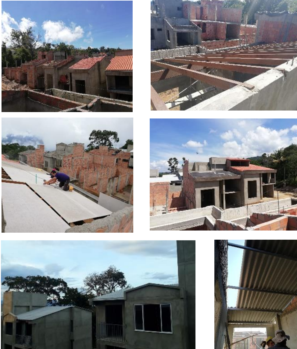
Ilustración 15. Instalación de techos.
