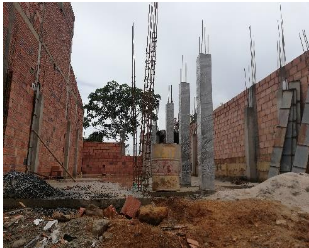
Ilustración 12. Desencofrado y curado de columnas.
