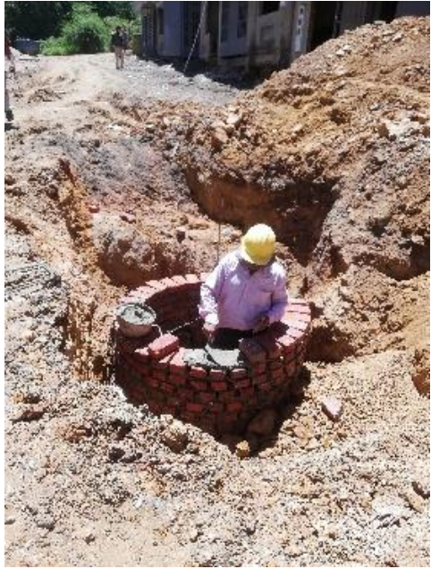
Ilustración 13. Construcción de pozos.
