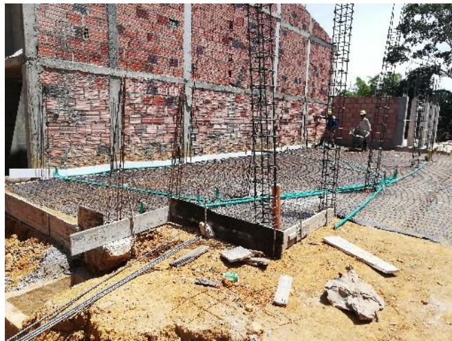
Ilustración 10. Armado de encofrado e instalación de tubería eléctrica y sanitaria para la construcción de placas.
