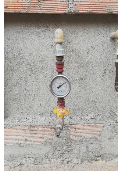
Ilustración 14. Evidencia de las pruebas de gas.
