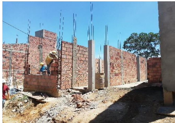
Ilustración 11. Muros en mampostería.
