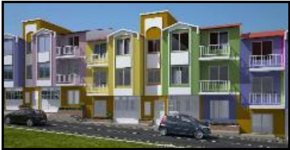
Ilustración 3. Fachada Conjunto Residencial Caminito. (Constructora Comuneros 2007)
