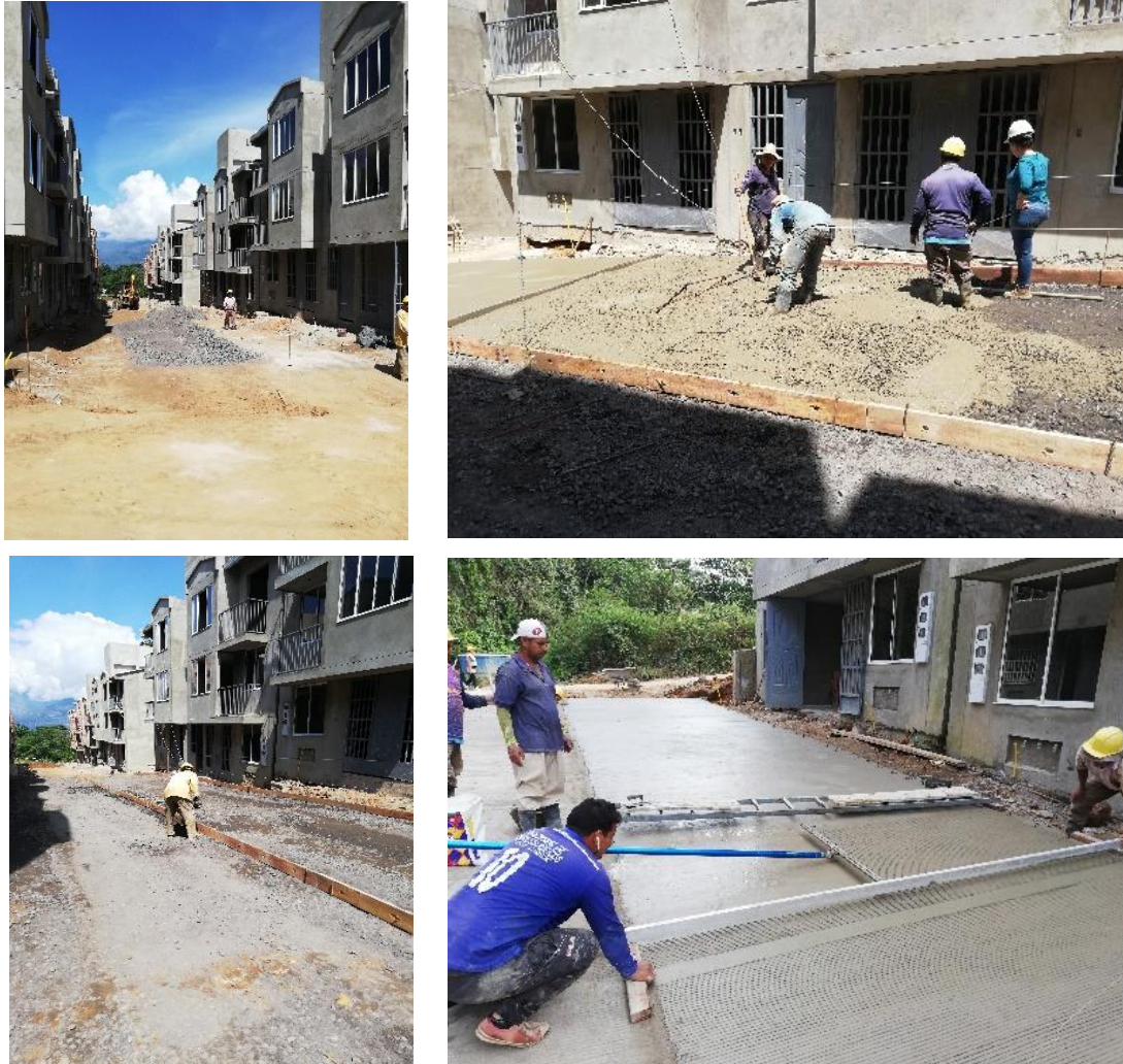
Ilustración 19. Pavimentación de la vía.
