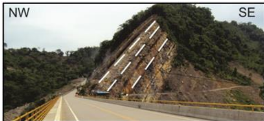
Figura 13. Estratigrafía del macizo rocoso visto sobre la margen derecha de la vía San Vicente - Bucaramanga en el Puente el Ramo en el municipio de Betulia.
