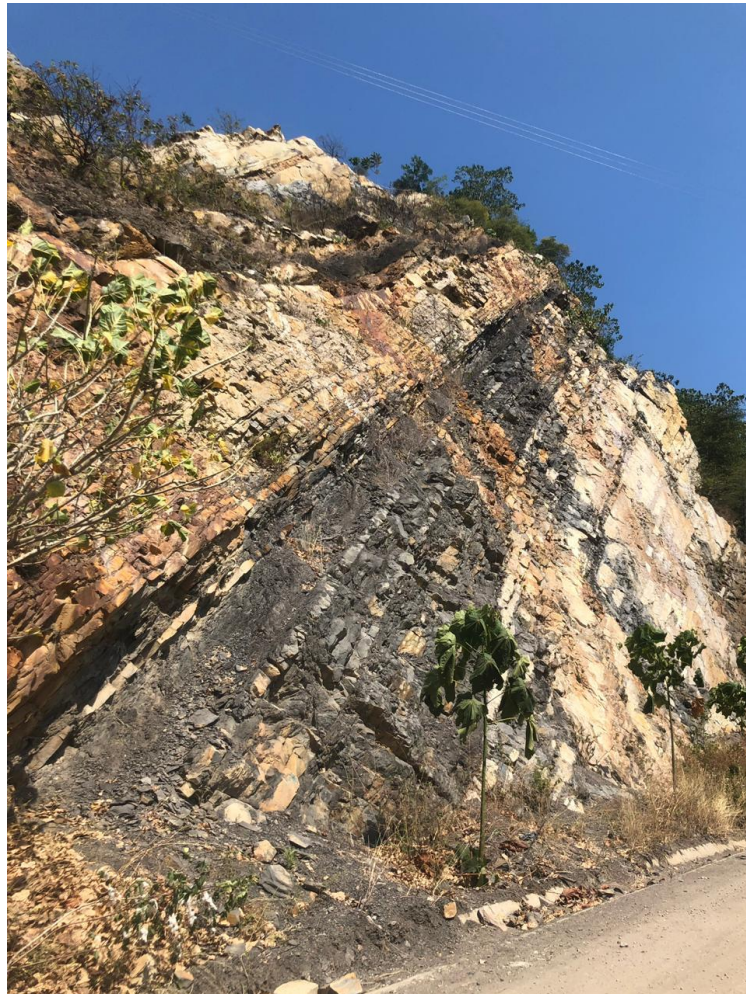
Figura 5. Meteorización presente en el talud de estudio.
