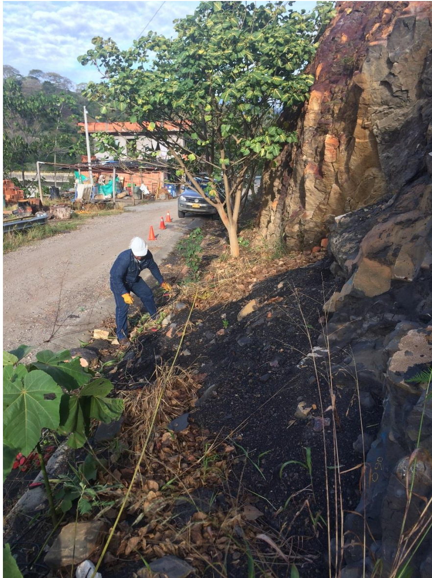
Figura 56. Línea de tendido de la refracción sísmica.
