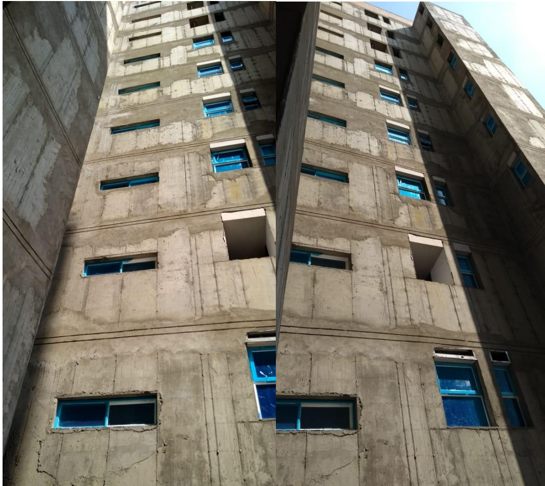
Imagen 64. Instalación ventanería en PVC.
