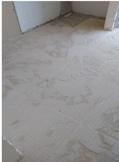
Imagen 56. Revisión calidad pega de baldosas en cerámica
