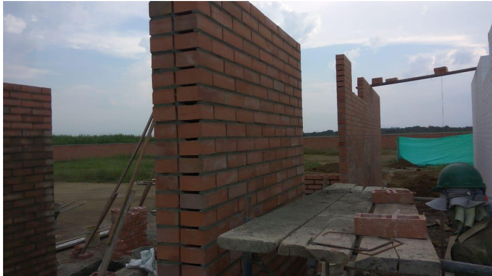
Imagen 61. Muros divisorios casa N° 60 Azucenas
