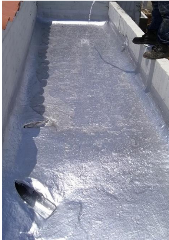
Imagen 47. Manto cubierta parqueadero
