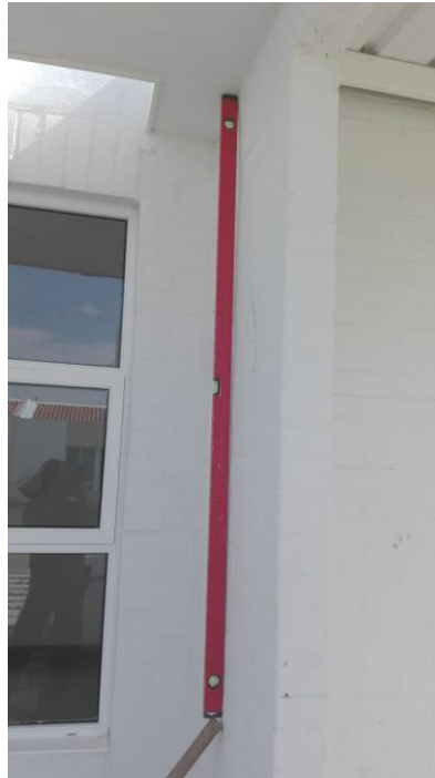
Imagen 60. Chequeo verticalidad muro y acabados
