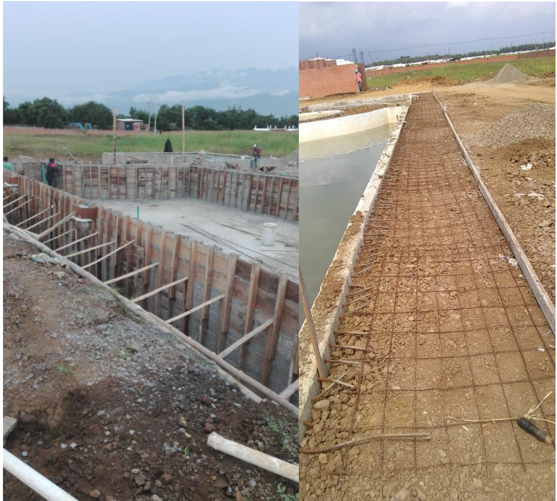
Imagen 54. Construcción piscina adultos Girasoles
