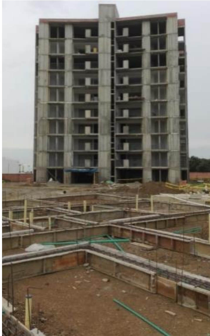
Imagen 63. Compactación terreno para zona club house
