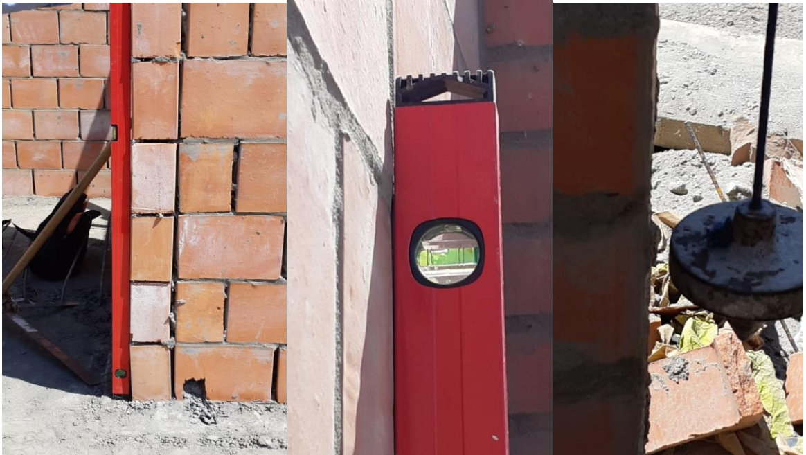
Imagen 46. Revisión verticalidad con codal, nivel y plomada
