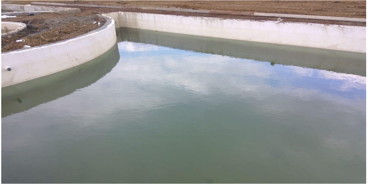
Imagen 55. Llenado parcial y total piscina Girasoles.
