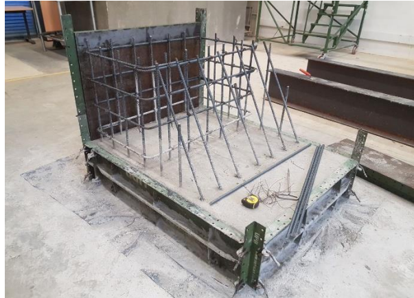
Figura 18 Fundición y fraguado de base de muro.
