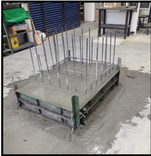
Fundida de la base del muro de contención
