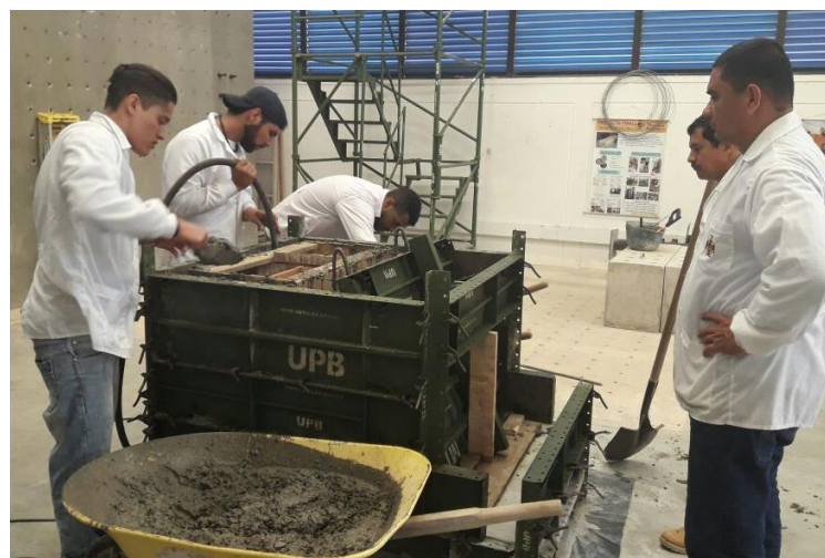
Figura 19 Encofrado y fundida de la escarpa del muro.
