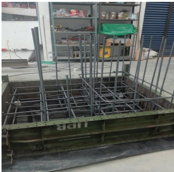
Figura 16 Armado acero estructural
