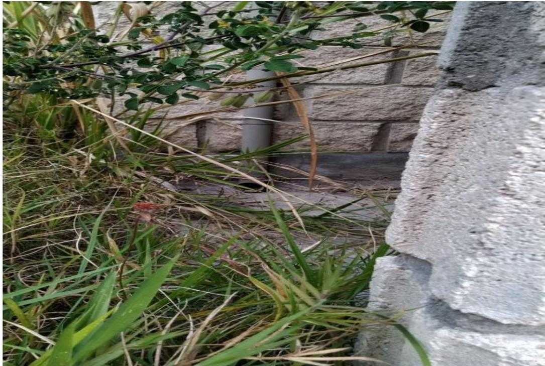
Imagen 43 Falta de conexión en los bajantes de las aulas de clase.
