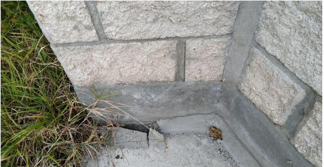
Imagen 41 Fisuras en las reparaciones anteriores.
