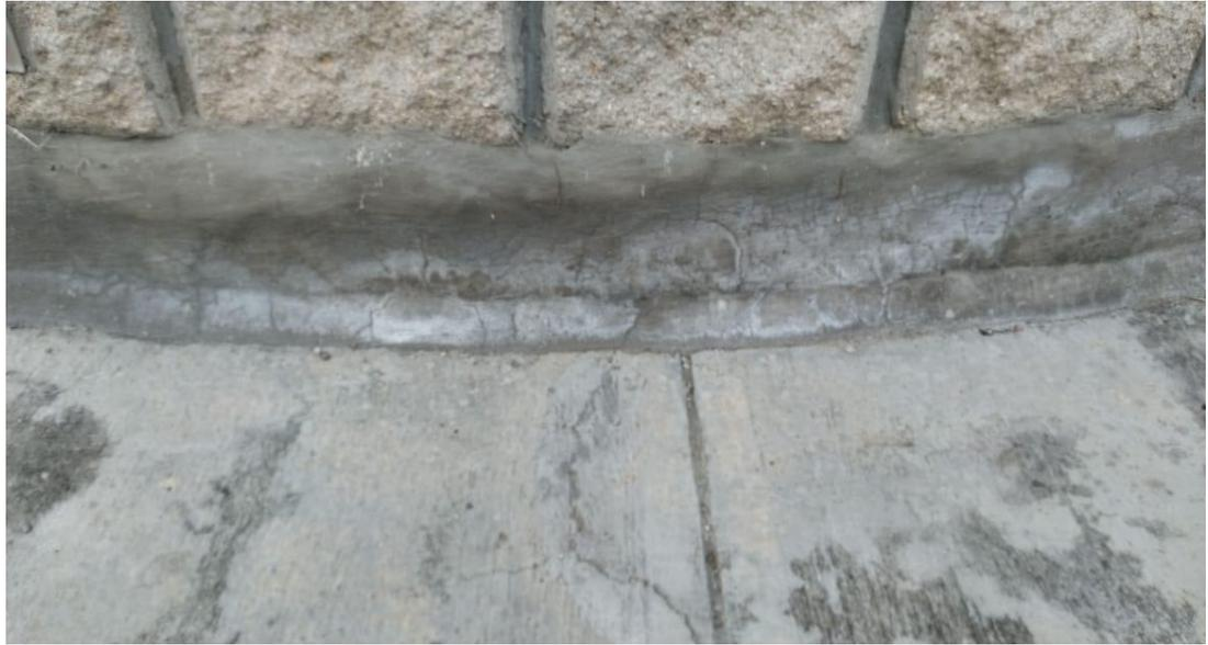
Imagen 42 Fisuras y presencia de humedad en reparaciones anteriores.
