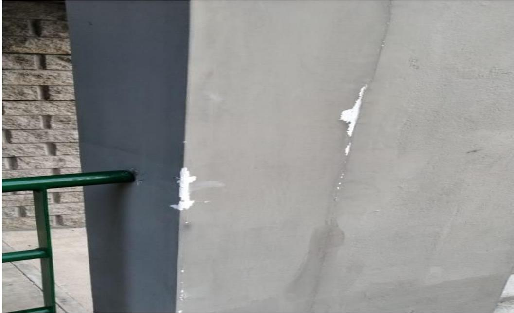
Imagen 46 Guitron con descascaramiento y presencia de humedad.
