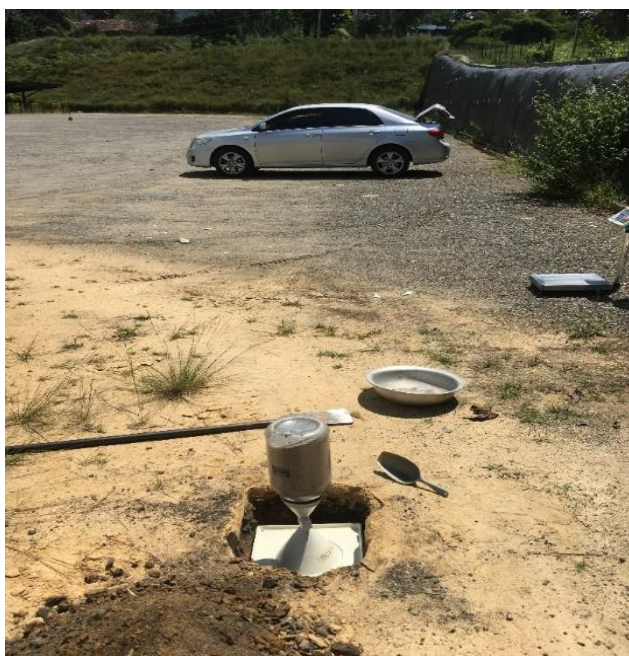
Ilustración 7. Prueba del cono y arena Parqueadero K
