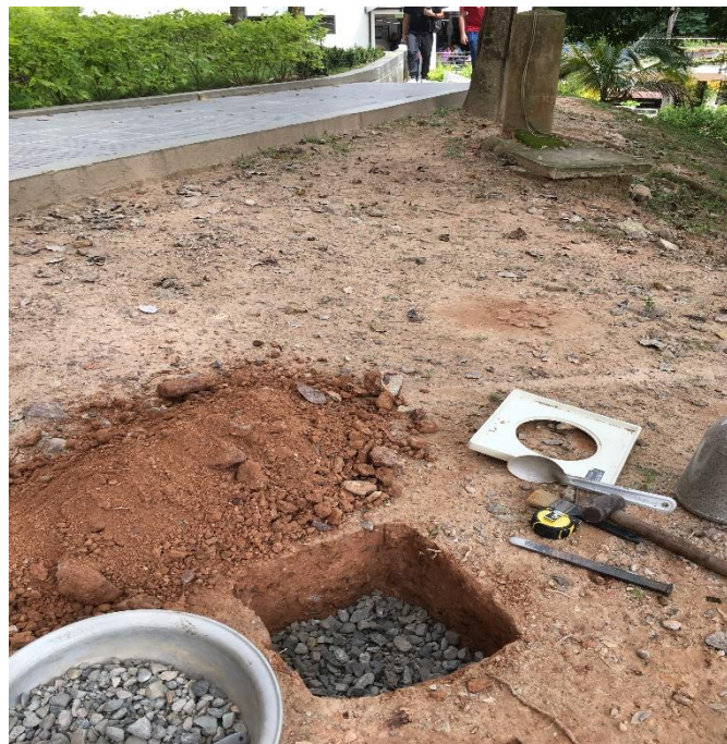
Ilustración 3. Prueba de percolación edificio I
