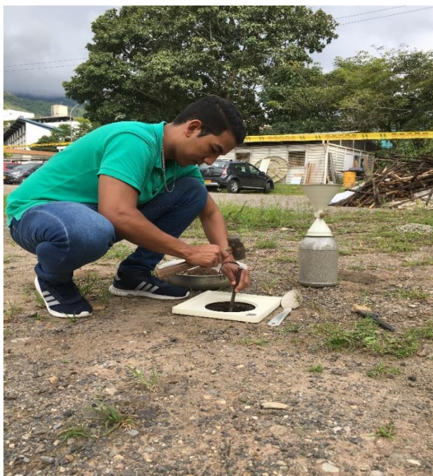
Ilustración 4. Prueba del cono y arena Parquadero de profesores
