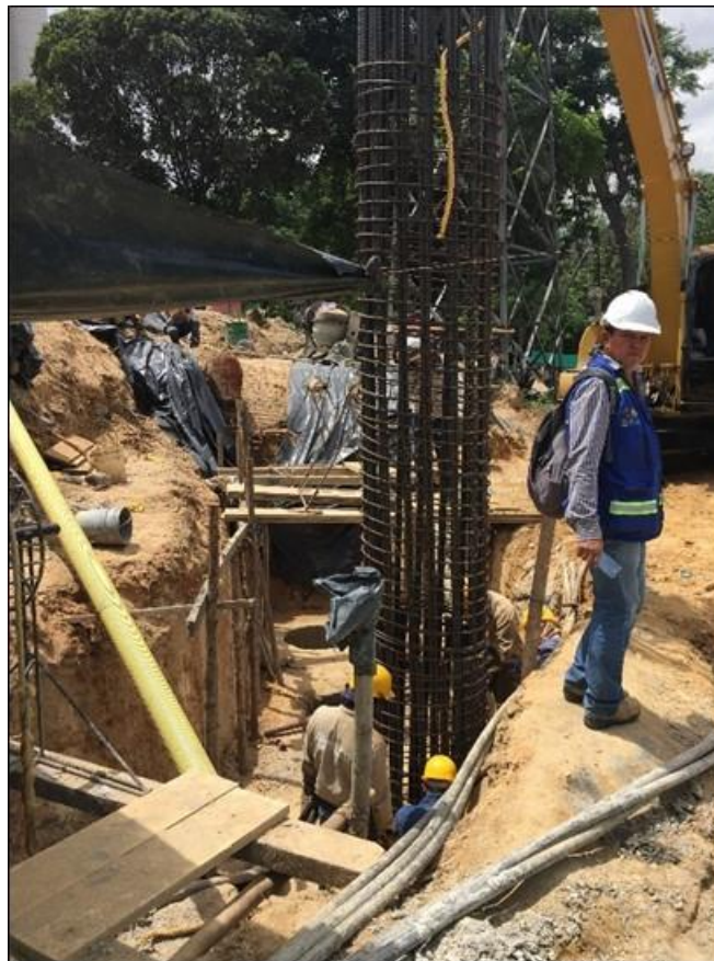
Fotografía 7. Caissons estribo Oriental.
