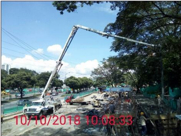
Fotografía 37. Fundida viga Pos tensada.
