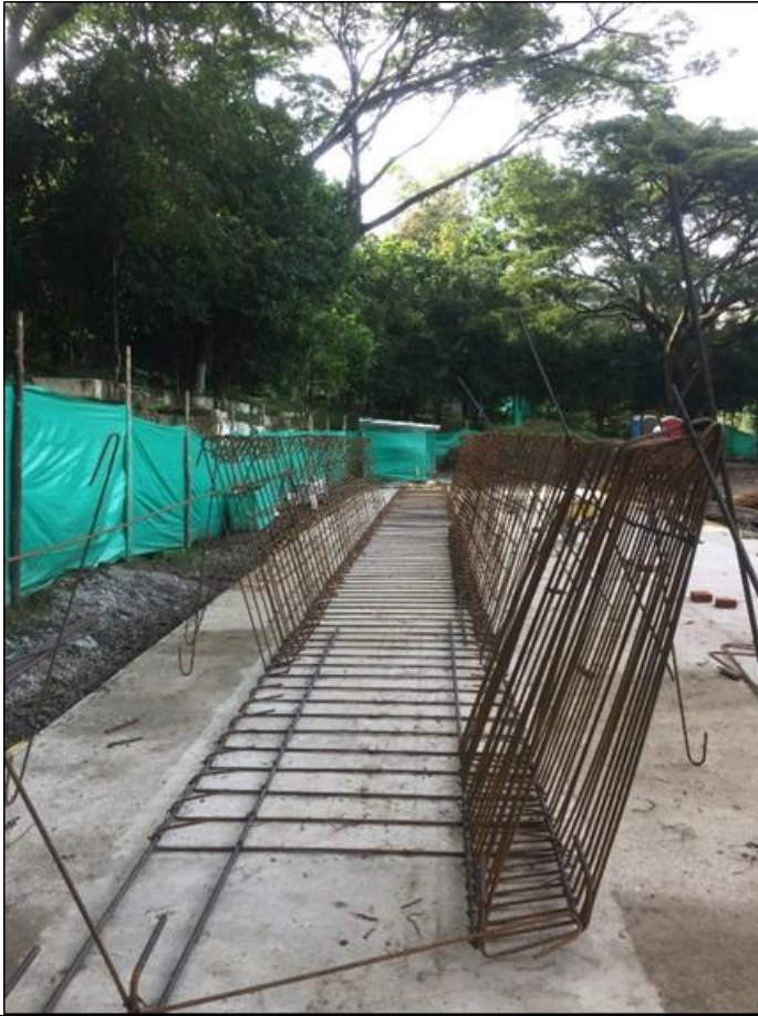
Fotografía 34. Armado Viga Pos tensada.
