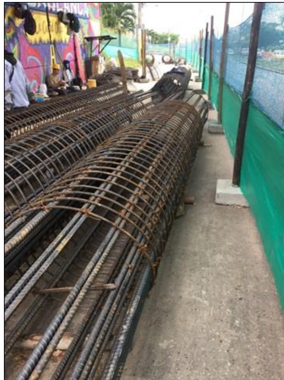
Fotografía 4. Refuerzo pilote tipo caissons.
