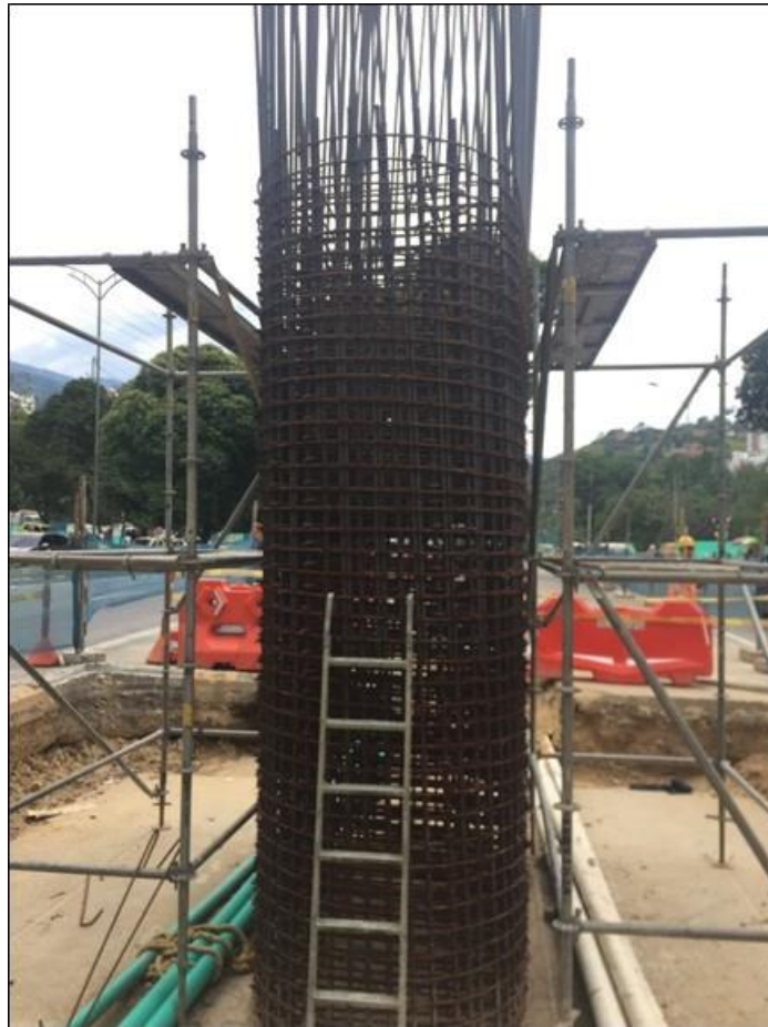
Fotografía 29. Armado pila central
