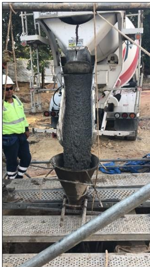
Fotografía 47. Fundida Caisson.
