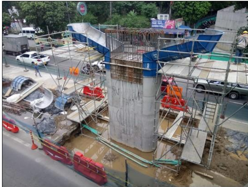
Fotografía 31. Formaleta Pila central.
