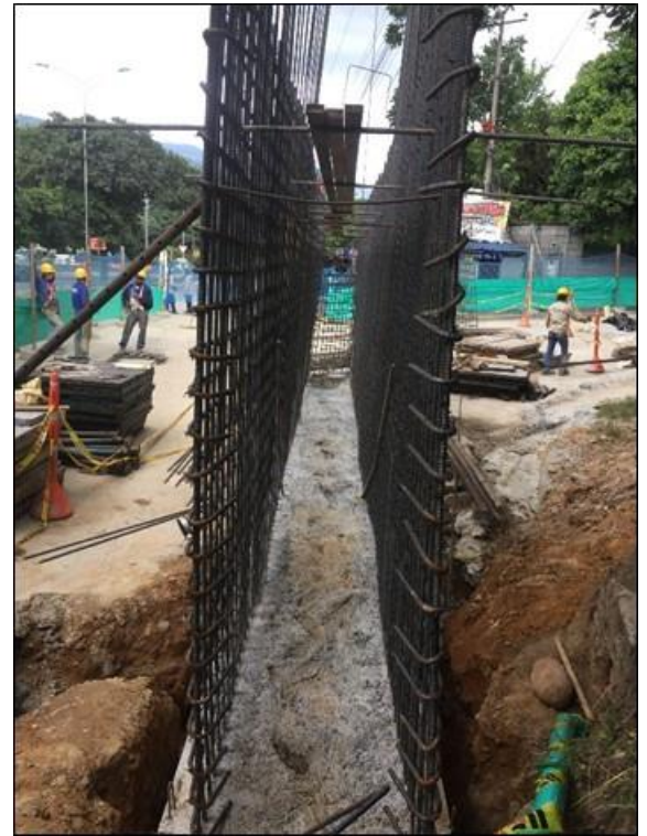
Fotografía 26. Refuerzo longitudinal estribo.
