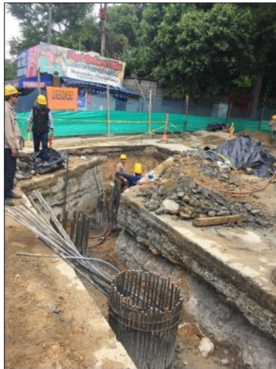
Fotografía 18. Posicionamiento Pilotes, estribo occidental.
