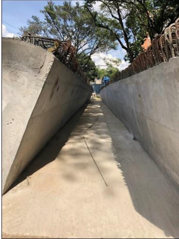
Fotografía 41. Acabado Vigas Postensadas.
