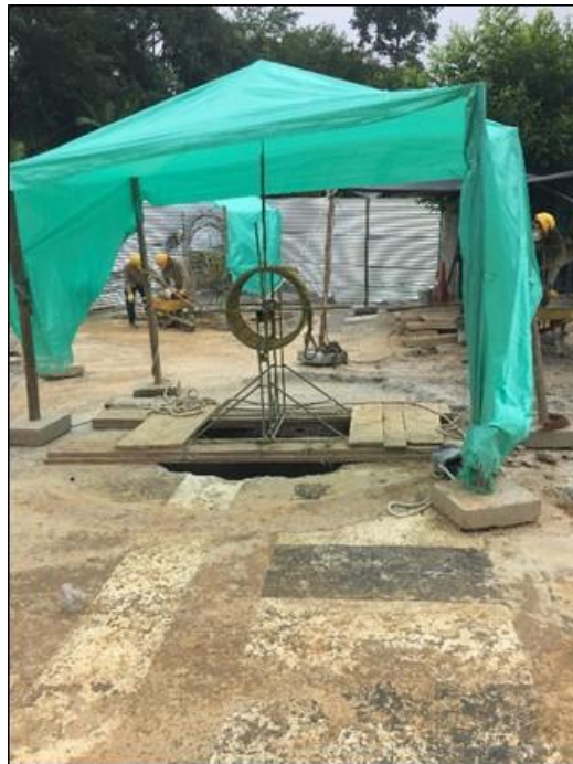
Fotografía 44. Caissons Costado occidental, mástil.
