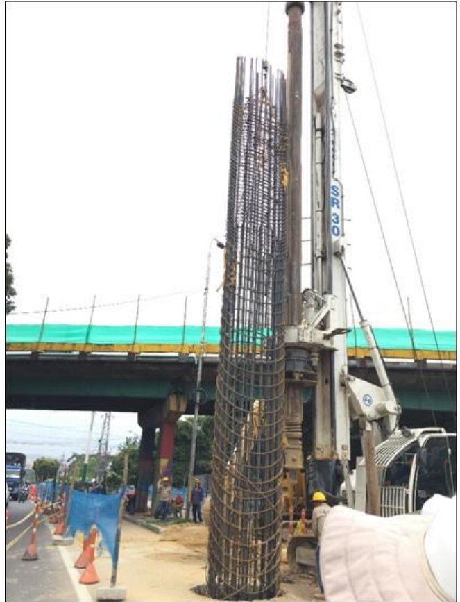
Fotografía 20. Izaje y traslape canastas cimentación columna central.
