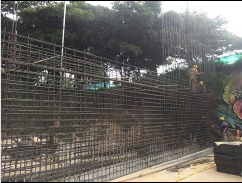
Fotografía 25. Refuerzo estribo puente sur.
