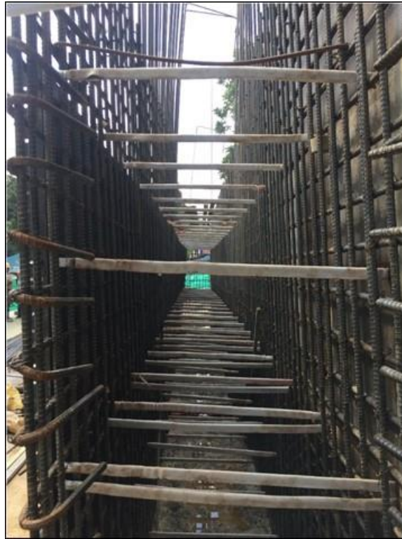
Fotografía 28. Corbatas formaleta estribo.
