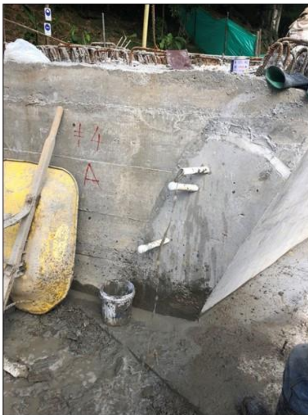
Fotografía 38. Inyección Lechada.
