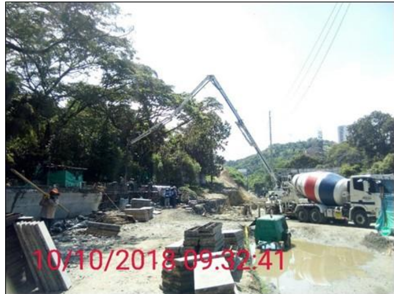
Fotografía 37. Fundida viga Pos tensada.
