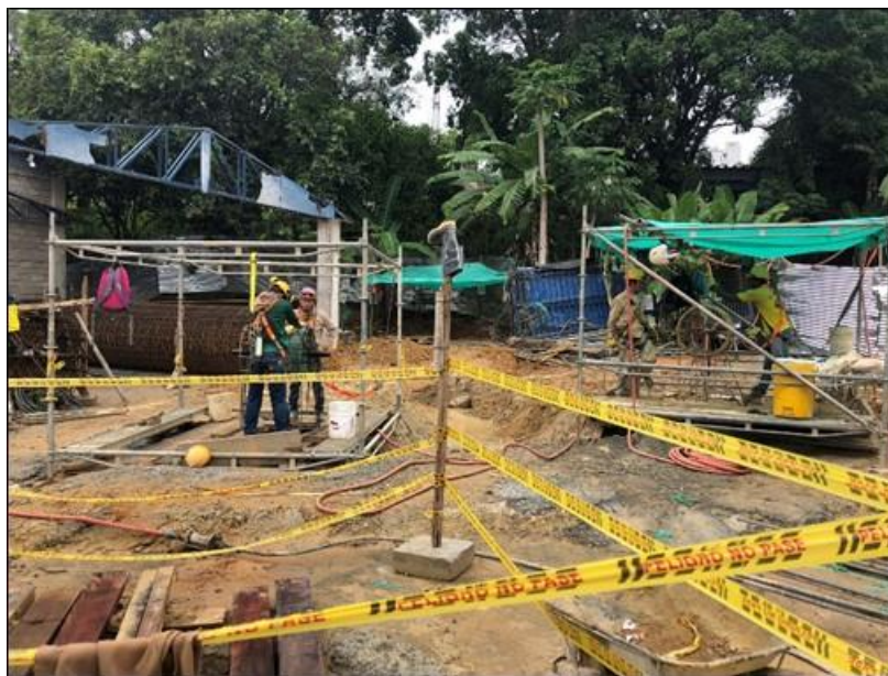
Fotografía 43. Caissons mástil puente peatonal.
