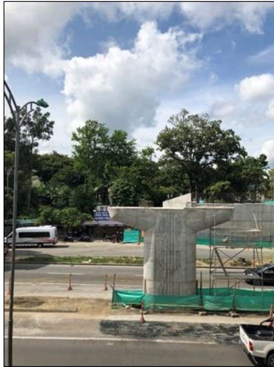
Fotografía 32. Vista frontal columna central fundida.
