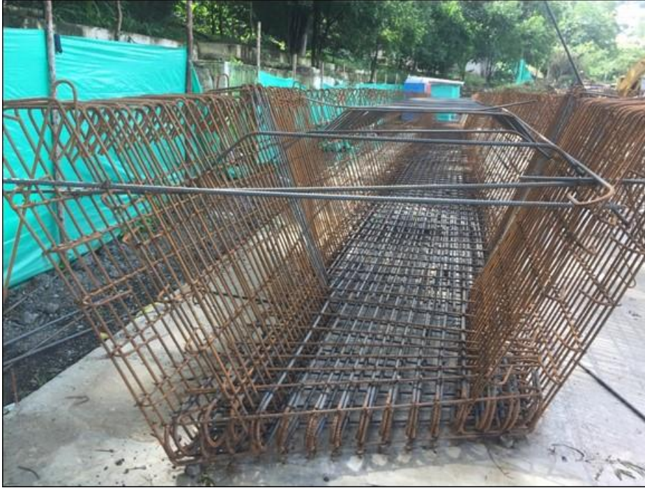
Fotografía 36. Armado Viga cajón.
