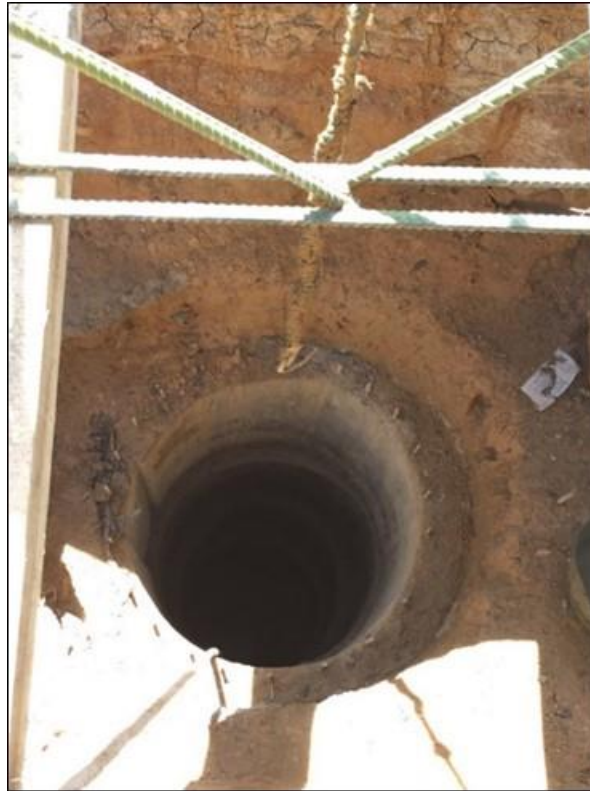
Fotografía 8. Anillo de seguridad pilote oriental.
