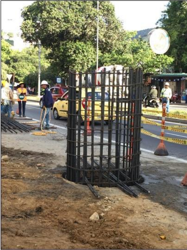
Fotografía 20. Izaje y traslape canastas cimentación columna central.
