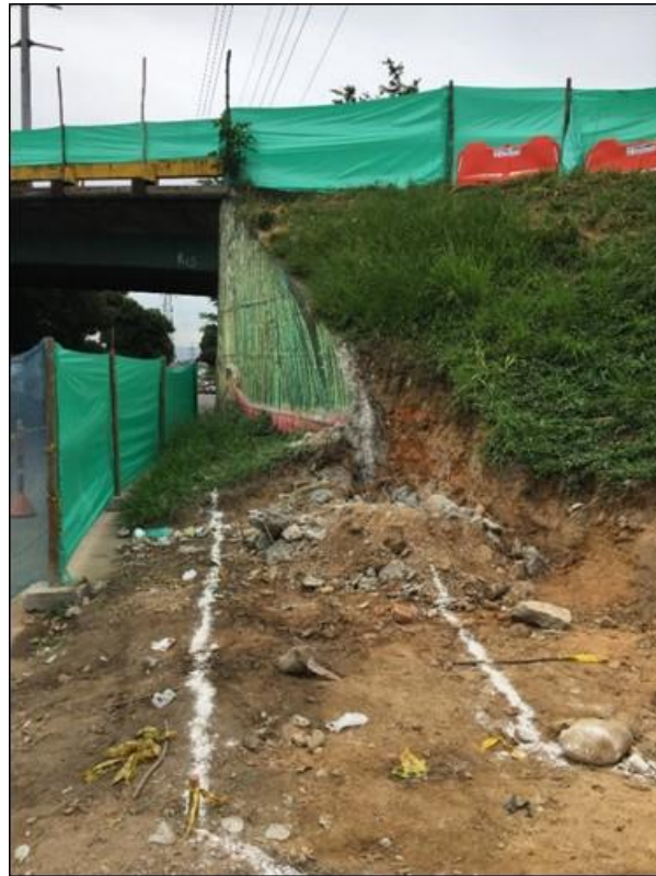
Fotografía 1. Marcación topográfica Puente costado Oriente
