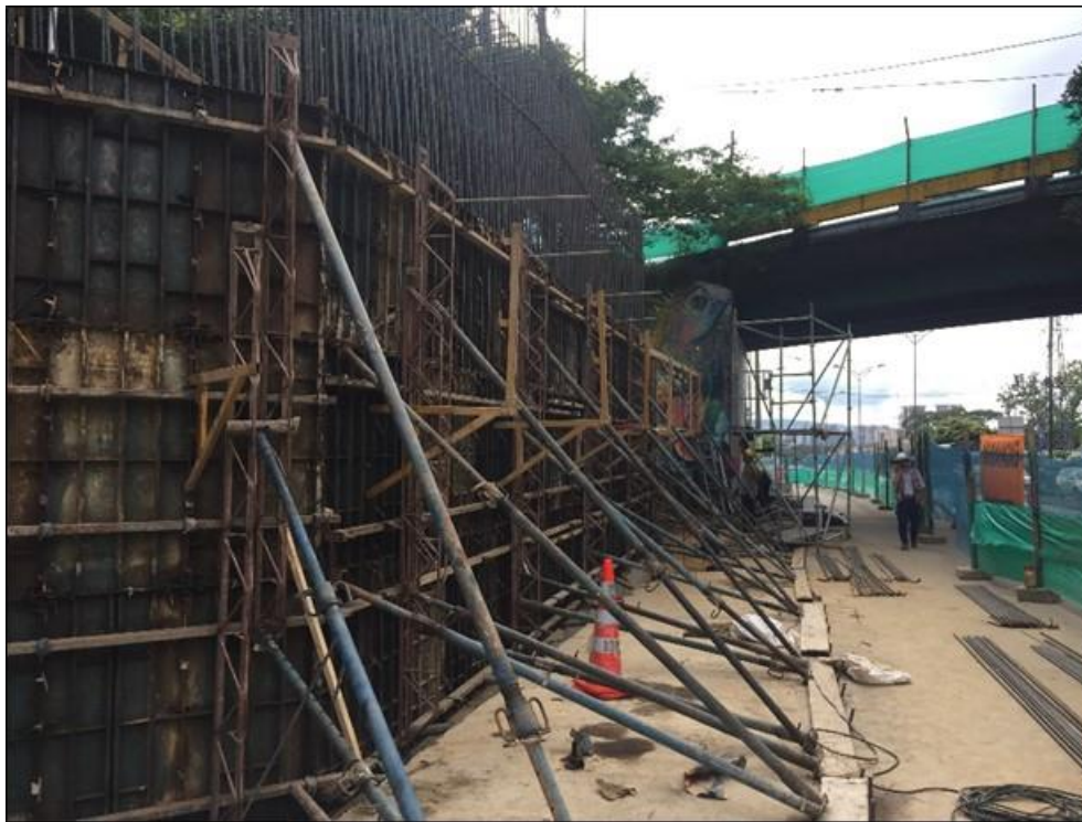
Fotografía 27. Formaleta Estribo puente sur.
