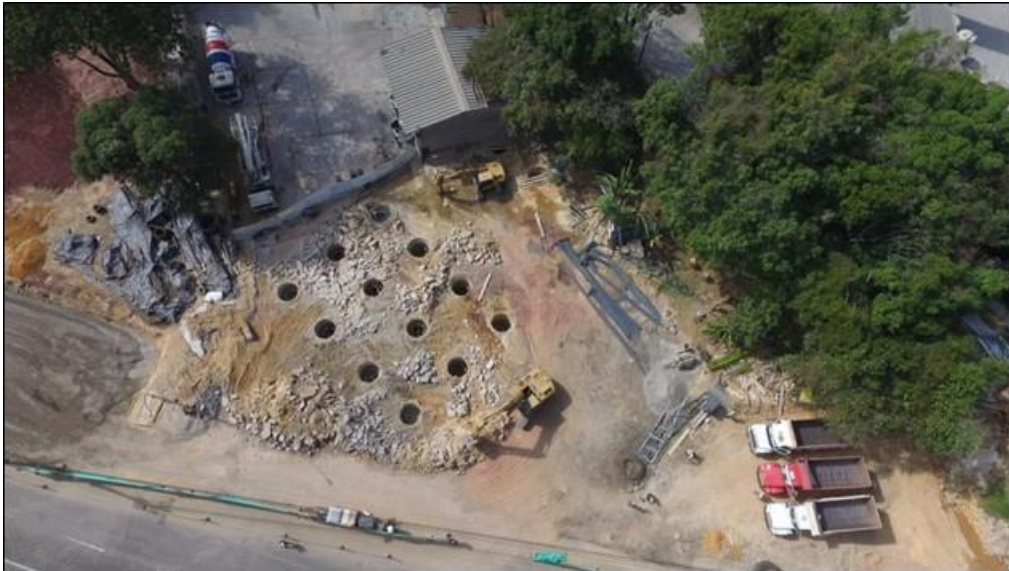
Fotografía 42. Caissons Costado occidental.
