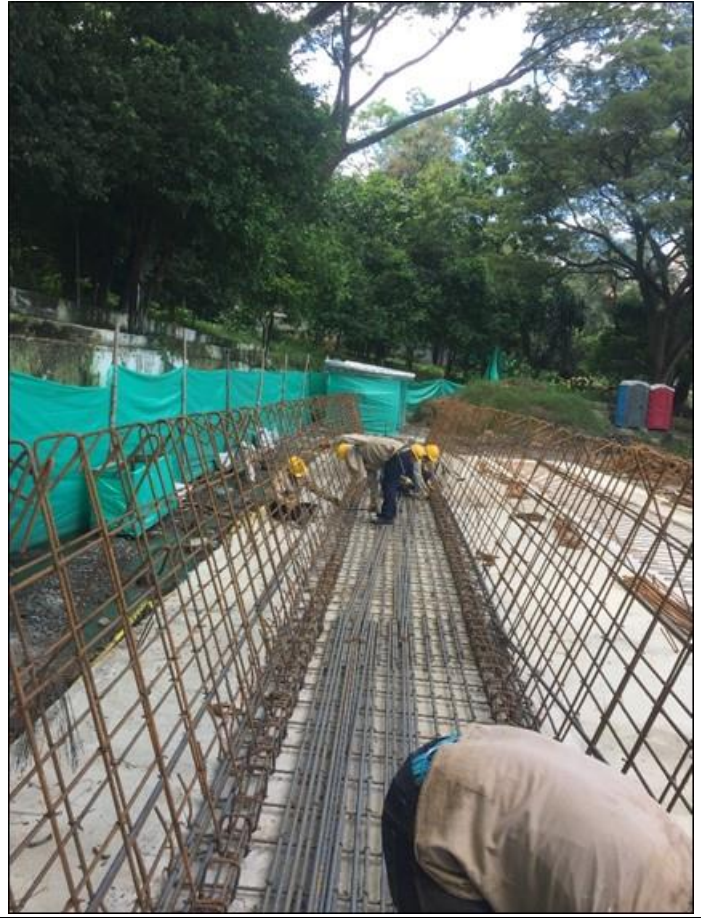
Fotografía 35. Armado losa inferior viga Pos tensada.
