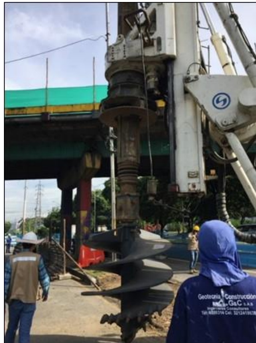
Fotografía 5. Tornillo rotatorio.
