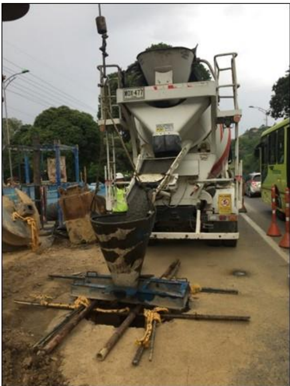
Fotografía 14. Fundido pilote central
