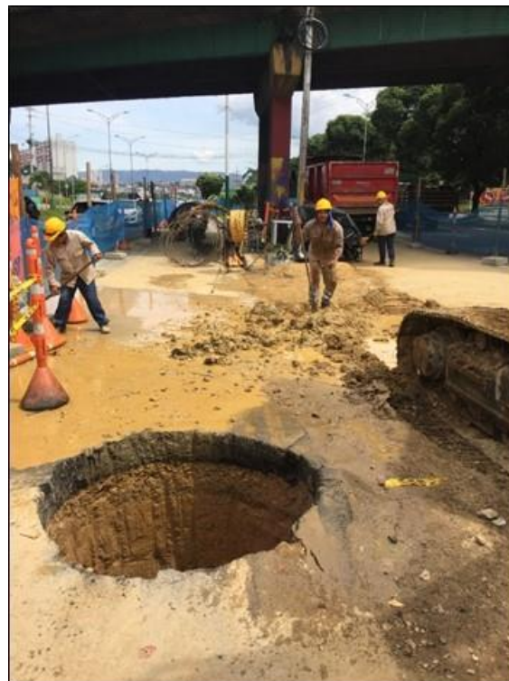
Fotografía 6. Pilote excavado.
