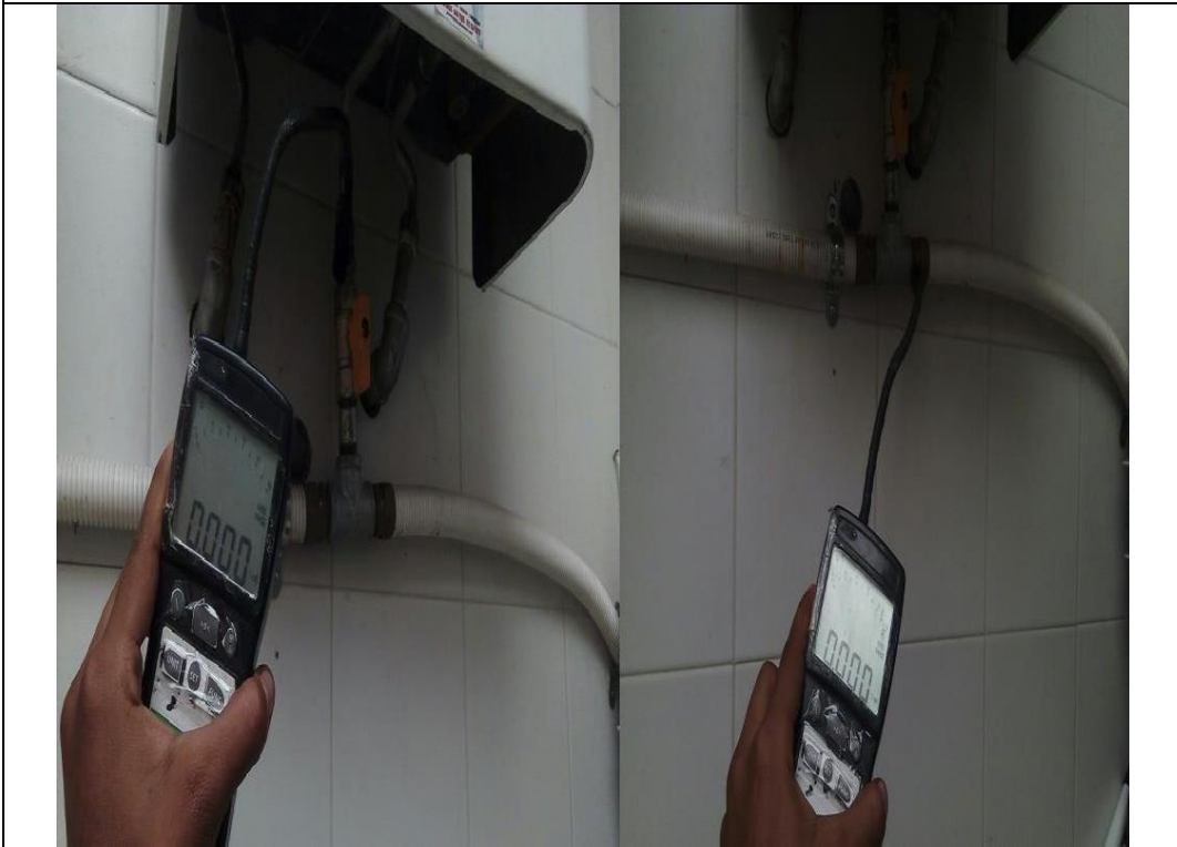
Ilustración 15. Revisión fuga en uniones Instalación tubería para Calentador
