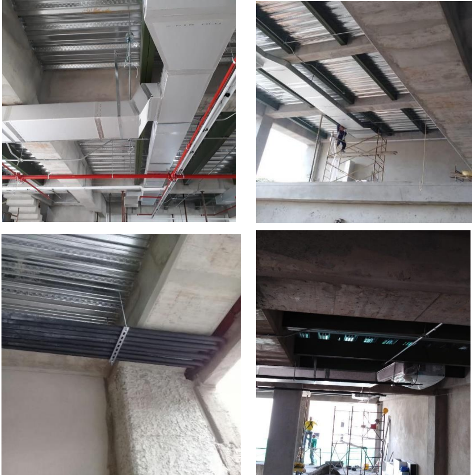
Ilustración 10. Instalaciones ductos últimos pisos e intervención estructural.
