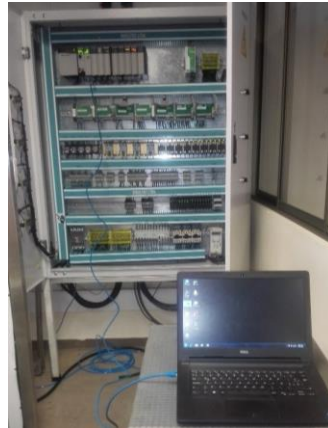
Figura 36. Conexión punto a punto PLC a computador
