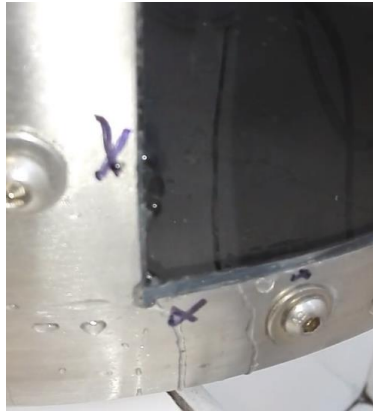
Figura 8. Fuga hermética uno del tanque cuatro
