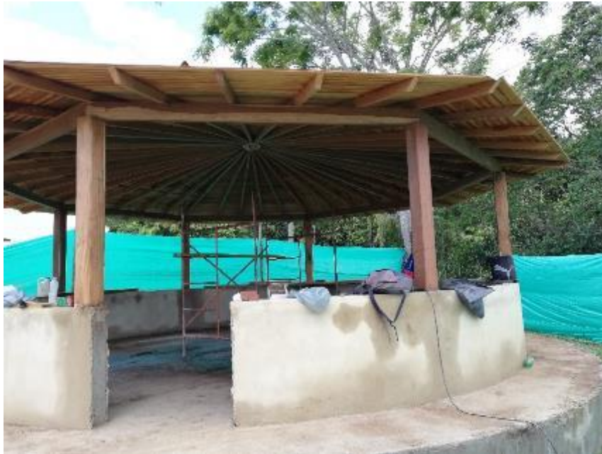
Imagen 22. Instalación de cubierta del Quiosco Lucas Caballero Fuente: Elaboración propia – Visita a obra.
