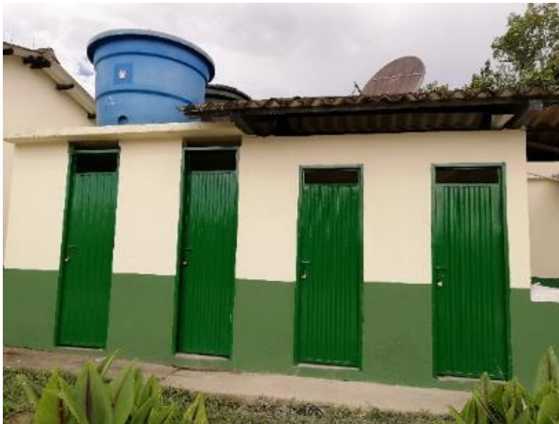
Imagen 29. Fachada final de los baños de la Escuela Santa Rita Fuente: Elaboración propia – Visita a obra.
