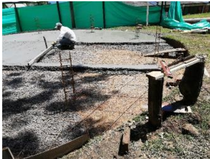
Imagen 18. Construcción de placa de contrapiso del Quiosco Lucas Caballero
