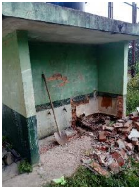
Imagen 2. Demolición y limpieza de la Escuela Tres Esquinas
