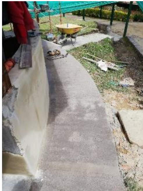
Imagen 21. Enchape de muro perimetral del Quiosco Lucas Caballero Fuente: Elaboración propia – Visita a obra.
