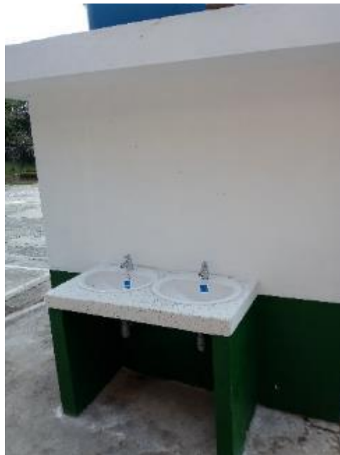
Imagen 4. Fachada terminada de los lavamanos en la Escuela Tres Esquinas Fuente: Elaboración propia – Visita a obra.
