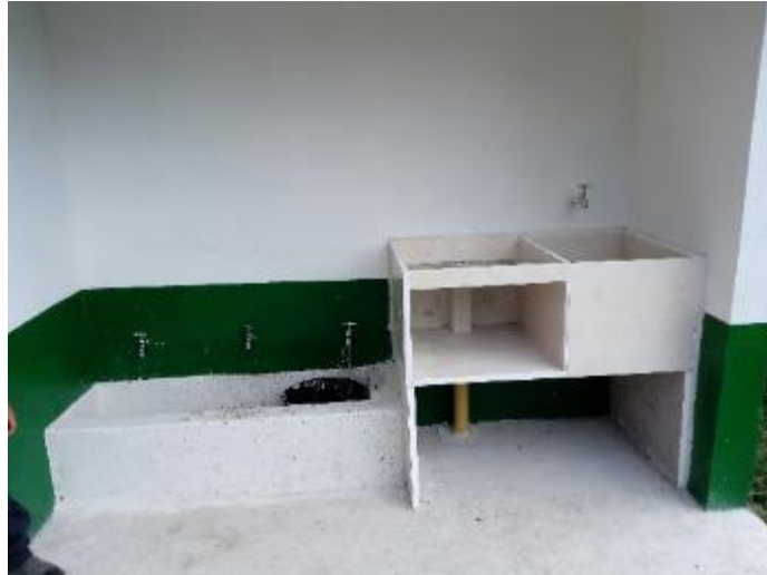
Imagen 3. Fachada terminada de la zona de lavado en la Escuela Tres Esquinas Fuente: Elaboración propia – Visita a obra.
