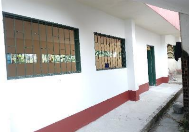
Imagen 14. Fachada terminada en el Restaurante escolar San José de Suaita
