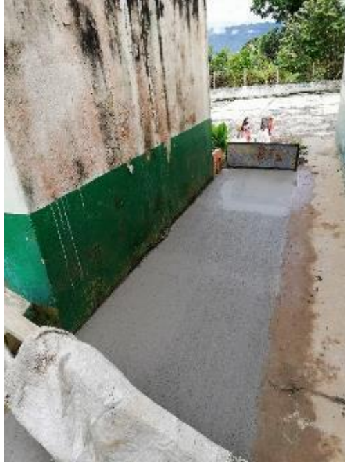
Imagen 26. Fachada final en la zona de lavado de la Escuela Santa Rita Fuente: Elaboración propia – Visita a obra.
