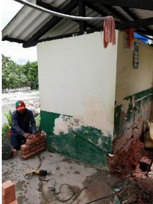
Imagen 25. Construcción de muro en mampostería de la Escuela Santa Rita Fuente: Elaboración propia – Visita a obra.
