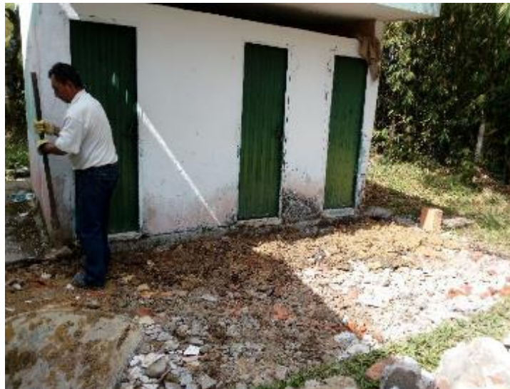
Imagen 6. Demolición y limpieza de los baños de la Escuela El Tambor Fuente: Elaboración propia – Visita a obra.
