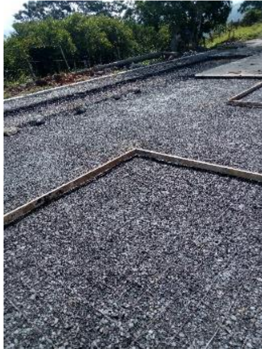
Imagen 16. Instalación de refuerzo y formaletas para la placa de cancha en la Escuela El Salitre
