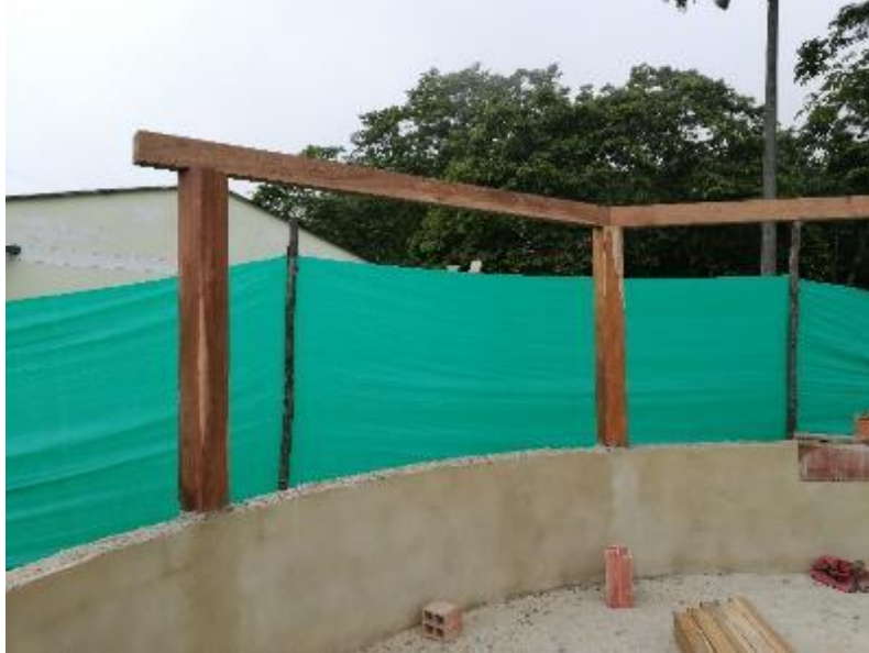
Imagen 20. Pórtico en madera para cubierta del Quiosco Lucas Caballero Fuente: Elaboración propia – Visita a obra.
