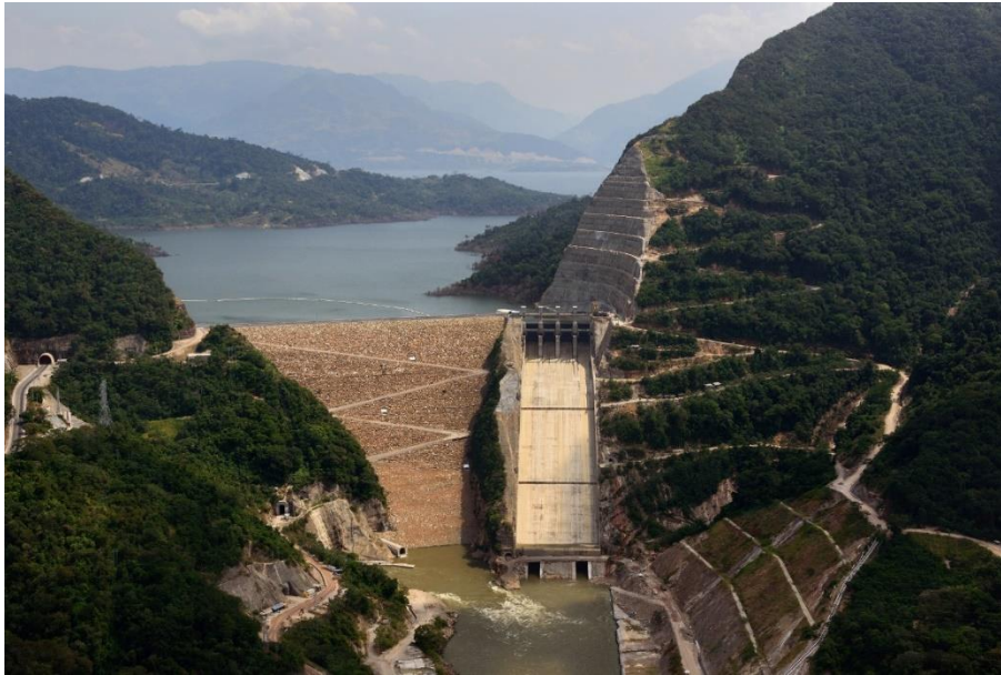
Imagen 41. Central hidroeléctrica Sogamoso.
