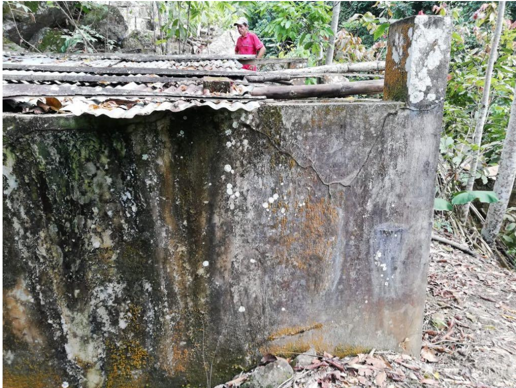
Imagen 24. Estructura de desarenador.
