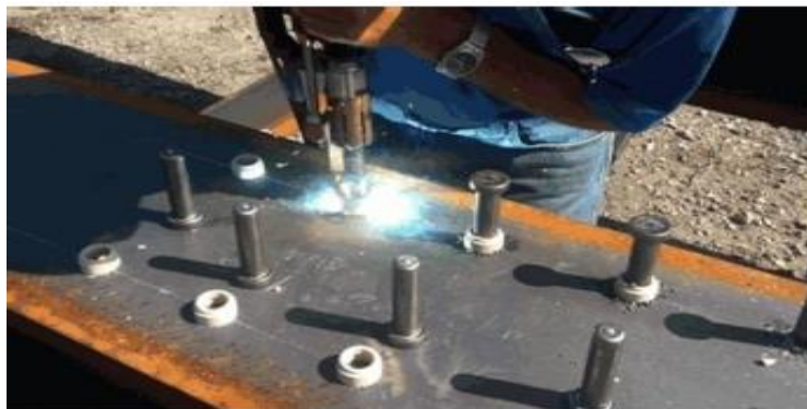
Ilustración 7. Conectores cortantes.
