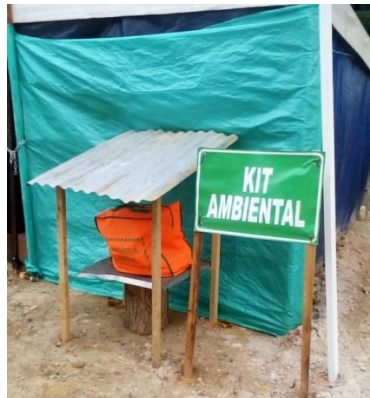
Figura 4. Kit para atención de derrames en Patio taller.
