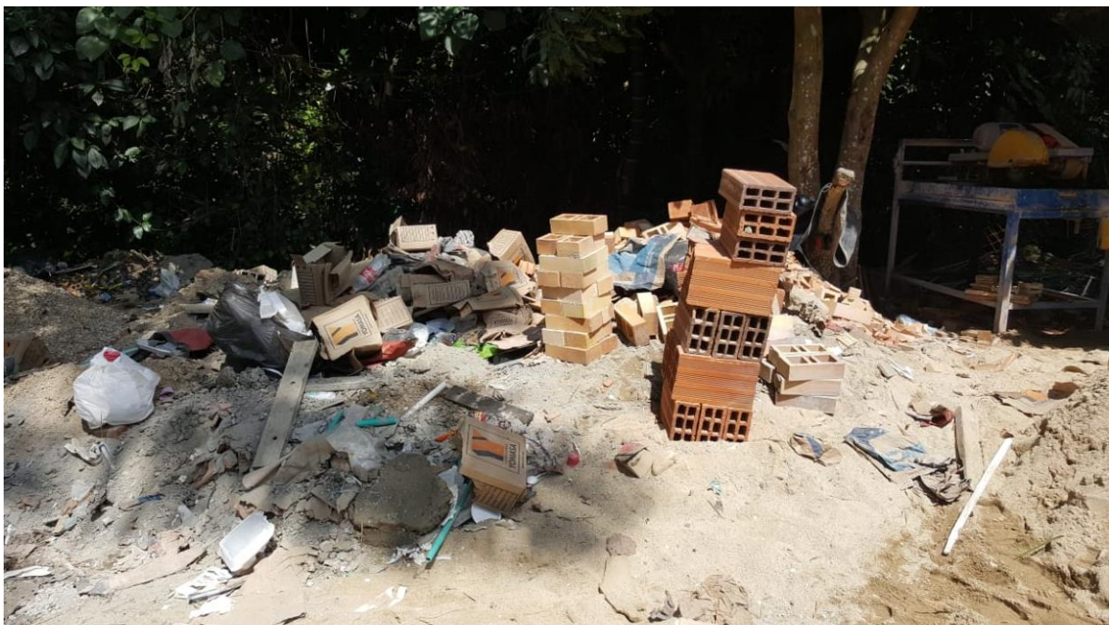
Figura 5 Acumulación de diferentes tipos de residuos, mezclados con material en buenas condiciones
