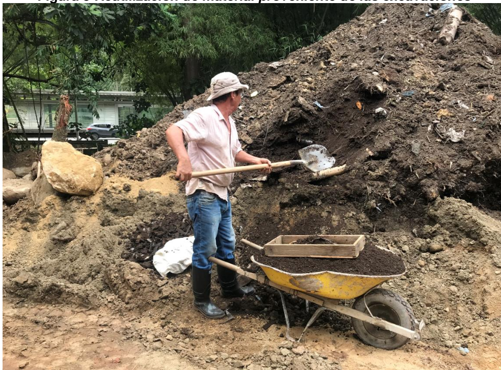
Figura 3 Reutilización de material proveniente de las excavaciones
