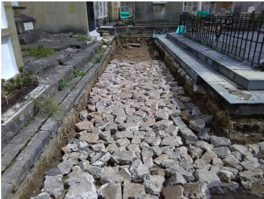
Fuente. Edificación de Patrimonio Nacional y Cultural, Barrio Santa Fe, Localidad Los mártires, Bogotá D.C.
