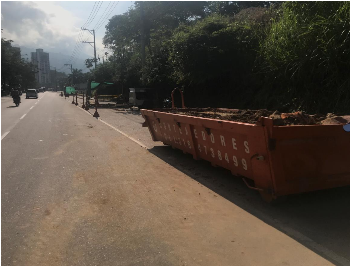
Figura 8 Almacenamiento de RCD en contenedor
