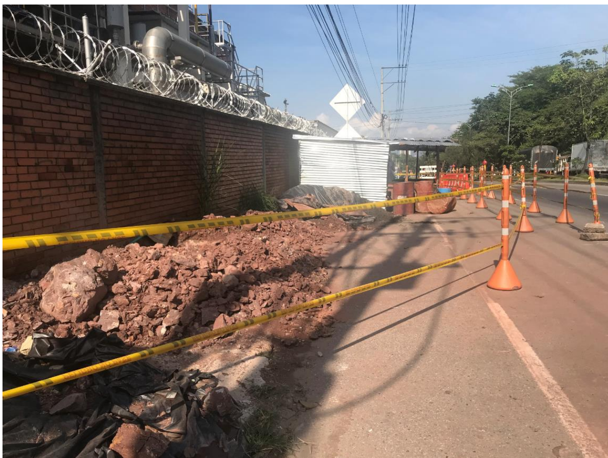
Figura 9 Acopio de RCD
