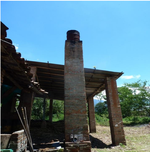
Figura 4.2.2 Fotografía de la chimenea del horno
