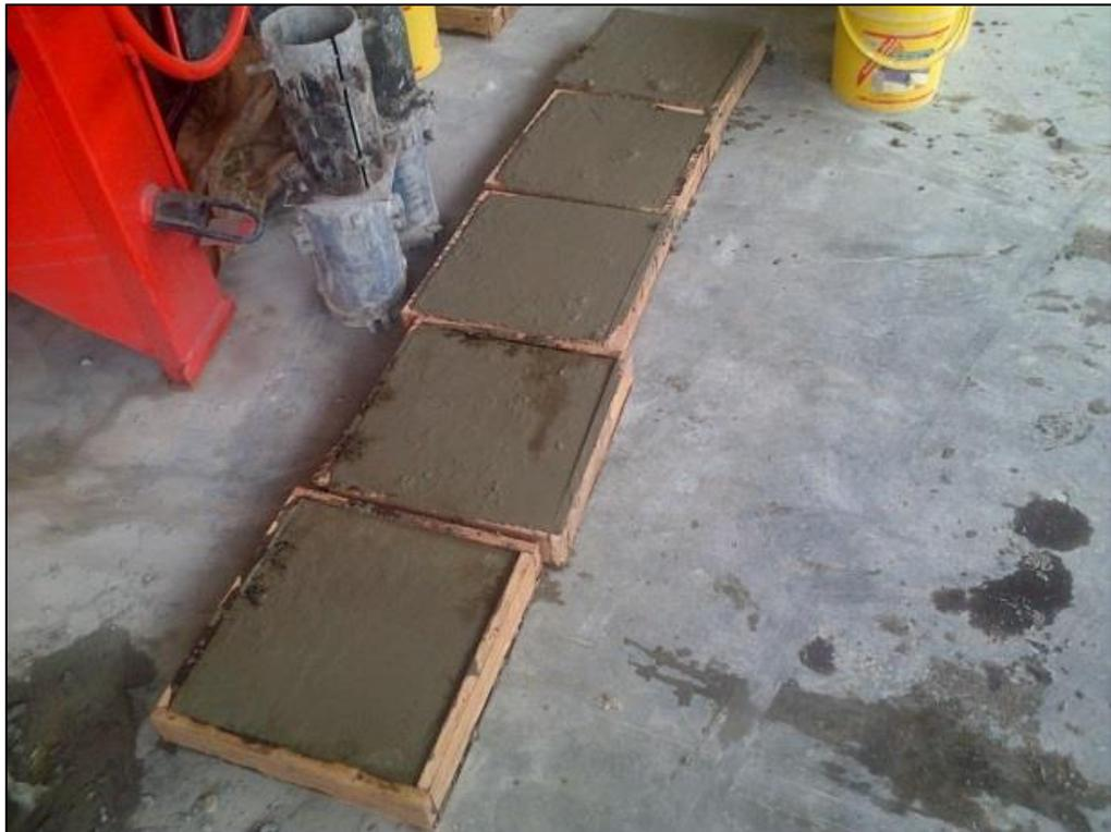
**Figura 21. Elaboración de losetas prefabricas con molde de madera.**
