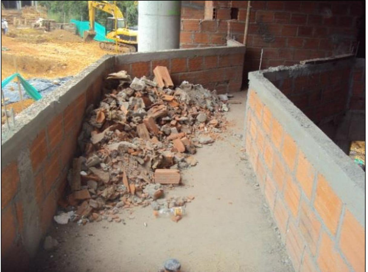
**Figura 11. Residuos generados por la construcción de una edificación.**
