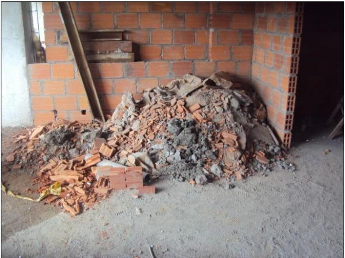
**Figura 10. Escombros compuestos de mampostería, mortero y madera**
