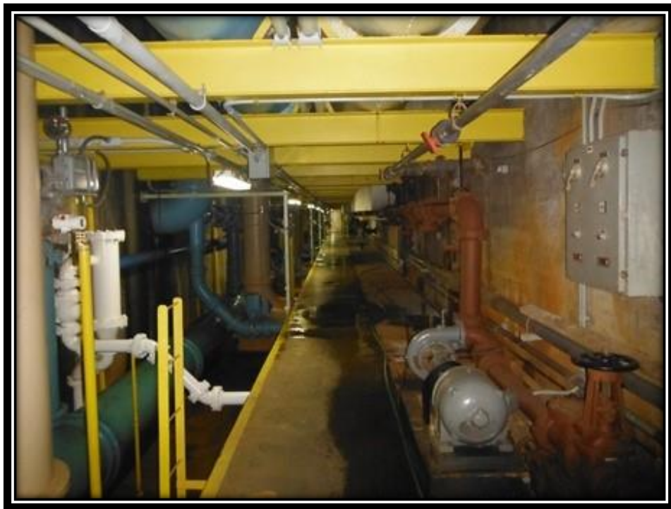
Figura 10: Galería inferior de filtración - Zona para la instalación de los reactores de desinfección (última etapa de la potabilización)
