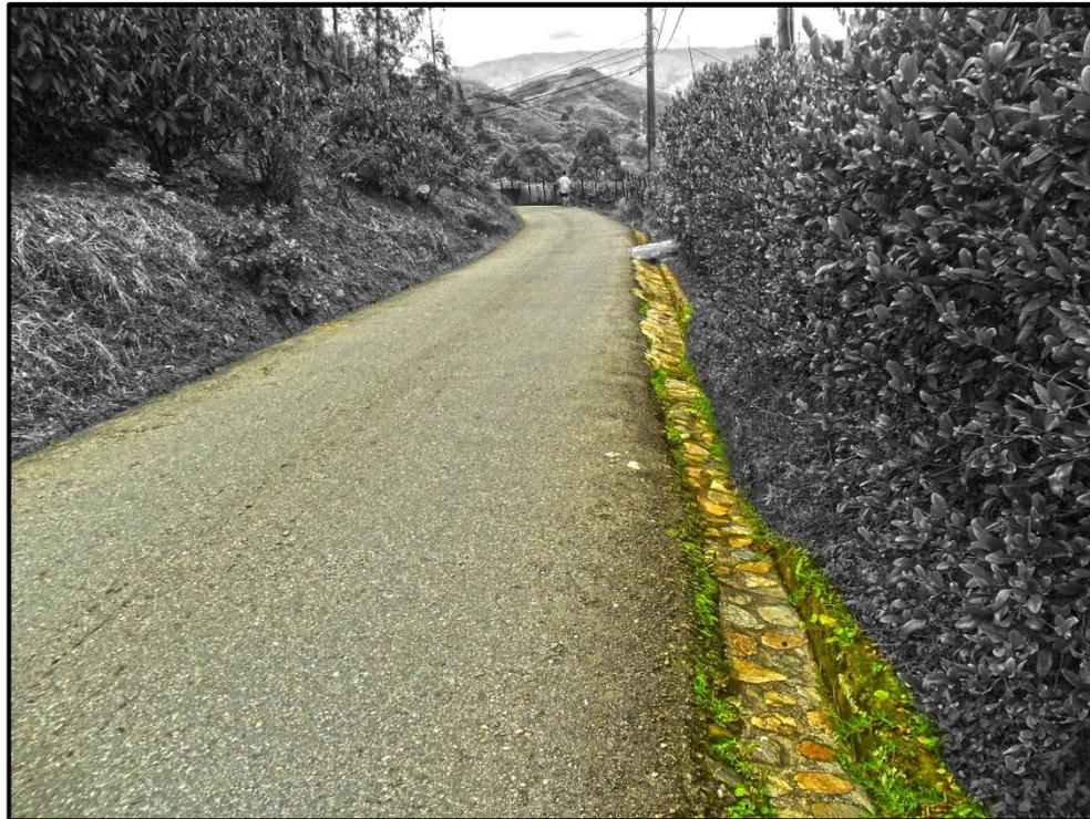
Fotografía 36: Superposición de la vía asfaltada a una carpeta de rodadura en piedra
