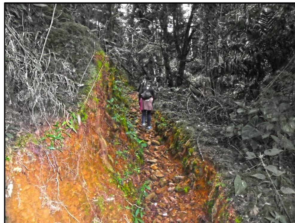
Fotografía 9: Camino de Guaca, banca con conformación en "U"
