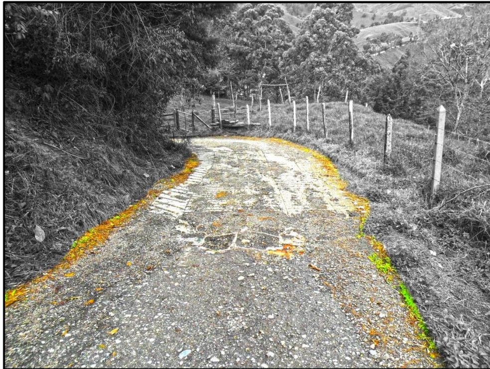
Fotografía 20: Superposición de carretera asfáltica a rieles de concreto
