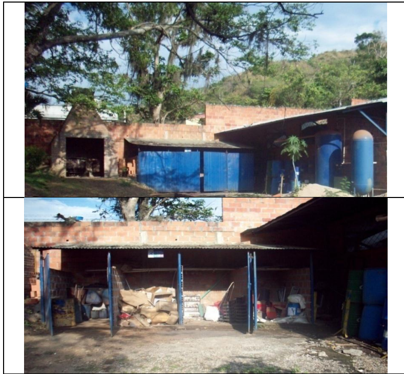
Foto 5. Unidad de Almacenamiento Temporal de Residuos
