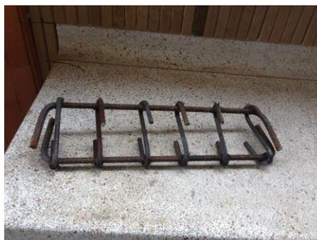
**Figura 13. Figurado de las Varillas de Acero de Refuerzo.**
