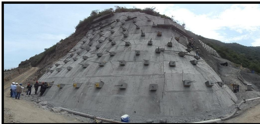
FOTOGRAFIA 99. Culminación de fundida y comienzo de tensionamiento
