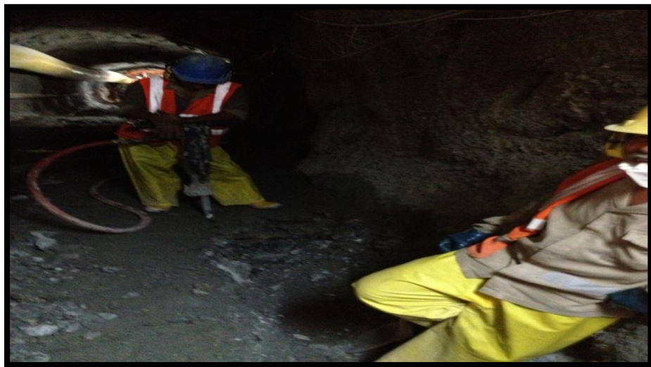
FOTOGRAFIA 18. Excavación de canaleta Túnel de Aducción.
