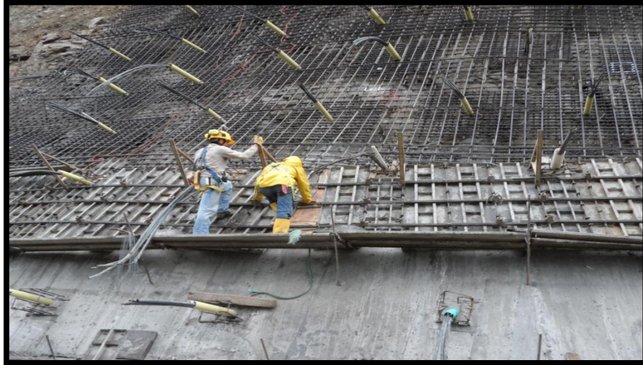
FOTOGRAFIA 92. Fundida del primer tramo
