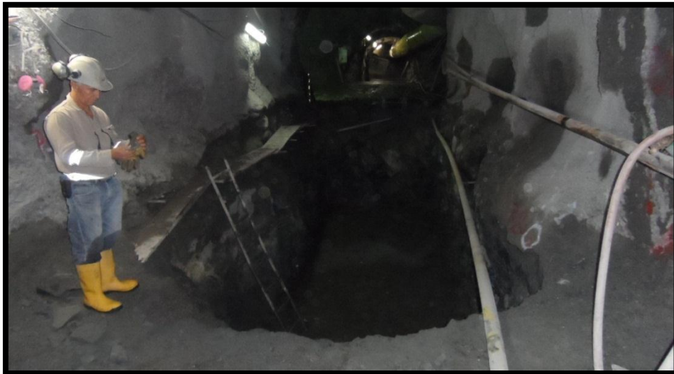
FOTOGRAFIA 17. Se realiza solado en el atraque de la tubería
