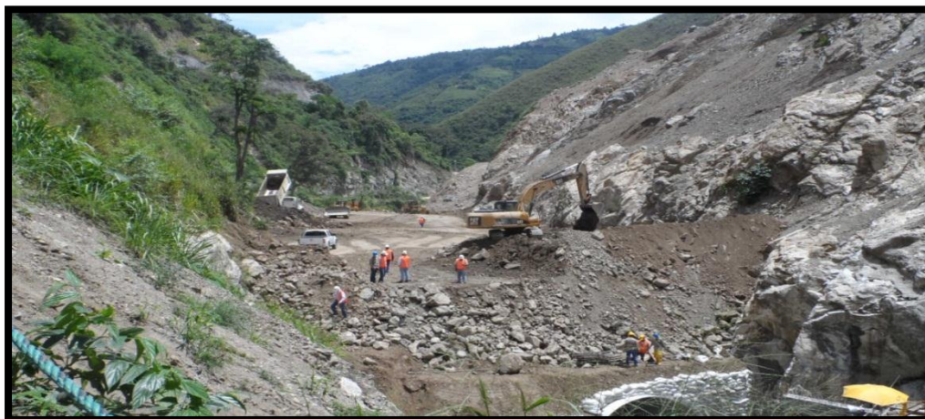
FOTOGRAFIA 129. Primer lanzado de material en la plataforma
