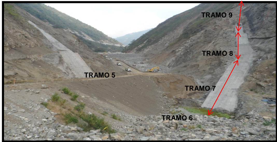
FOTOGRAFIA 49. Concreto de recuperación Plinto de los tramos 8 y 9
