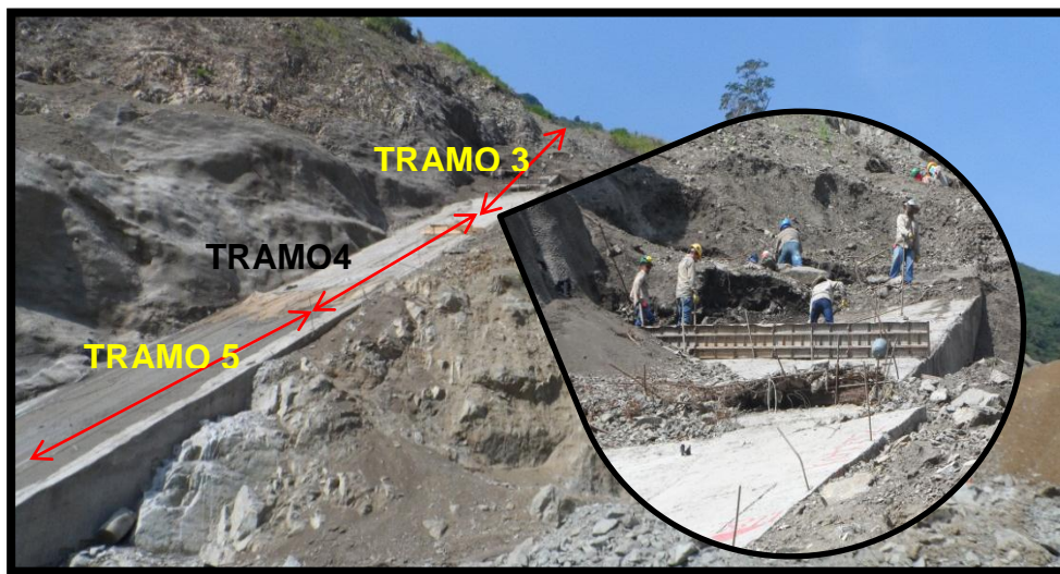
FOTOGRAFIA 48. Limpieza del Plinto tramos 3 y 4
