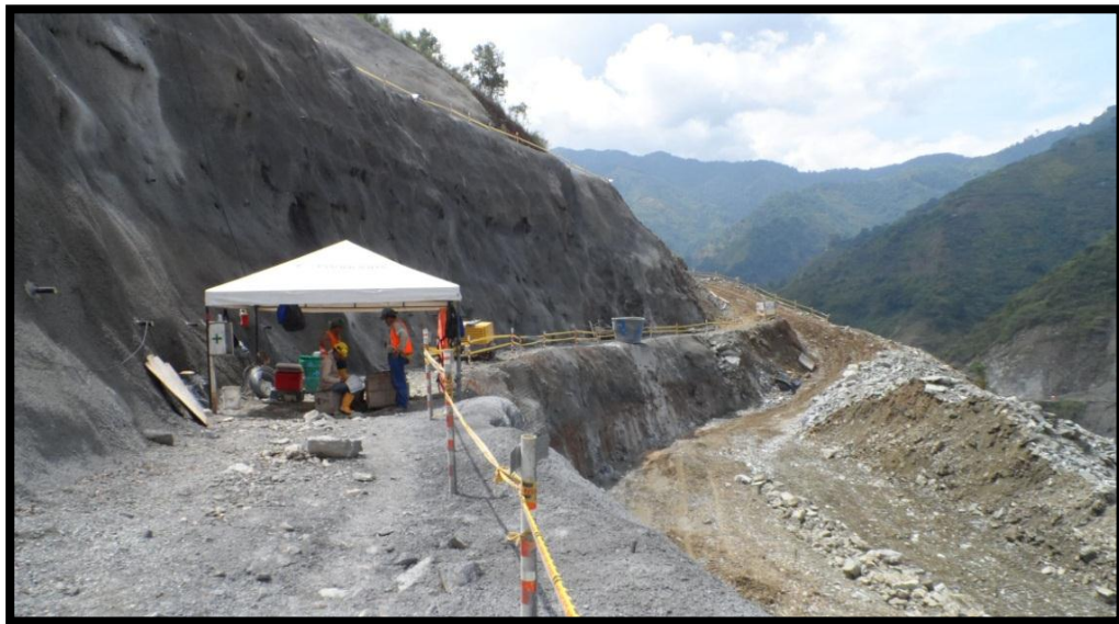
FOTOGRAFIA 26. Excavación del talud para llegar a la tercera berma.
