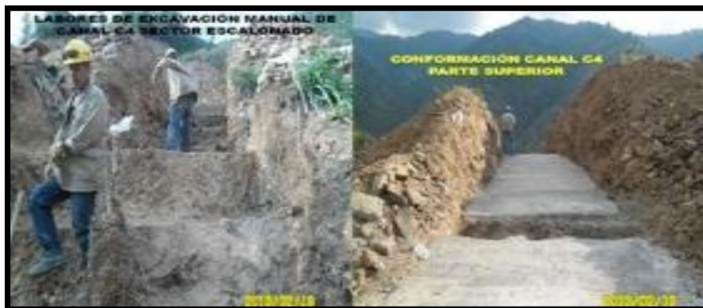
FOTOGRAFIA 74. Excavación de Canal C4.
