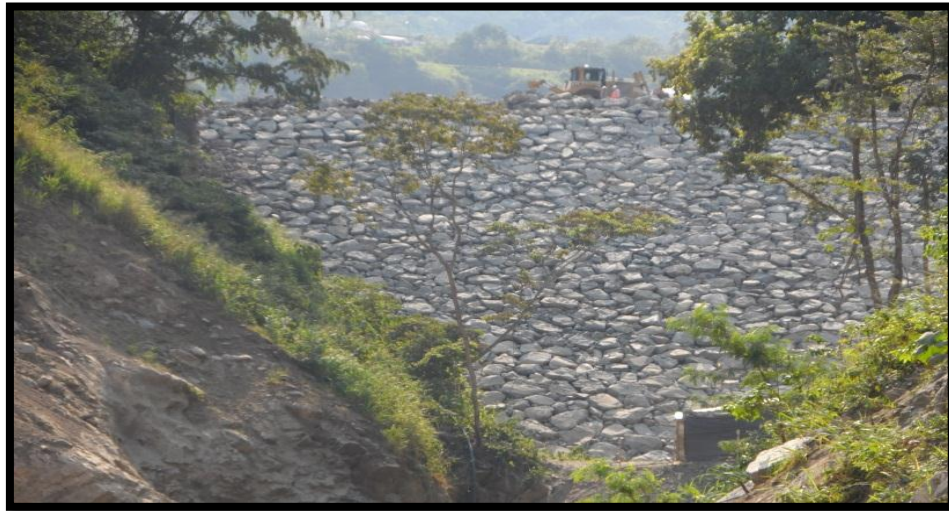
FOTOGRAFIA 36. Conformación de material Tipo 4 RIP RAP
