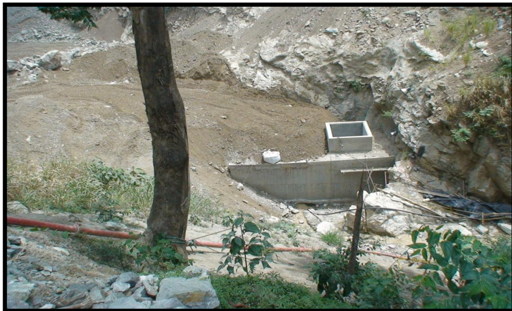
FOTOGRAFIA 131. Transición terminada y empalmada con la tubería ARMCO
