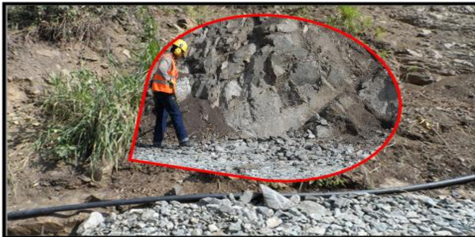
FOTOGRAFIA 32. Limpieza de estribos en la presa
