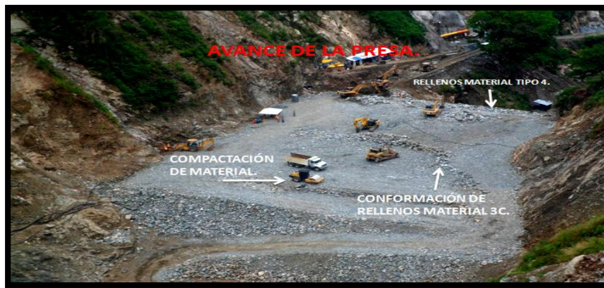
FOTOGRAFIA 30. Avance de llenos de la Presa
