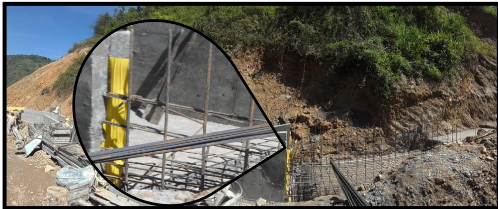
FOTOGRAFIA 84. Junta de construcción, cinta de PVC B15.
