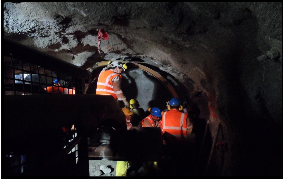
FOTOGRAFIA 14. Colocación de malla en el K0+020
