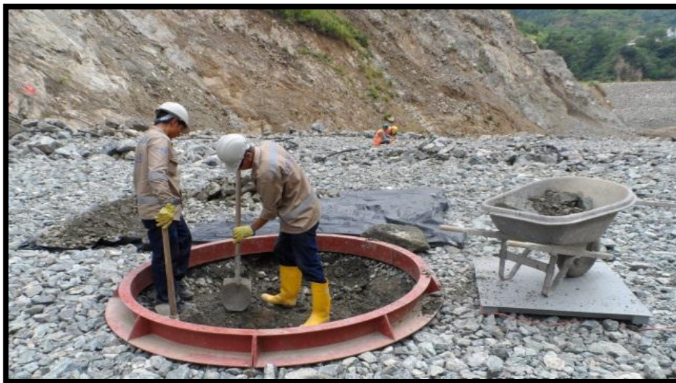
FOTOGRAFIA 37. Ensayo de densidad de campo, preparando terraplén
