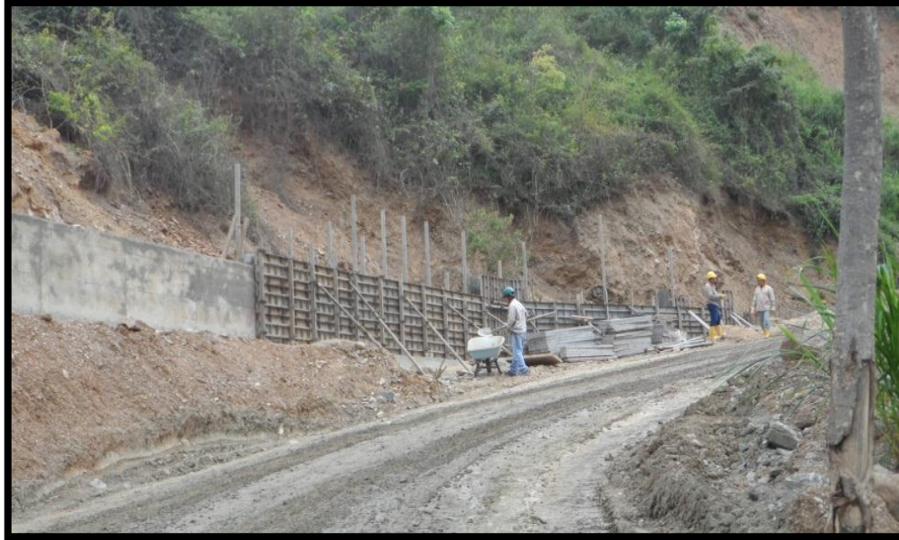
FOTOGRAFIA 79. Armado de formaletería para fundir.
