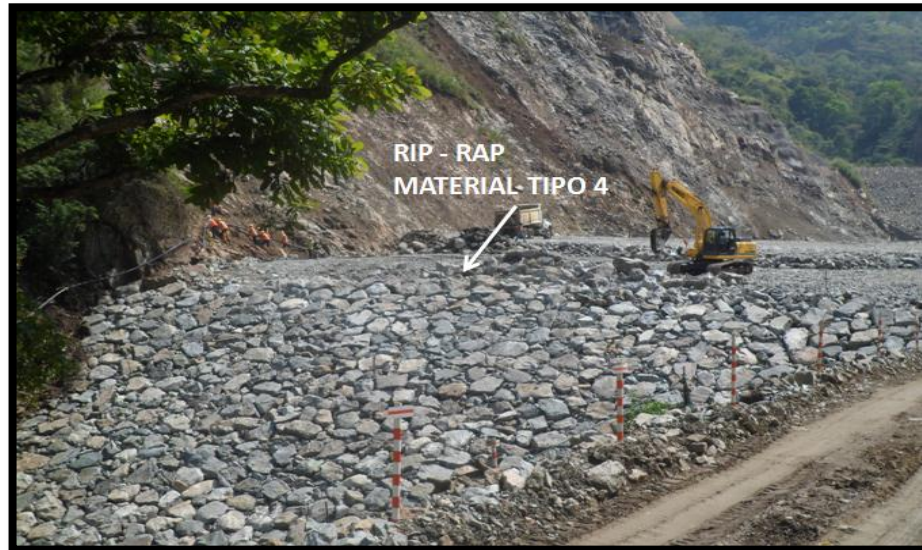
FOTOGRAFIA 31. Conformación del material Tipo 4
