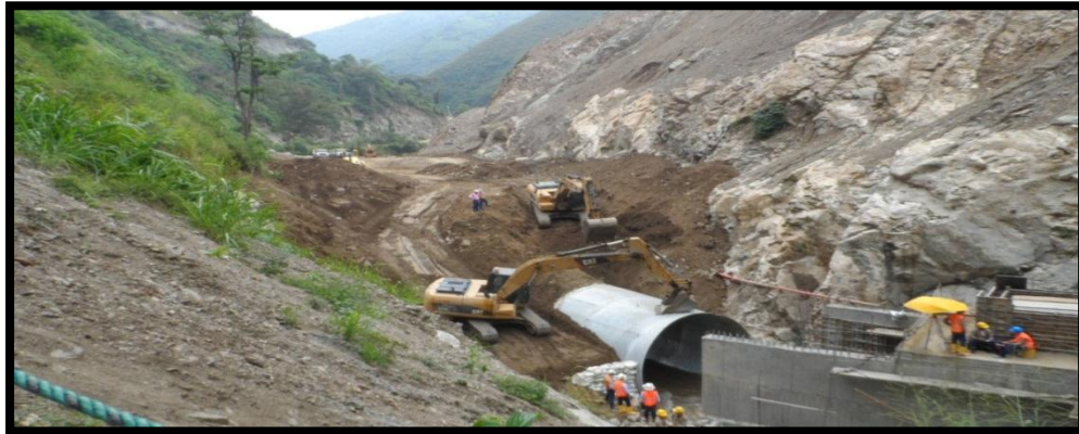
FOTOGRAFIA 127. Asegurando la tubería y colocando terraza para empalmar
