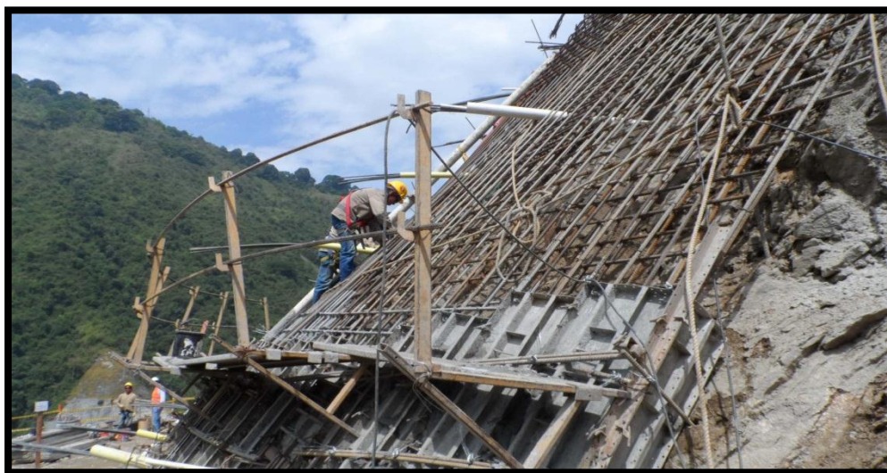
FOTOGRAFIA 95. Armado formaletería costado derecho
