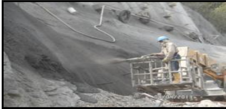
FOTOGRAFIA 108. Lanzado de Concreto Portal Oriental Parte Baja
