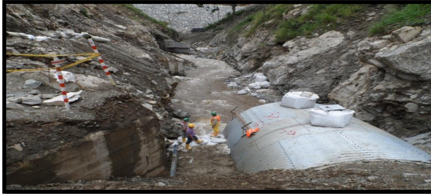
FOTOGRAFIA 121. Avance del entubamiento del río Tona
