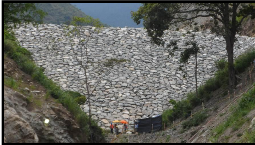
FOTOGRAFIA 1. Cara de Enrocado Rip Rap.
