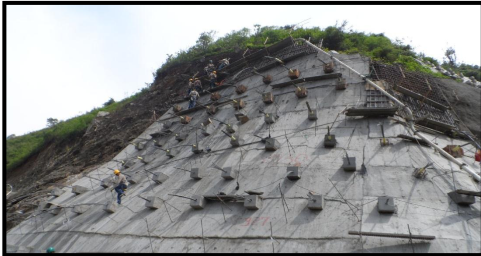
FOTOGRAFIA 98. Pantalla del Morning Glory con dados sin tensionar
