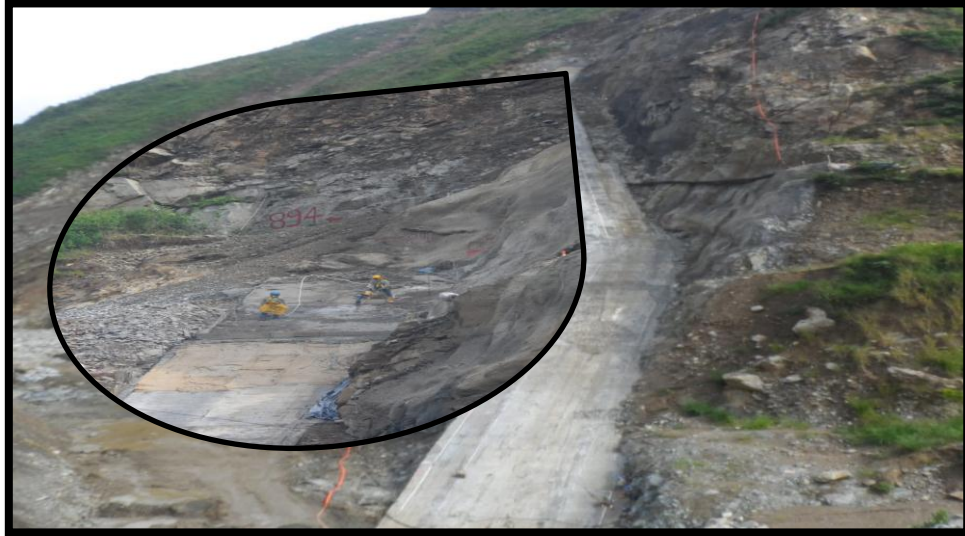
FOTOGRAFIA 51. Colocación de concreto Plinto tramo 9
