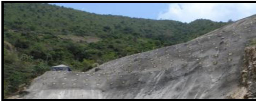
FOTOGRAFIA 63. Trabajos de Estabilización Terminados
