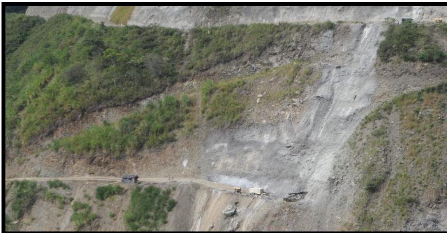
FOTOGRAFIA 69. Perforaciones de anclajes y drenajes
