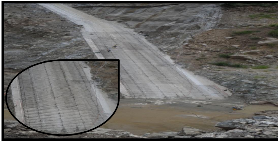
FOTOGRAFIA 52. Armado de acero de refuerzo inferior de Plinto Tramo 7
