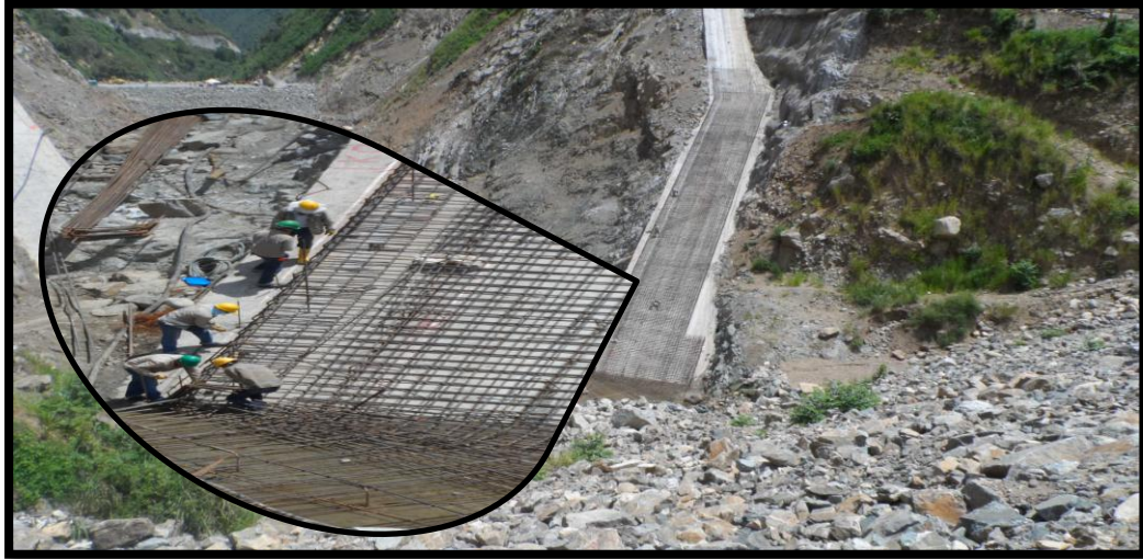
FOTOGRAFIA 54. Armado de acero de refuerzo inferior de Plinto Tramo 8
