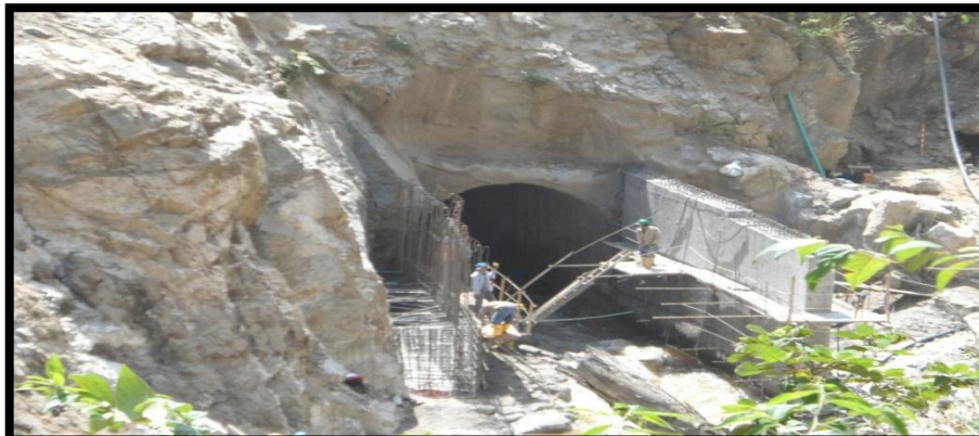
FOTOGRAFIA 120. Avance en la estructura de transición
