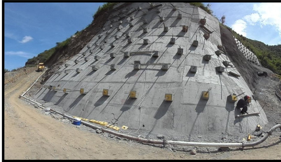
FOTOGRAFIA 100. Continuación de Tensionamiento de dados
