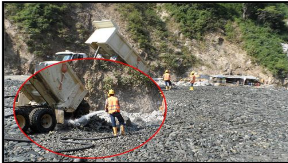
FOTOGRAFIA 35. Lavado de material para llenos de la Presa
