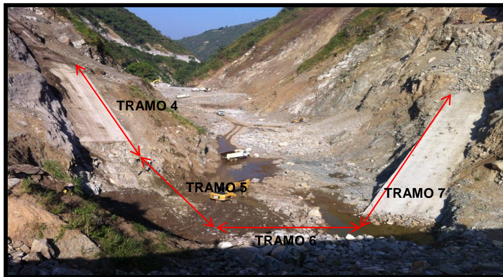
FOTOGRAFIA 43. Limpieza del Plinto tramos 4 y 5
