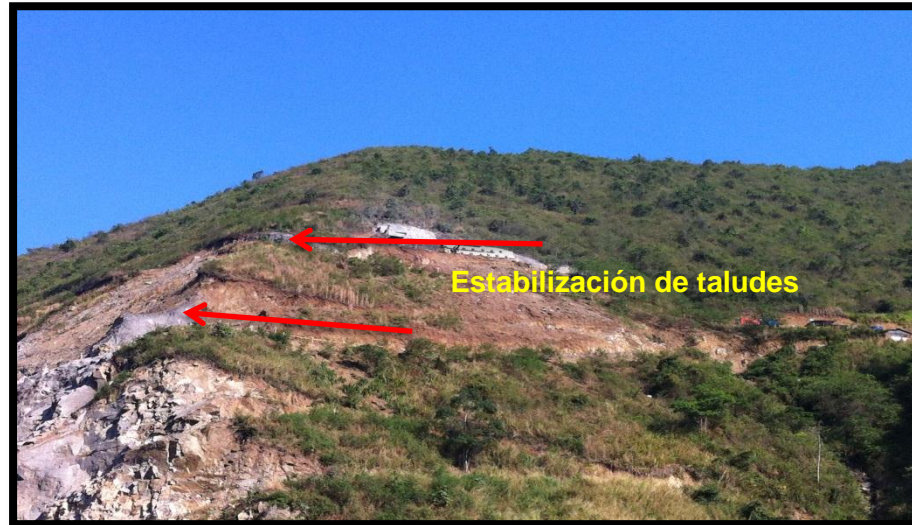
FOTOGRAFIA 88. Estabilización en el Morning Glory
