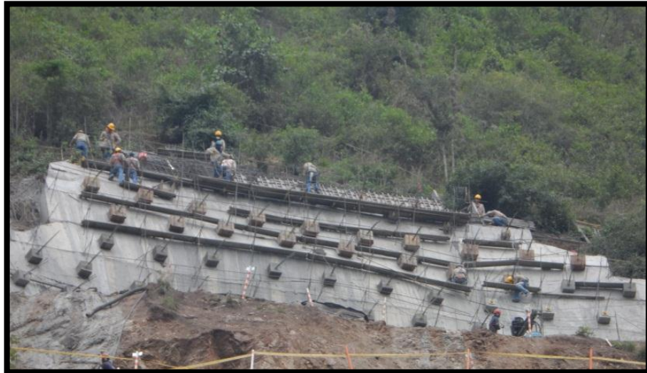
FOTOGRAFIA 106. Instalación de Dados Portal Oriental Túnel Vial.
