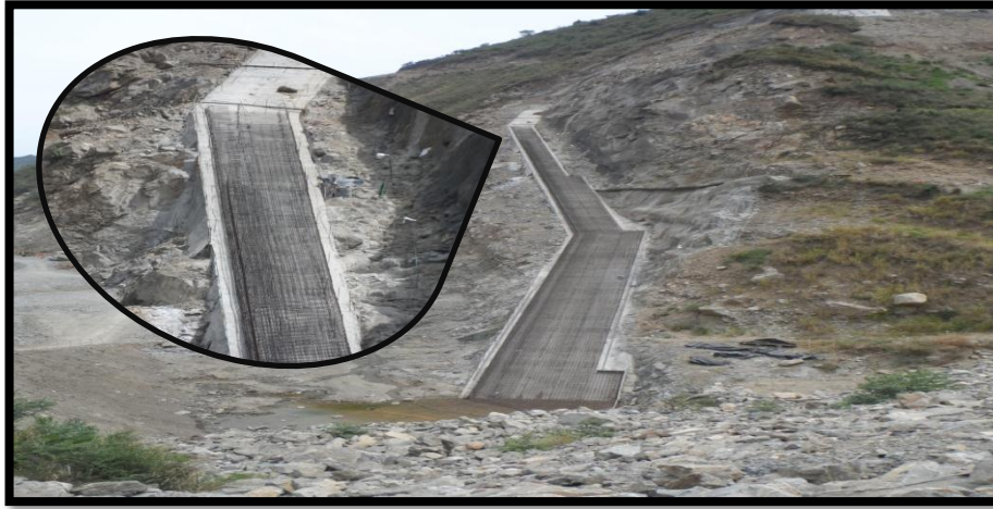
FOTOGRAFIA 55. Armado de acero superior del plinto tramo 8
