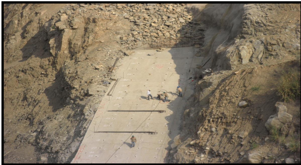
FOTOGRAFIA 46. Perforacion de anclajes en Plinto tamo 7
