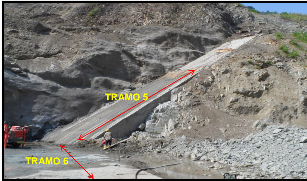
FOTOGRAFIA 47. Curado del concreto del Plinto de los tramos 5 y 6
