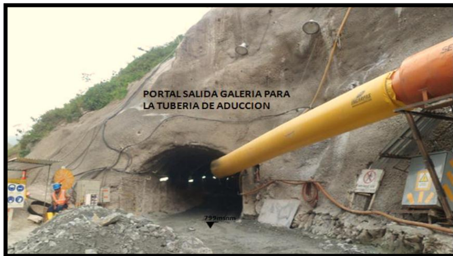
FOTOGRAFIA 7. Portal salida de la galería del túnel de aducción.
