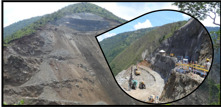
FOTOGRAFIA 29. Lanzado de material para llenos de la presa
