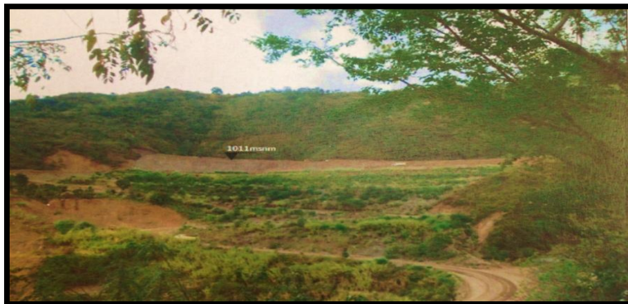
FOTOGRAFIA 73. Conformación y colocación de material de relleno ZODME
