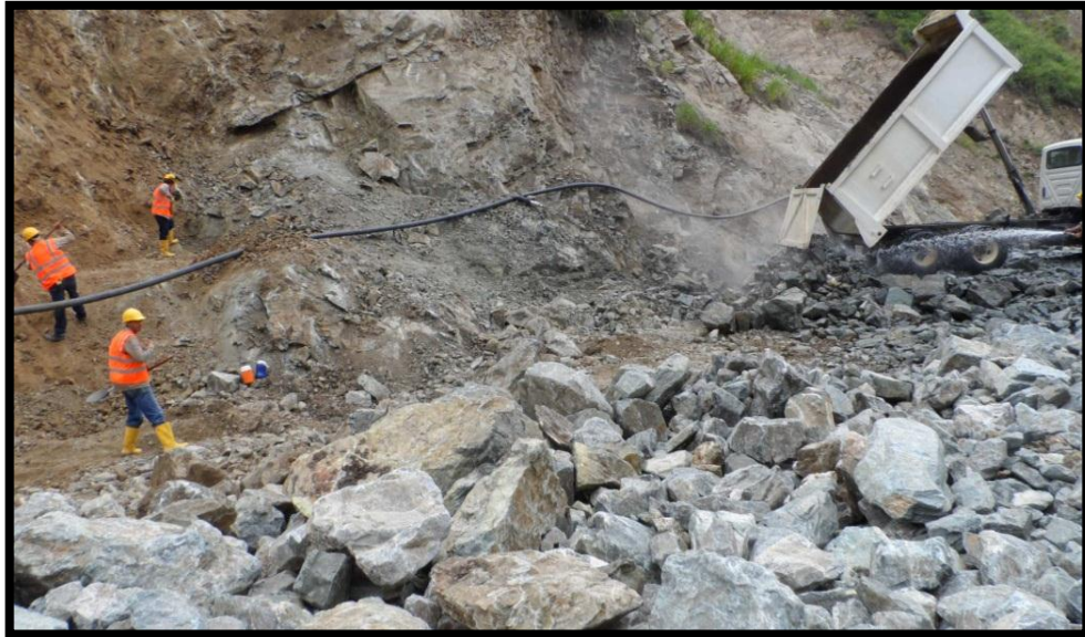
FOTOGRAFIA 41. Excavacion de material comun y limpieza estribo
