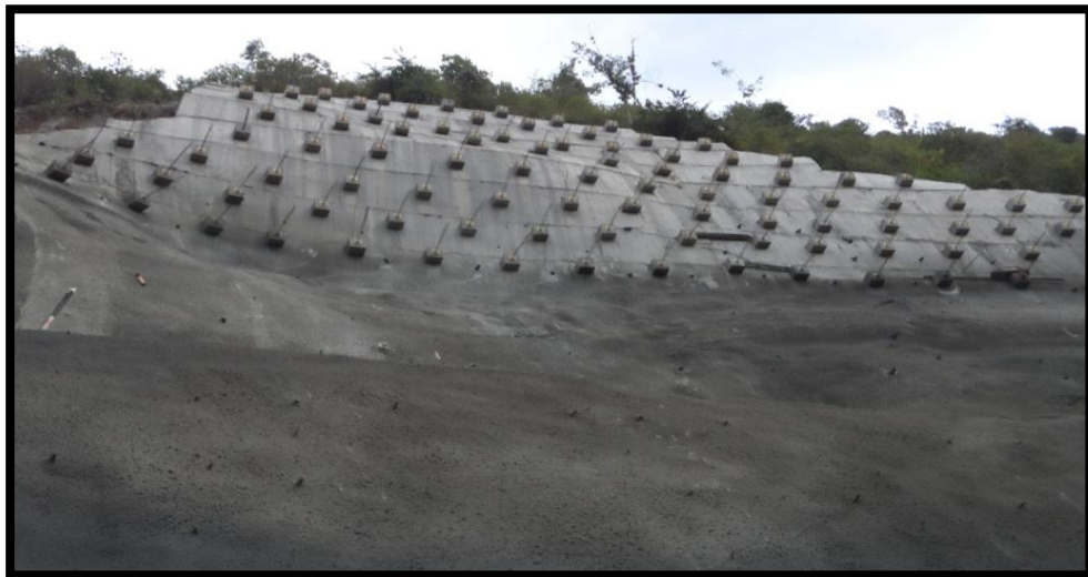
FOTOGRAFIA 107. Acabado Final del Portal Oriental Túnel Vial
