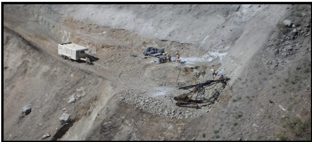
FOTOGRAFIA 71. Perforación de drenes y anclajes en la cota 845.9
