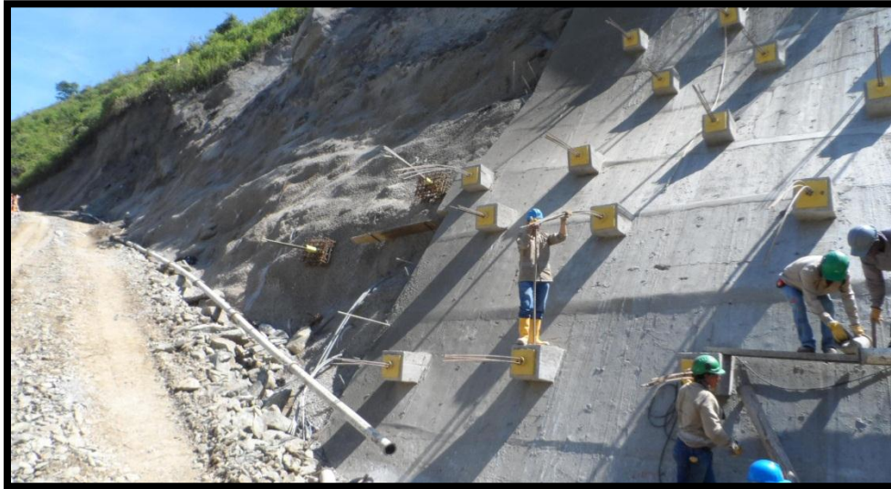
FOTOGRAFIA 104. Terminación de lanzado de concreto en parte occidental
