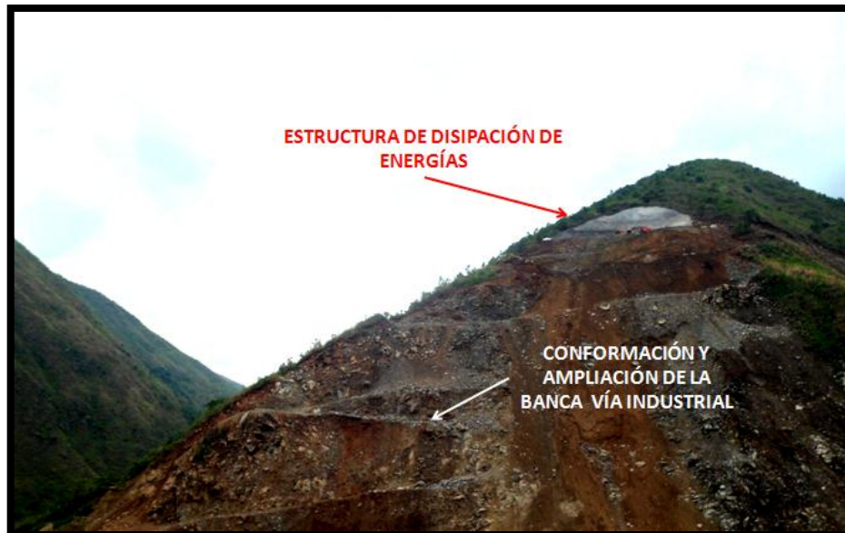
FOTOGRAFIA 22. Estado de la conformación de la banca de la vía industrial
