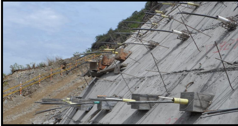
FOTOGRAFIA 96. Fundida y armado de dados en la pantalla
