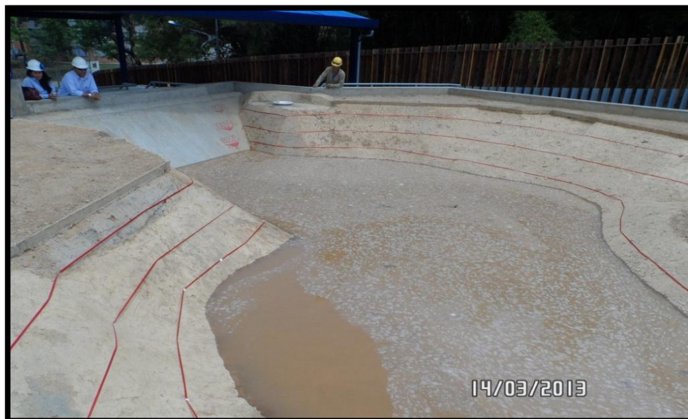
FOTOGRAFIA 136. Primer Llenado del Modelo Hidráulico
