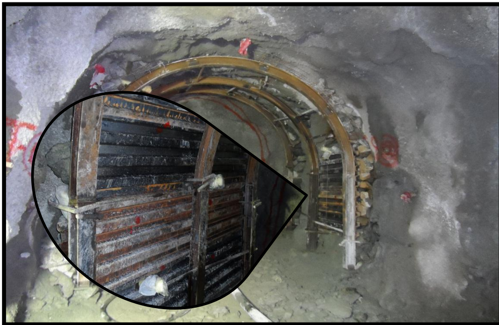
FOTOGRAFIA 15. Marcación para avance de excavación hasta la abscisa K0+060
