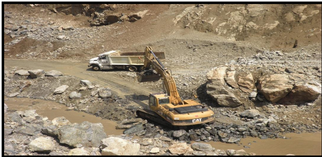
FOTOGRAFIA 64. Limpieza en el paso de las volquetas
