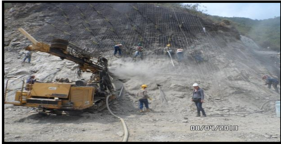
FOTOGRAFIA 90. Colocación de malla y rectificación de tendones
