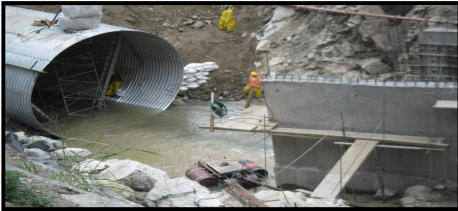
FOTOGRAFIA 126. Ventana de Inspección de la tubería.
