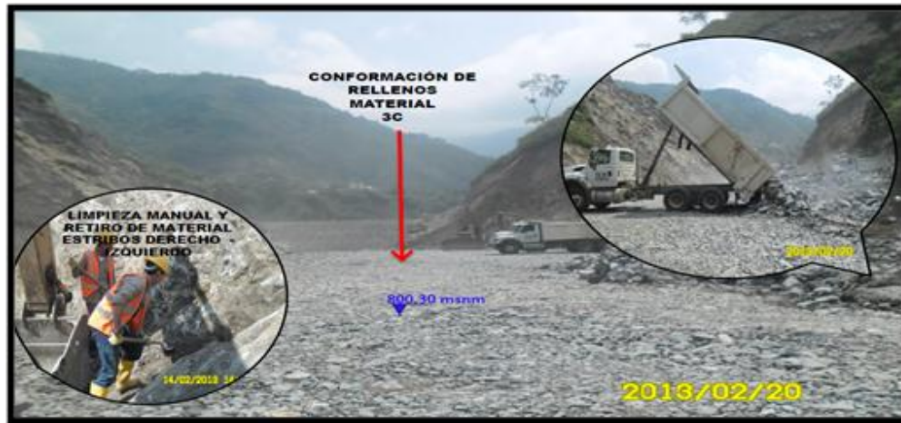
FOTOGRAFIA 33. Colocación de material 3C y Limpieza de estribo
