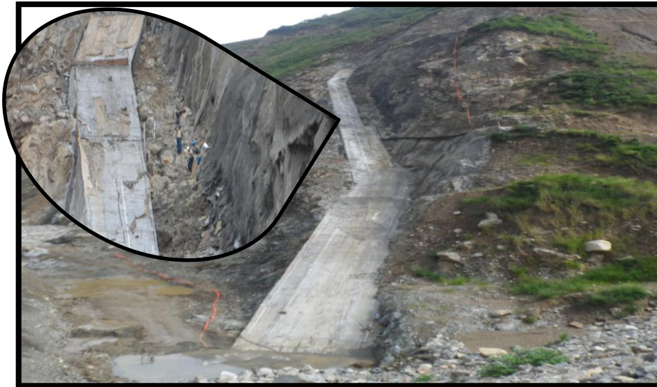
FOTOGRAFIA 50. Colocación de formaleta para nivelación Plinto Tramo 9
