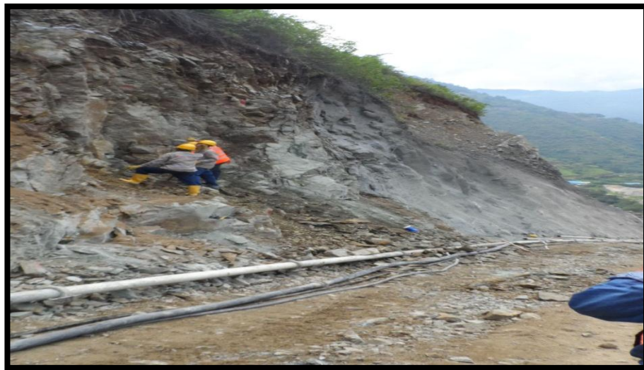
FOTOGRAFIA 102. Concreto Primario y limpieza para lanzado
