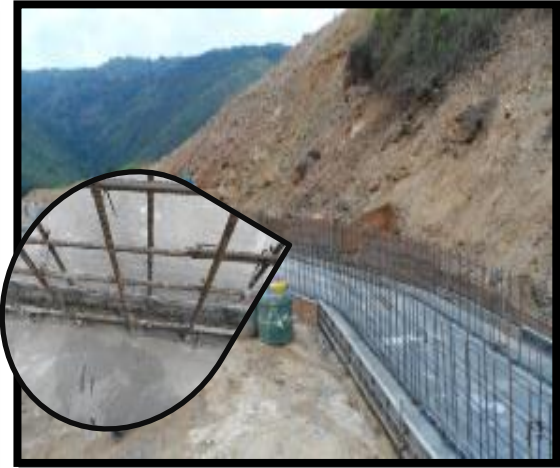
FOTOGRAFIA 75. Conformación del Canal C4.
