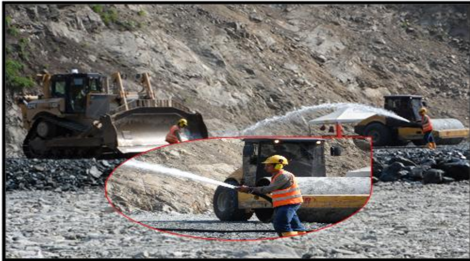
FOTOGRAFIA 34. Hidratación del material compactado
