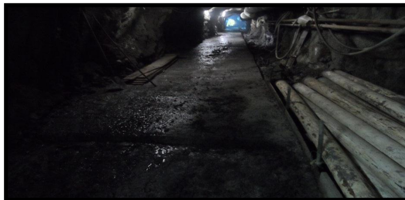
FOTOGRAFIA 13. Solado de nivelación Túnel de aducción
