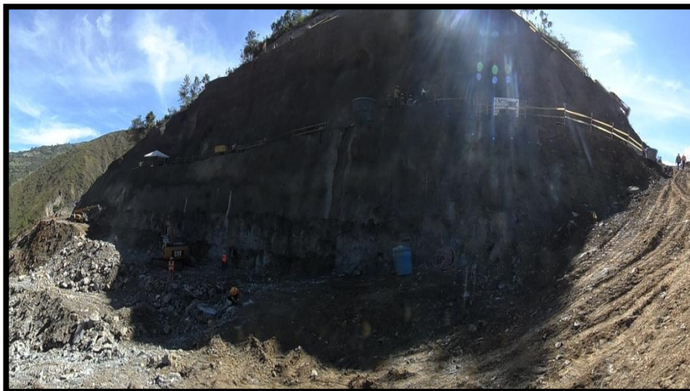
FOTOGRAFIA 28. Colocación de malla y concreto lanzado.
