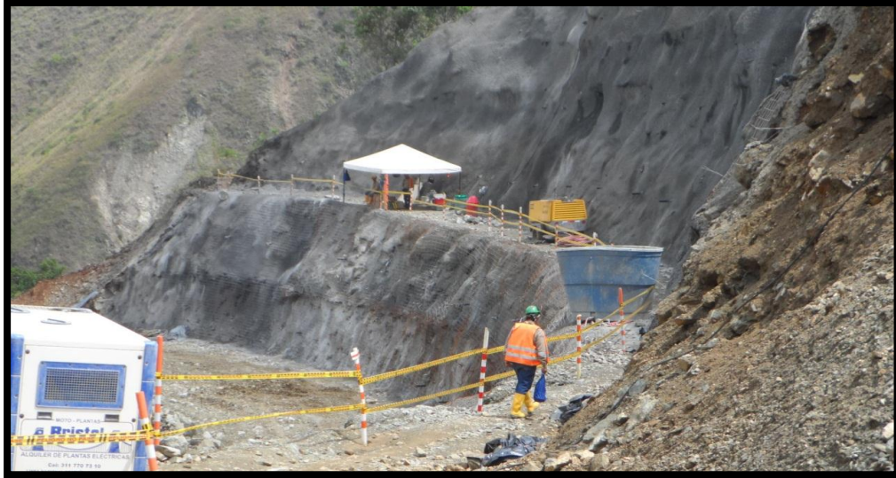
FOTOGRAFIA 25. Se reanudo los trabajos de explotación y estabilización
