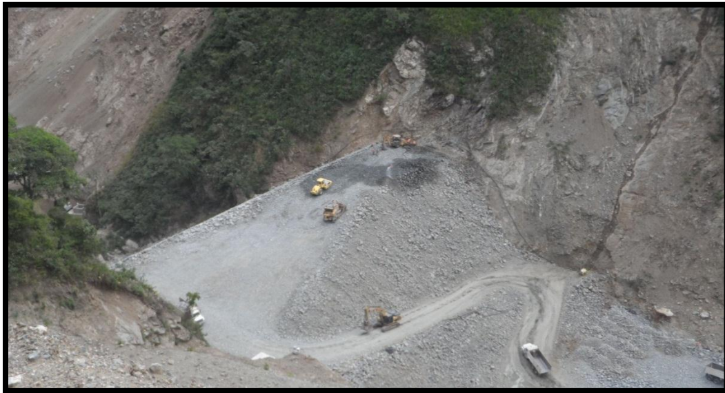
FOTOGRAFIA 42. Sigue el avance de llenos hasta la cota 818
