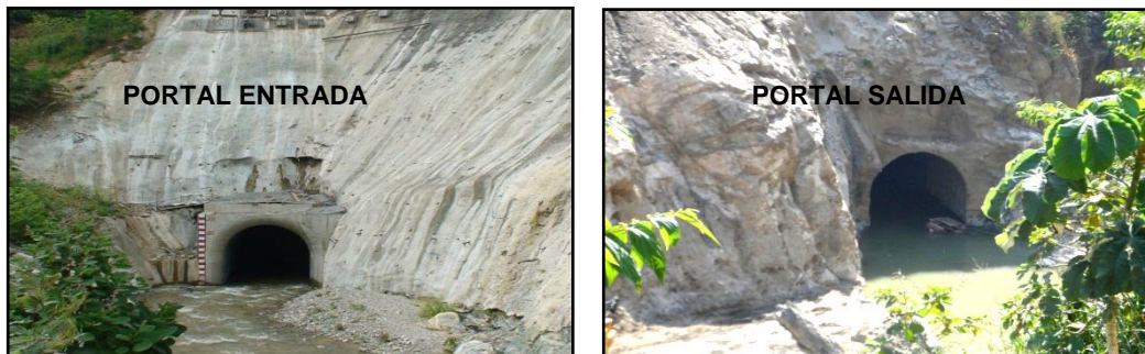
FOTOGRAFIA 2. Túnel de Desvío
