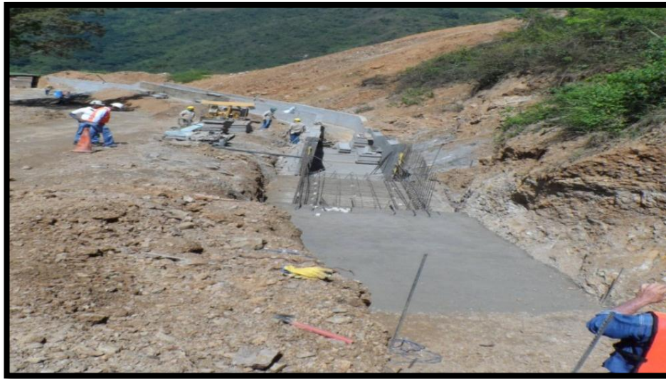
FOTOGRAFIA 81. Solado para armado de acero
