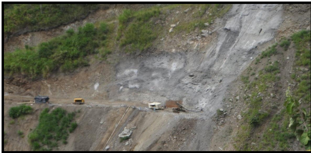
FOTOGRAFIA 70. Colocación de malla para concreto secundario
