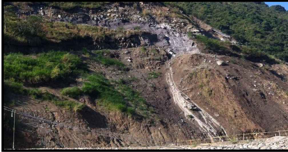
FOTOGRAFIA 66. Estructura de Captación
