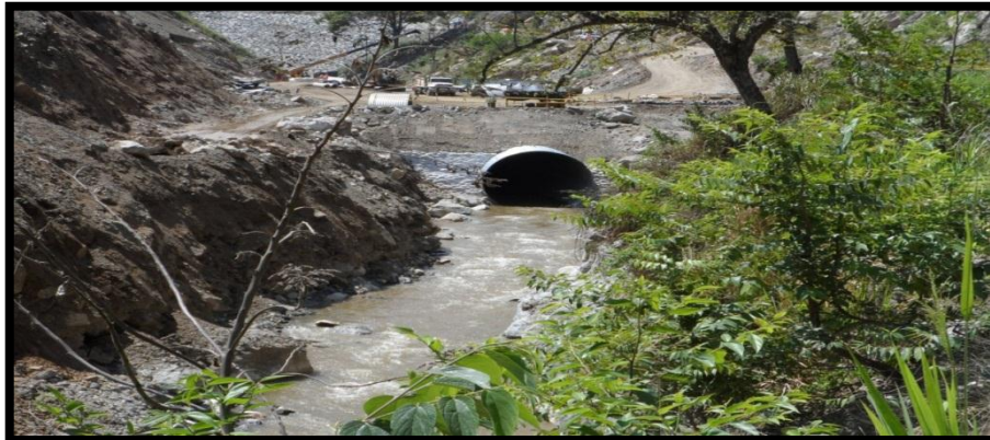
FOTOGRAFIA 119. Avance del entubamiento y compactación de la zona
