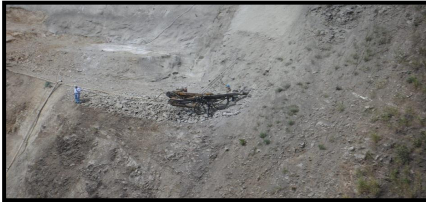
FOTOGRAFIA 72. Perforación en la cota 838.90 para lanzado secundario
