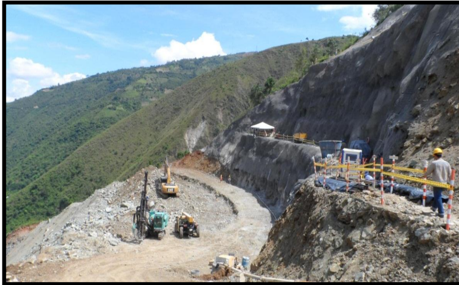
FOTOGRAFIA 27. Terminada excavación de la tercera Berma.
