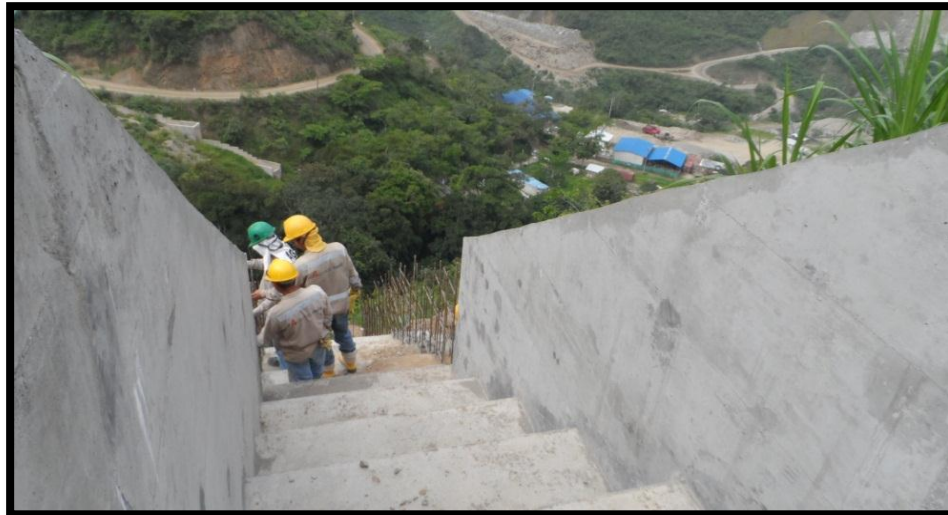
FOTOGRAFIA 80. Escaleras de disipación del Canal C4
