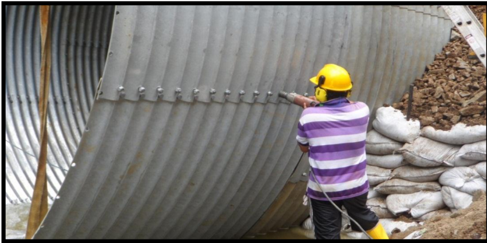
FOTOGRAFIA 125. Avance de la tubería para empalmar con la transición
