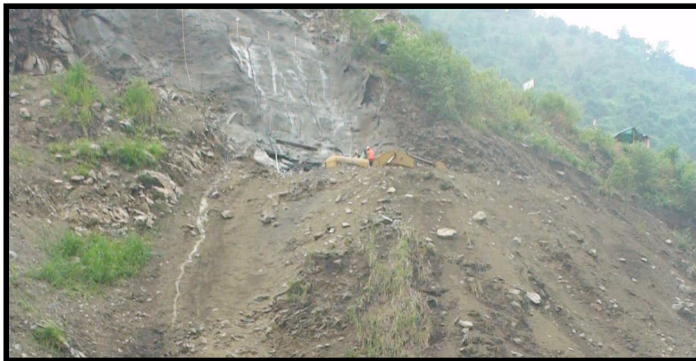
FOTOGRAFIA 67. Estabilización y perforaciones
