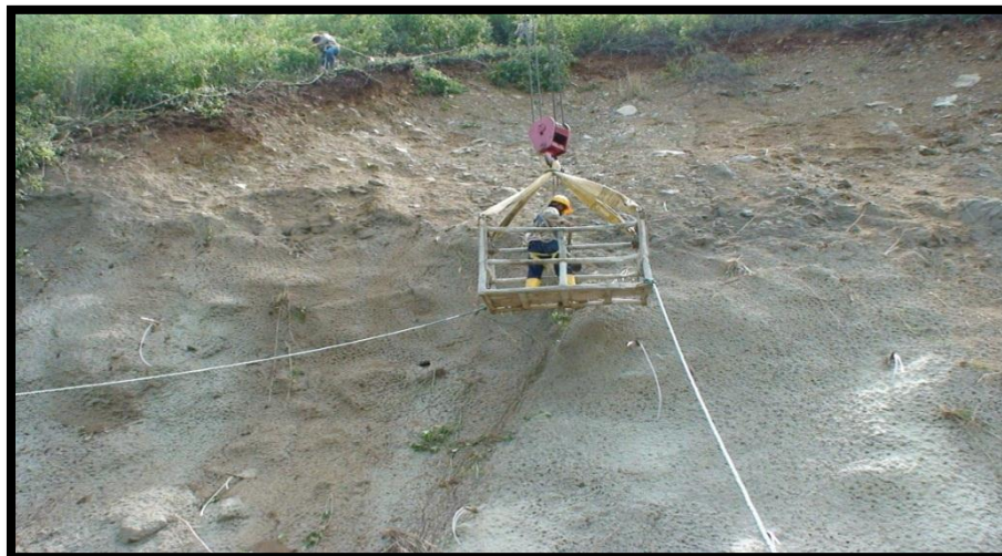
FOTOGRAFIA 103. Lanzado de concreto parte alta del muro
