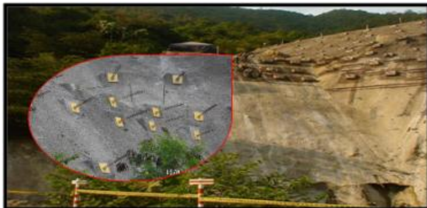
FOTOGRAFIA 62. Colocación de Concreto y Tensionamiento de Dados
