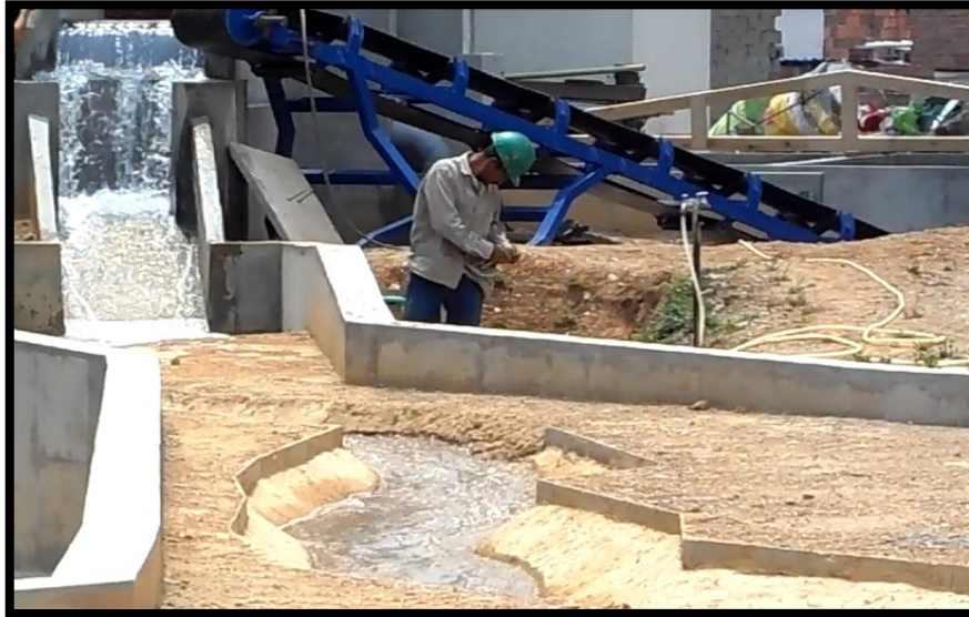
FOTOGRAFIA 133. Primer llenado del Modelo Hidráulico
