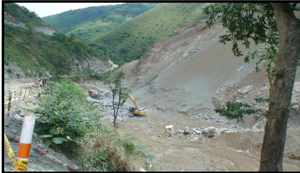
FOTOGRAFIA 130. Terminación completa de la plataforma.
