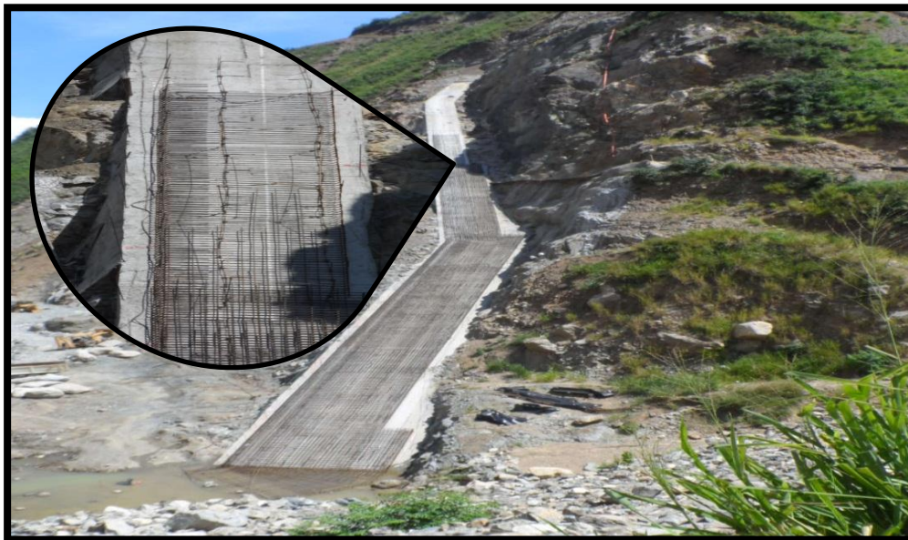
FOTOGRAFIA 54. Armado de acero de refuerzo inferior de Plinto Tramo 8
