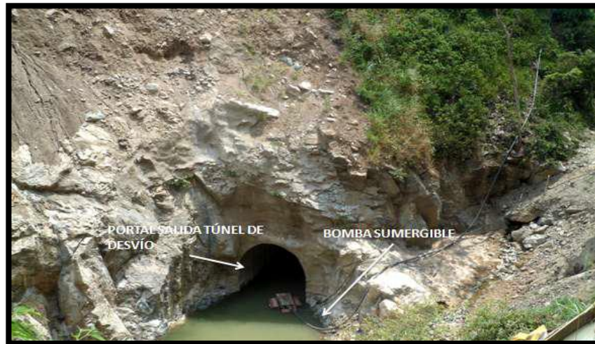
FOTOGRAFIA 65. Cauce antes de empezar el entubamiento
