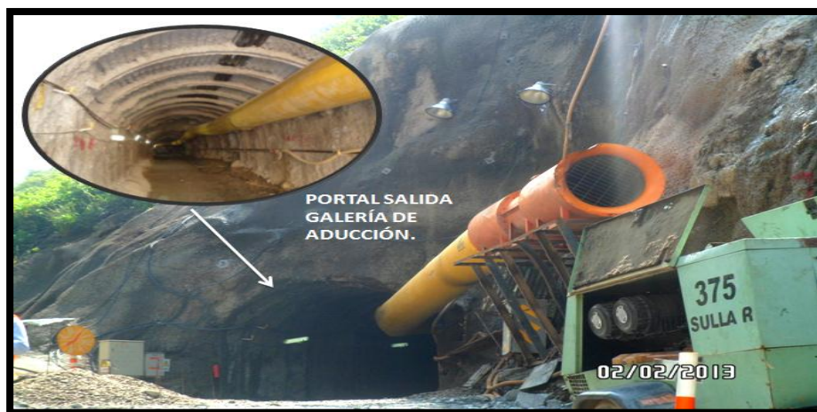
FOTOGRAFIA 9. Avance del túnel de aducción
