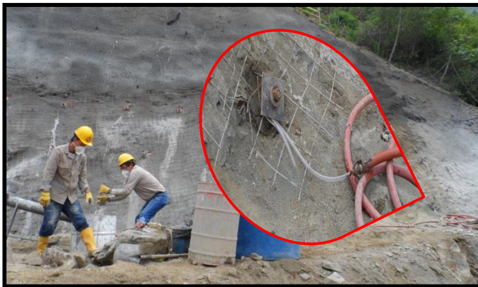
FOTOGRAFIA 109. Inyección de pernos.
