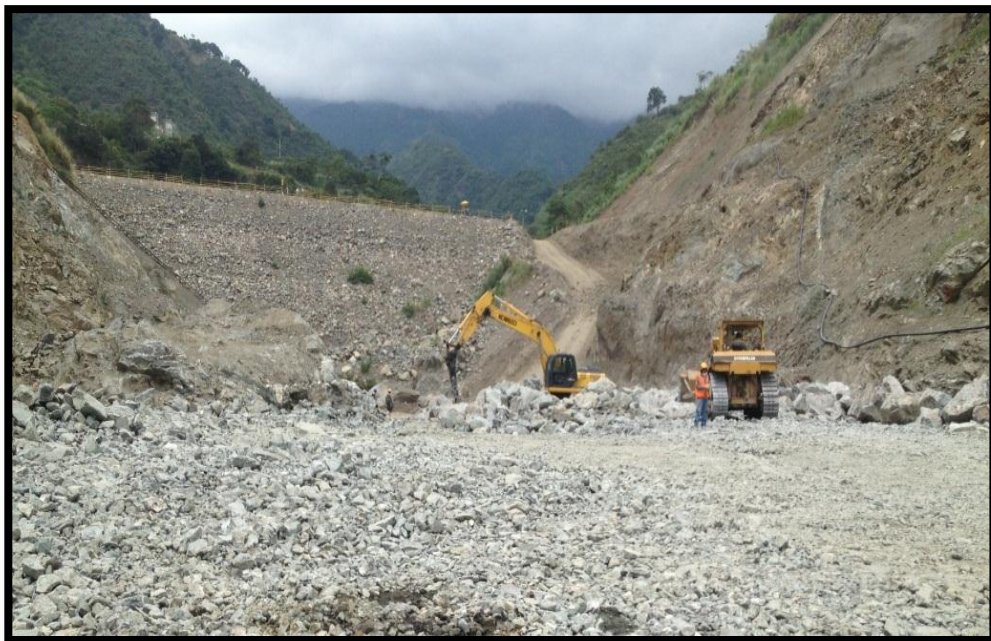
FOTOGRAFIA 40. Demolición de sobre tamaños en la zona 3C
