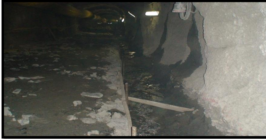
FOTOGRAFIA 20. Armado de formaletería.
