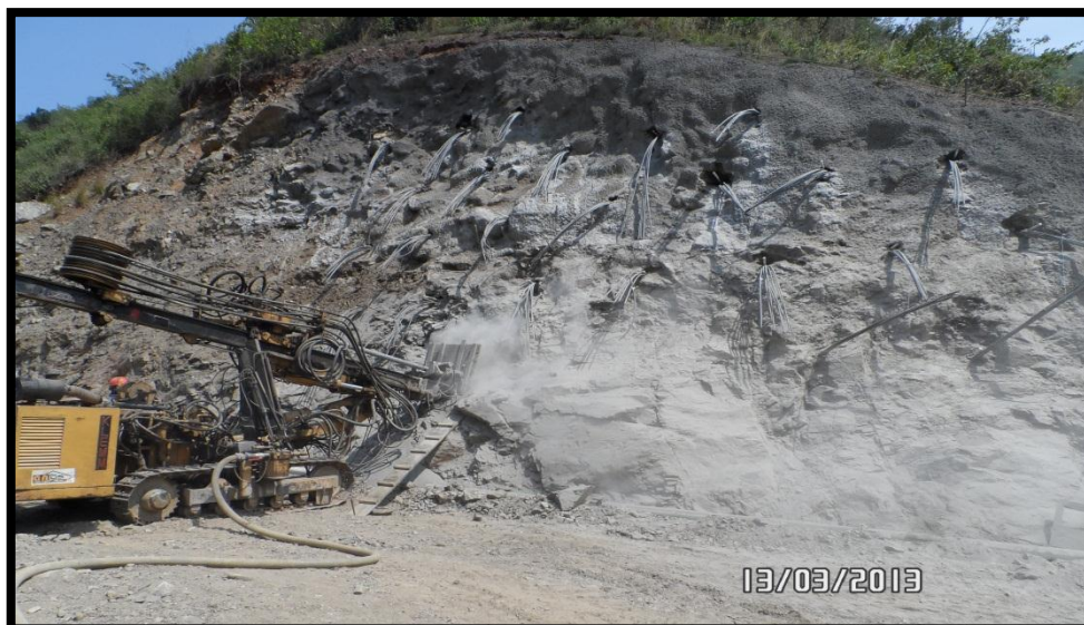
FOTOGRAFIA 89. Estabilización de talud y perforación.
