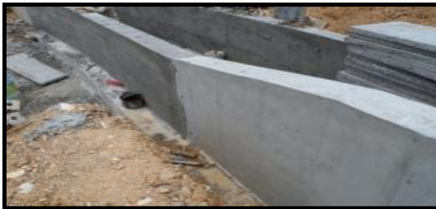
FOTOGRAFIA 76. Fundida de Muros del Canal C4.
