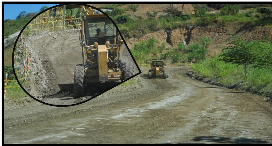
FOTOGRAFIA 58. Limpieza de vías
