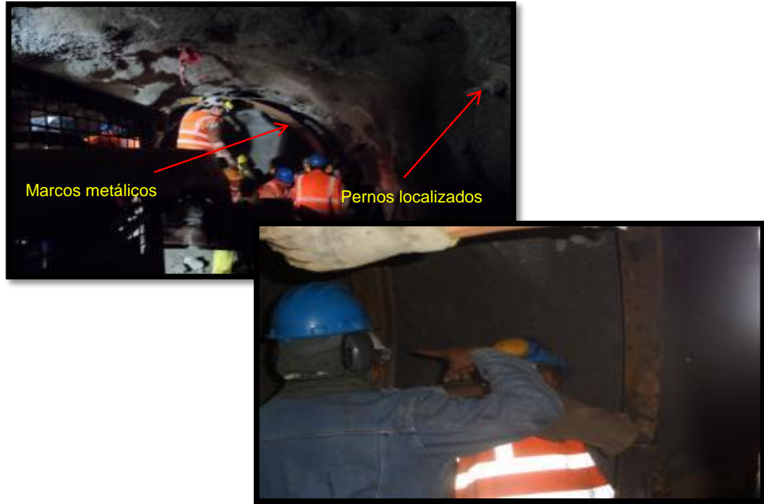
FOTOGRAFIA 12. Instalación de Marcos y pernos
