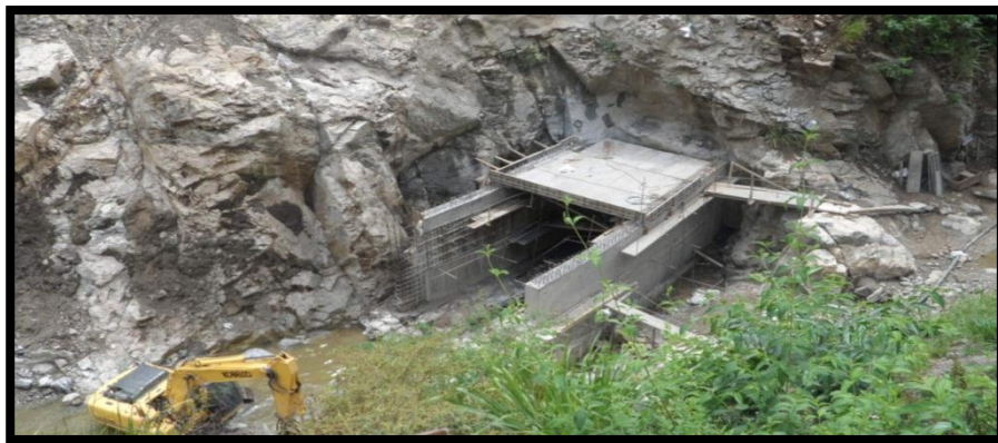
FOTOGRAFIA 123. Avance de la transición para anclaje con la tubería
