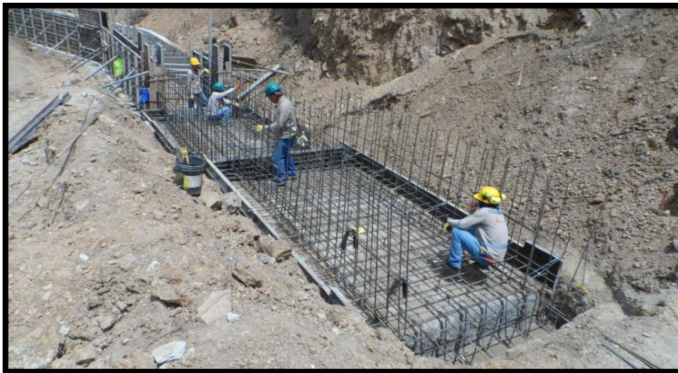
FOTOGRAFIA 82. Armado de acero
