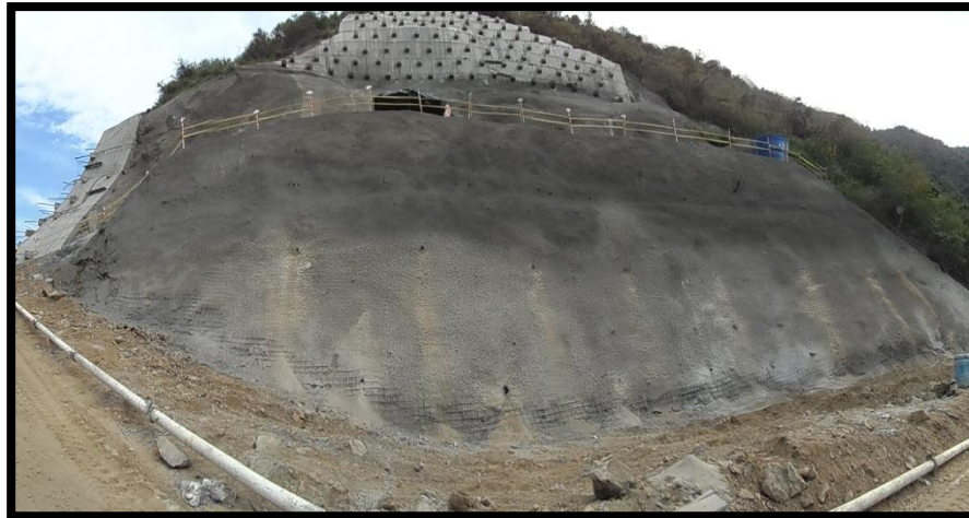
FOTOGRAFIA 111. Lanzado de concreto secundario entre 925 y 915
