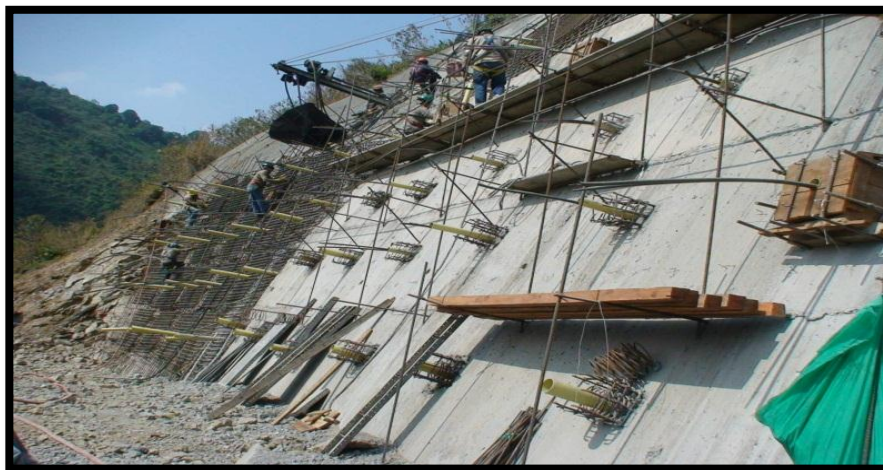
FOTOGRAFIA 105. Portal Oriental Túnel Vial
