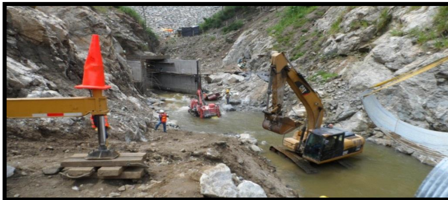
FOTOGRAFIA 122. Continuación del Entubamiento y perforación de rocas en el lecho del río para anclar la tubería.
