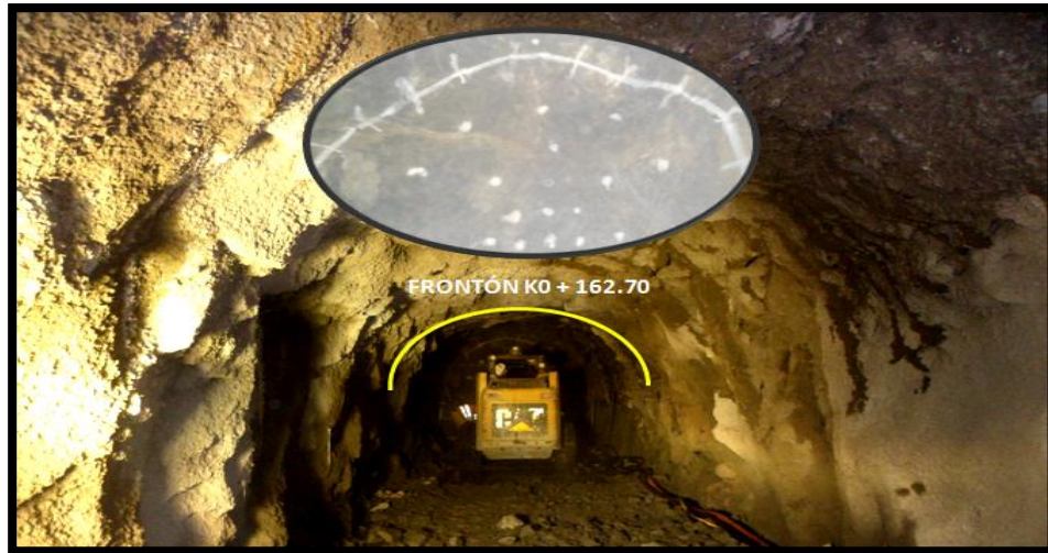
FOTOGRAFIA 10. Nuevo Frontón de avance del túnel
