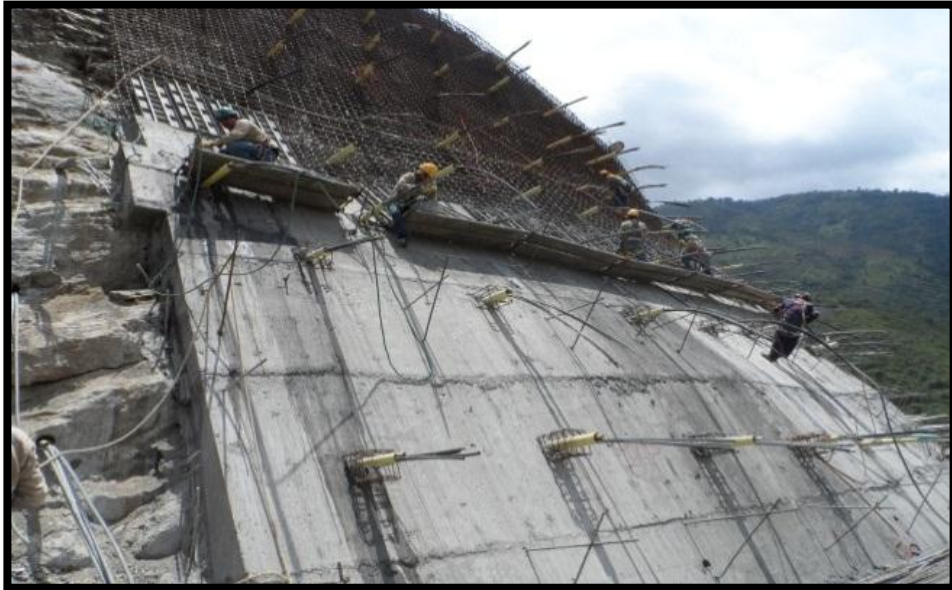
FOTOGRAFIA 94. Fundida de pantalla y colocación de formaleta
