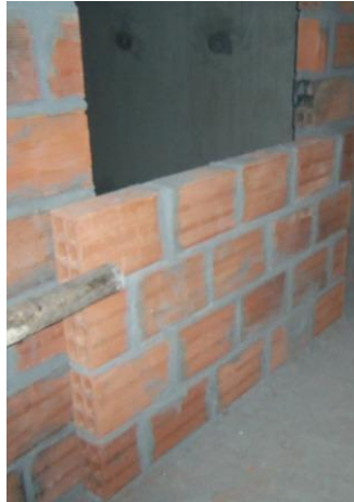
Figura15: Antepecho instalado para la protección de caídas por fosos de ascensores
