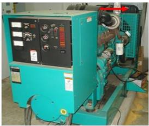
Figura 15. Enfriador de aire.
