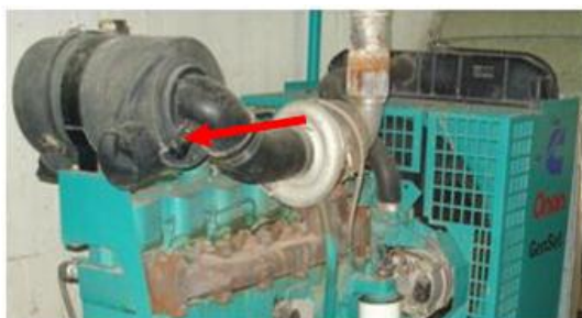
Figura14. Restricción filtro de aire.
