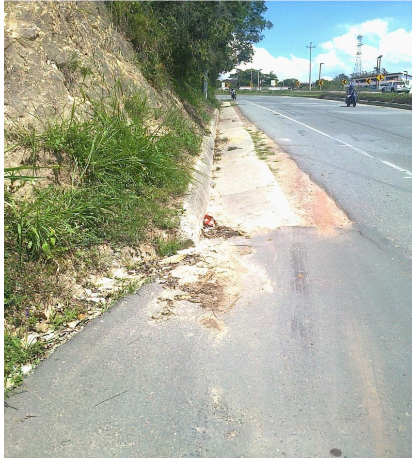
Figura 46. Sentido aeropuerto - Puente Flandes km 64+580
