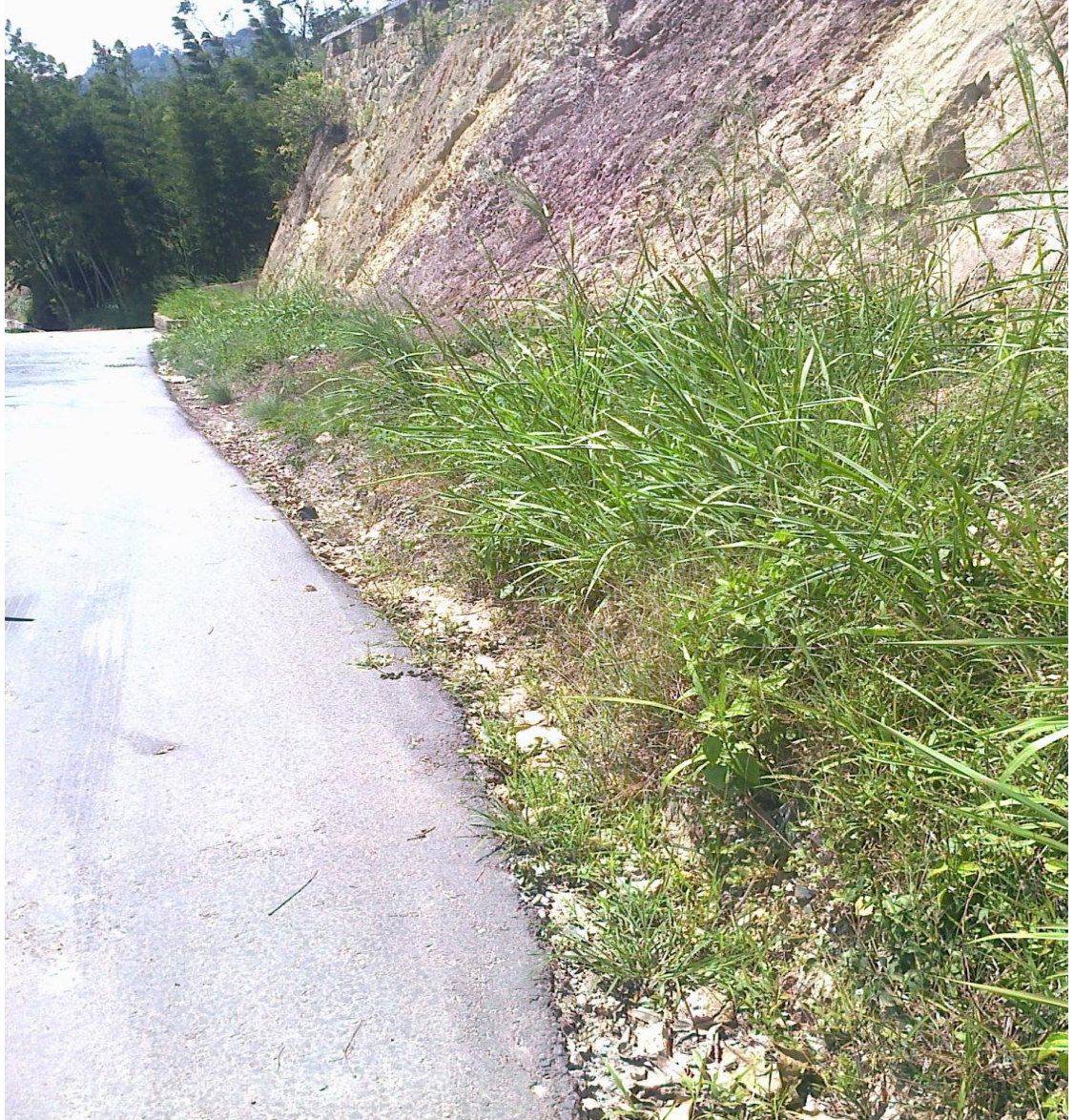
Figura 48. Sentido aeropuerto - Puente Flandes km 64+580
