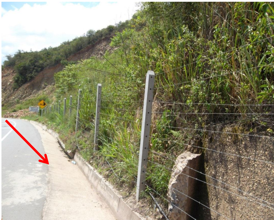
Figura 52. Sentido Aeropuerto - Puente Flandes km 64+950
