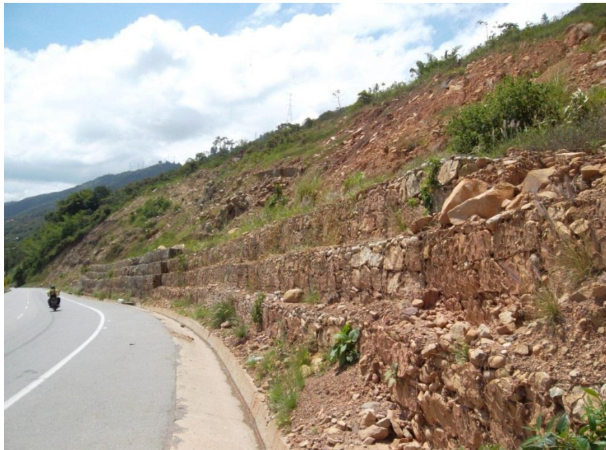
Figura 55. Sentido Aeropuerto - Puente Flandes km 65+270
