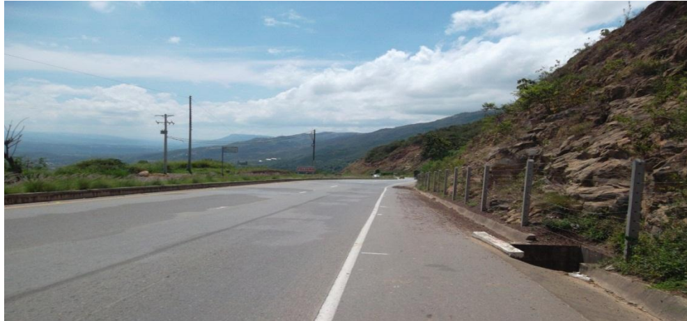
Figura 51. Sentido Aeropuerto - Puente Flandes km 65+030
