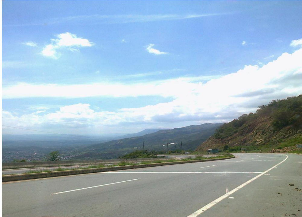
Figura 50. Sentido aeropuerto - Puente Flandes km 64+900
