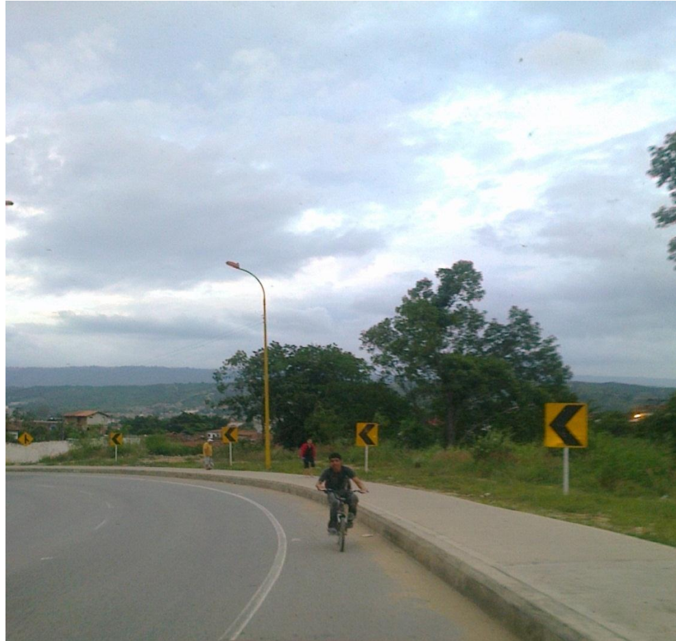
Figura 58. Sentido aeropuerto - Puente Flandes km 70+150
