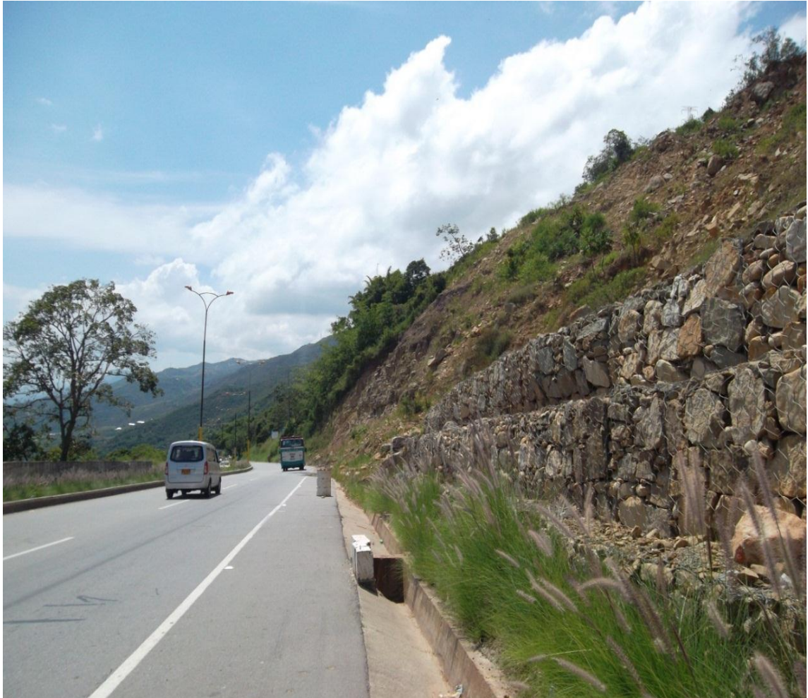
Figura 56. Sentido Aeropuerto - Puente Flandes km 65+270
