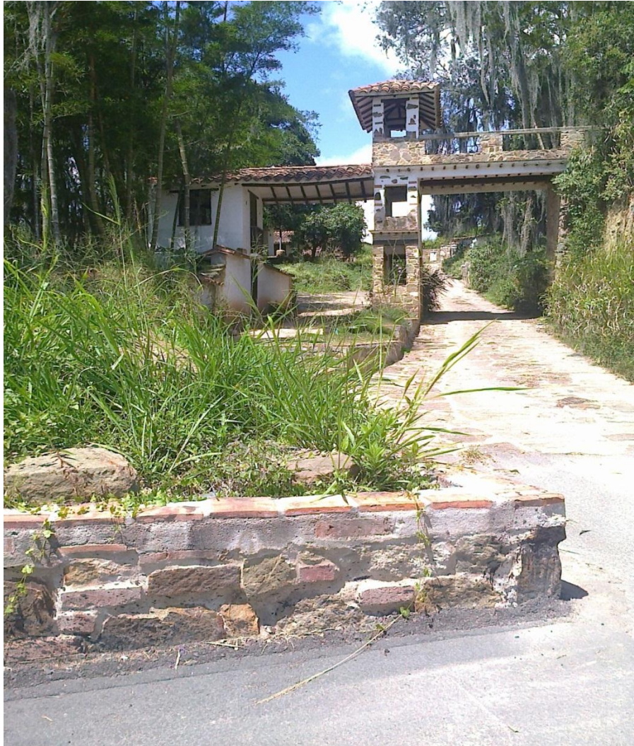
Figura 49. Sentido aeropuerto - Puente Flandes
