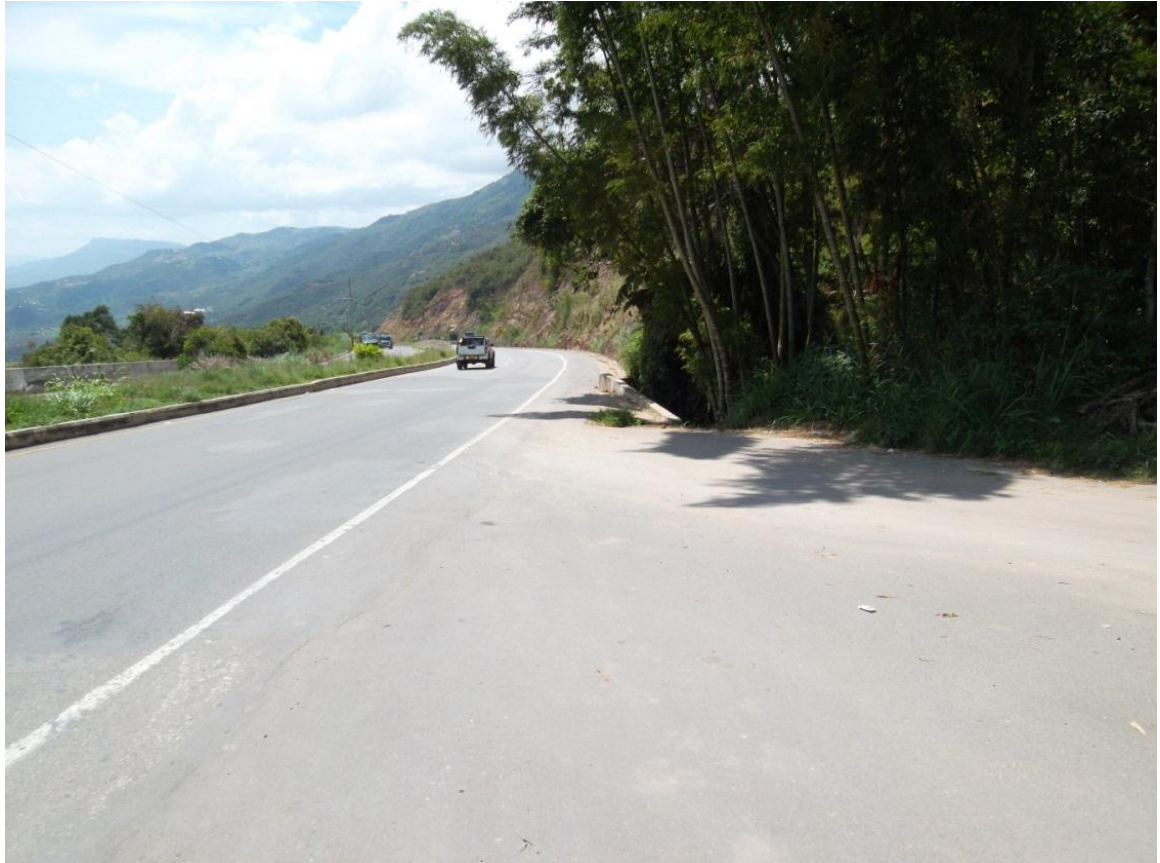
Figura 47. Sentido Aeropuerto - Puente Flandes km 64+670
