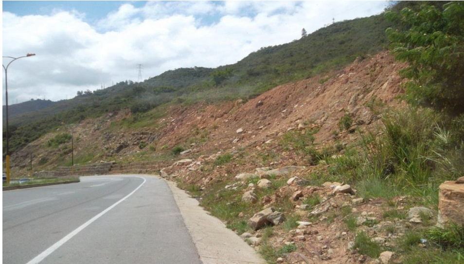
Figura 54. Sentido Aeropuerto - Puente Flandes km 65+210
