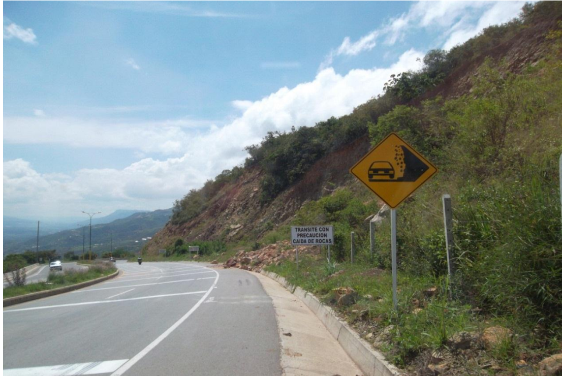
Figura 53. Sentido Aeropuerto - Puente Flandes 64+950
