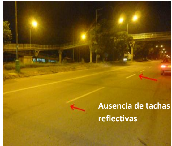
Imagen N° 44 Sentido Retorno La Rioja – Retorno Platacero (Tachas Reflectivas 1)
