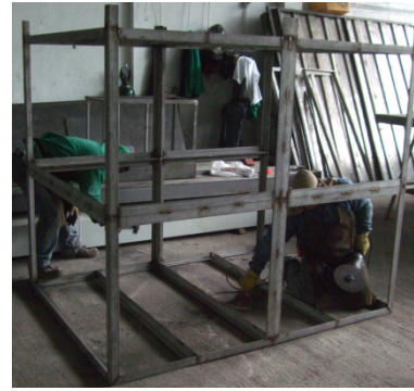
Figura 6.1: Fotografías del marco del horno hecho en FEMARCO Ltda.
