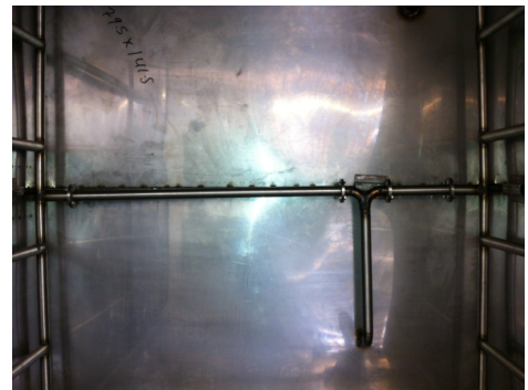
Figura 6.12: Fotografía de la tubería instalada en sitio
