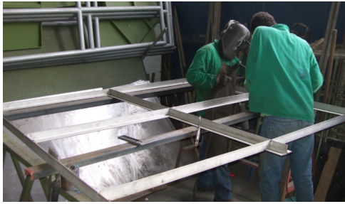
Figura 6.1: Fotografías del marco del horno hecho en FEMARCO Ltda.
