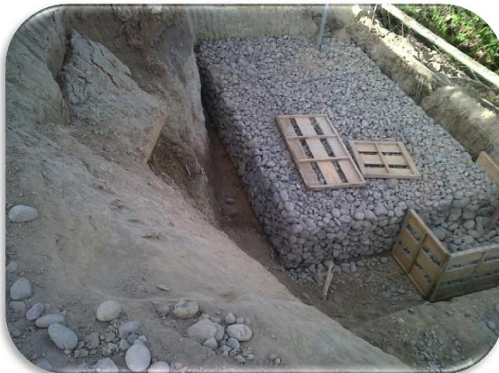
Cabe mencionar que la utilización del solado de limpieza no es solamente para el primer nivel de gavión, sino cada vez que haya cambio de nivel, siempre y cuando se requiera como se ve en la figura 71.
