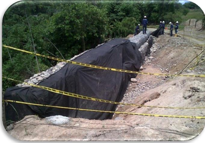
**Figura 74. Instalación de geotextil de tipo no tejido 1600 pavco en el área de contacto entre el suelo y el gavión k8+500, Peñas Blancas**
