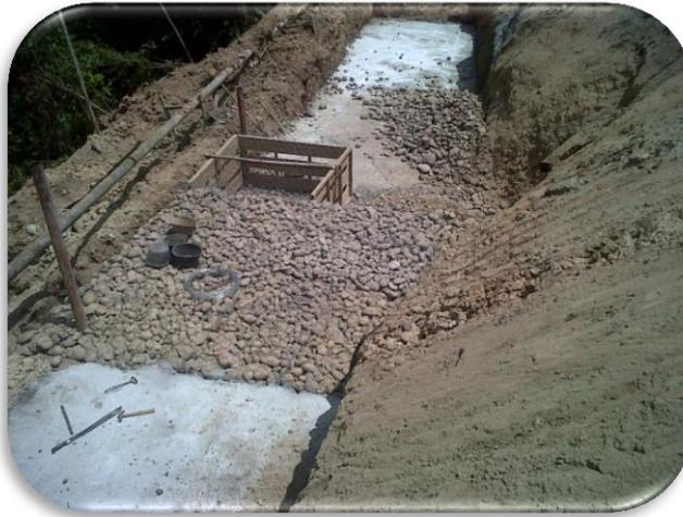
**Figura 72. Construcción nivel 3 y nivel 4 gavión k8+500, Peñas Blancas**
