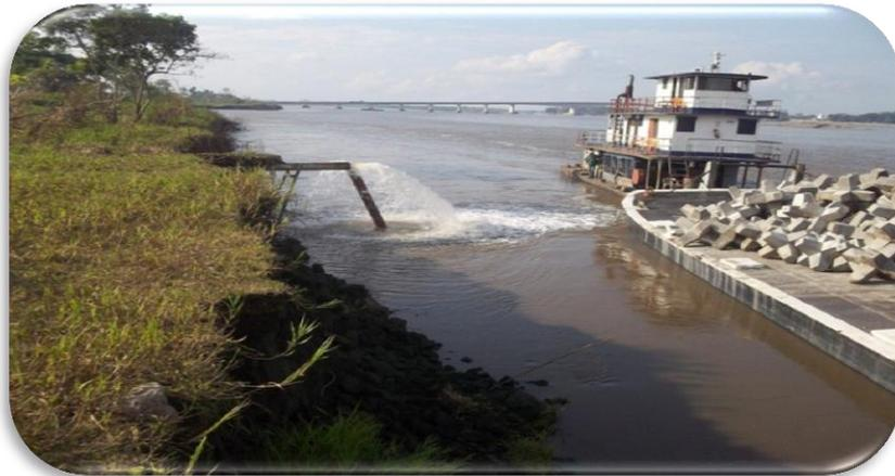
**Figura 42. Descargue de hexápodos h-430 en el vertimiento de la estación 3**
