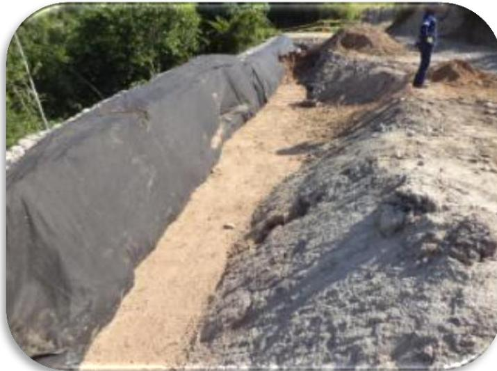
En la figura 74, se observa la instalación del geotextil del tipo no tejido 1600 de PAVCO. “Los geotextiles no tejidos son altamente recomendables para el drenaje de subsuelo y para el control de la erosión, así como para la
