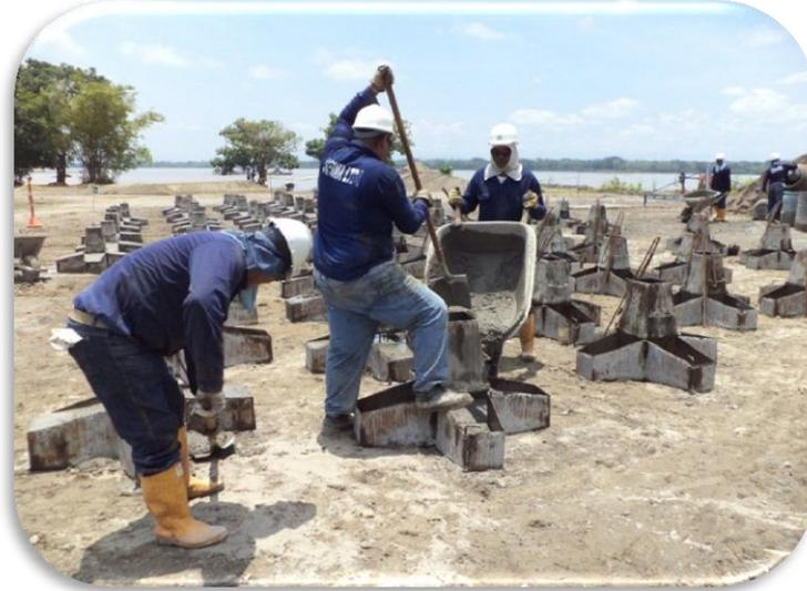
Figura 29. Vaciado completo de concreto y resane de la estructura, hexápodo h-430
