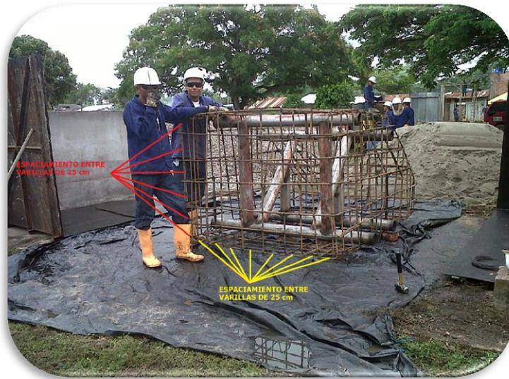
Se construyó y se incorporó un embebido metálico en la estructura, el cual era recubierto por acero de refuerzo, y eso a su vez rellenado con concreto de 3000 PSI. El embebido metálico era una tubería de segunda suministrada por Ecopetrol S.A de 4”.
