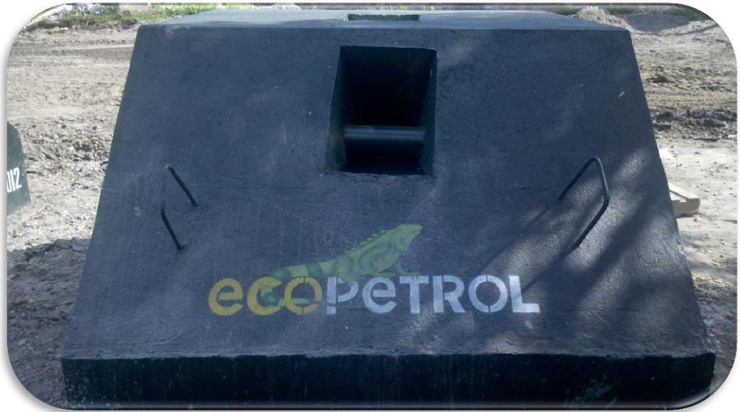
Se instaló en las aristas del anclaje móvil, un ángulo de 2 x 2 x 3/8 “, con el fin de proteger los bordillos de las estructuras.
