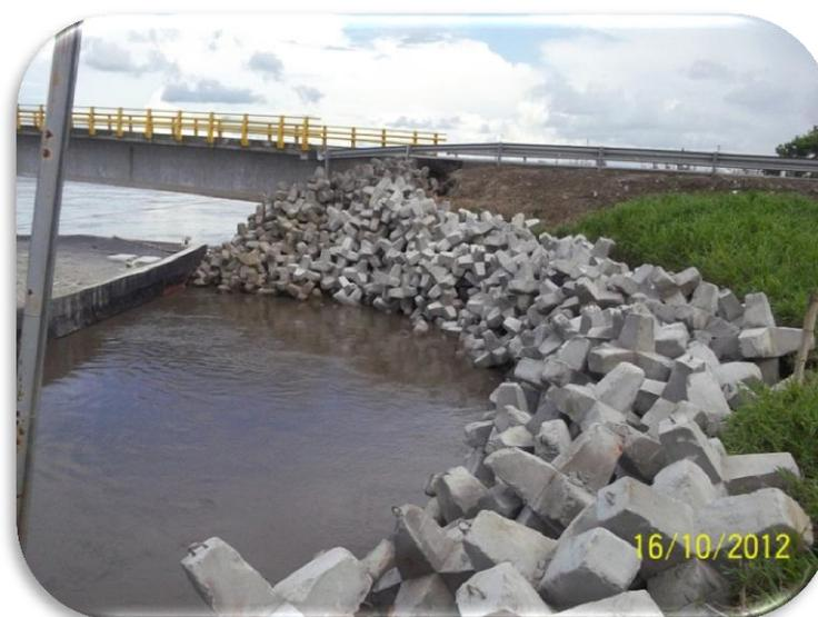
La relación que teóricamente se tiene para la disposición según la experiencia en el área, es que por cada m<sup>3</sup> se necesitan 3 hexápodos, por ende tomando las medidas de longitud, alto (profundidad del fondo del río hasta el borde superior del talud) y el ancho se obtiene el volumen, para tener un aproximado de las estructuras que se dispondrán en ese punto, y así el número de viajes que se necesitaran para la disposición.
