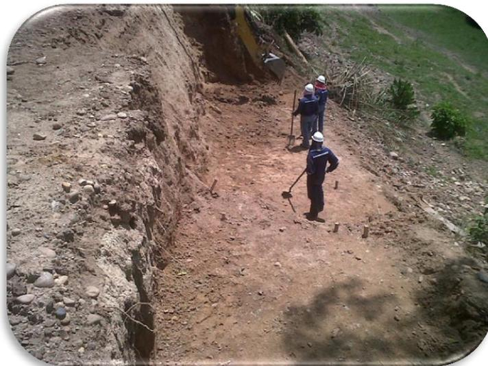
En la figura 85, se observa que cierta cantidad de material se deslizo hacia la parte inferior de la excavación, debido al movimiento de vehículos que
