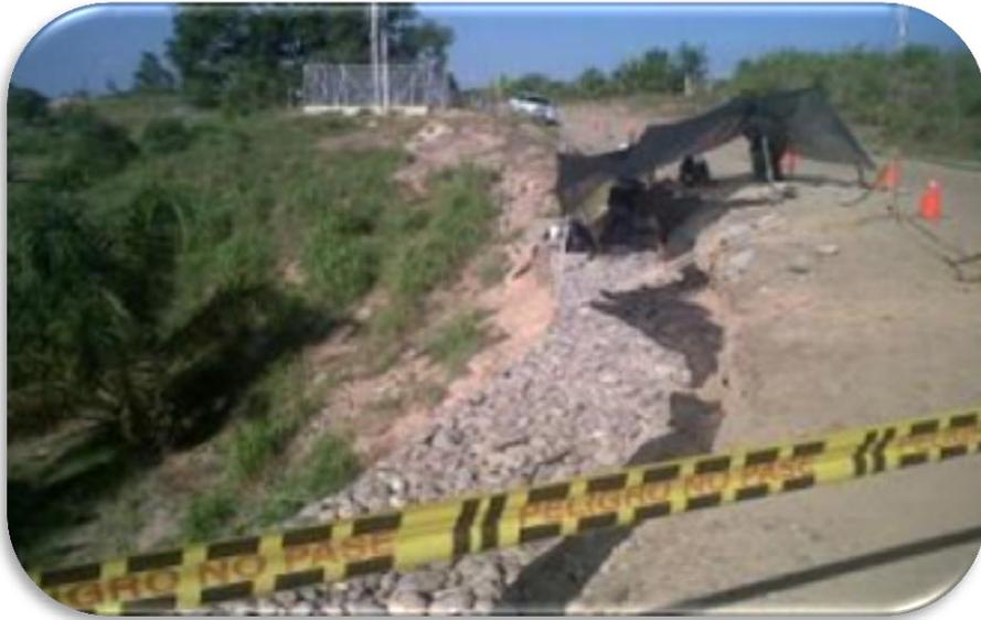
**Figura 81. Instalación de geotextil de tipo no tejido 1600 pavco en el área de contacto entre el suelo y el gavión k4+500, Peñas Blancas**
