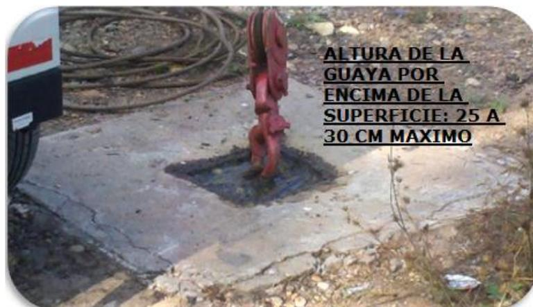
**Figura 99. Amarre de los ganchos de los cables de tensión de la torre de los vientos de ECOPETROL S.A, Campo Casabe**
