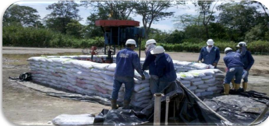
**Figura 59. Culminación dique de protección pozo productor ECOPETROL S.A**
