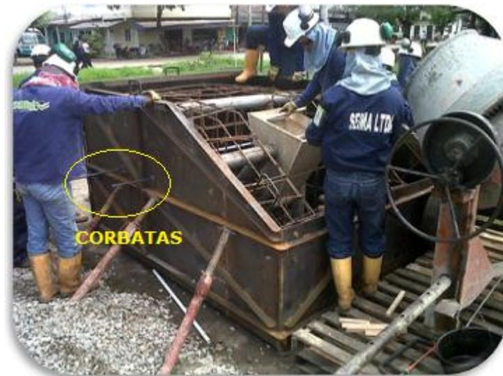
Terminado el amarre del acero al embebido metálico, e incorporada la estructura a la formaleta, se instalan los cajones de madera en los soportes superiores de la tubería de 4”, dejando un espacio libre de concreto, donde se sujetan los gancho de las torres telescópicas.
