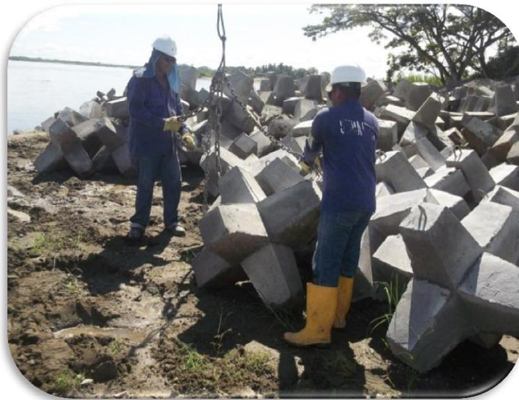
**Figura 39. Cargue hexápodos h-430 para disposición.**
