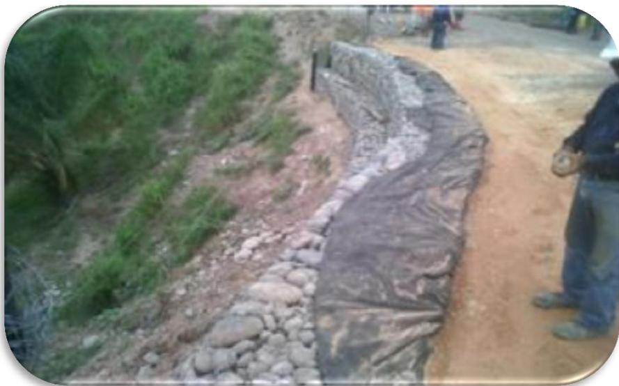
**Figura 82. Relleno y compactación cada 0.3m para conformación de vía k4+500, Peñas Blancas**
