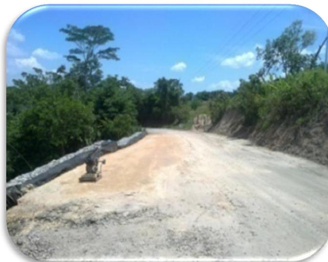
Al terminar la construcción del muro de contención de gaviones en el K8+500 del corregimiento de Peñas Blancas, se observa el relleno compactado con material gravo arcilloso, la altura de la estructura que sobresale por encima del nivel de la carretera y la ampliación de la vía, como lo indico ECOPETROL S.A.
