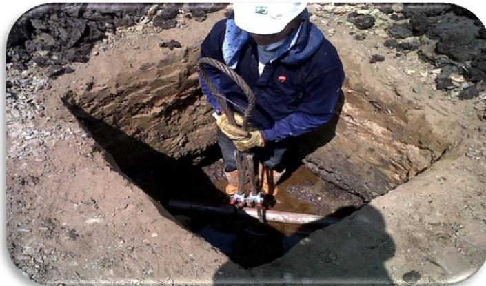
Como se mencionó anteriormente, realizada la excavación, se instalaba el tubo metálico de 2-7/8" suministrado por ECOPETROL S.A. El siguiente paso era amarrar la guaya a través de los prensacables al tubo de 2-7/8" (ver figura 97). La guaya debía sobresalir del hueco de la excavación a la superficie, alrededor de 30 cm (ver figura 98) para poder sujetar los ganchos de los cables de tensión de la torre de los vientos de los equipos de workover (ver figura 99).
