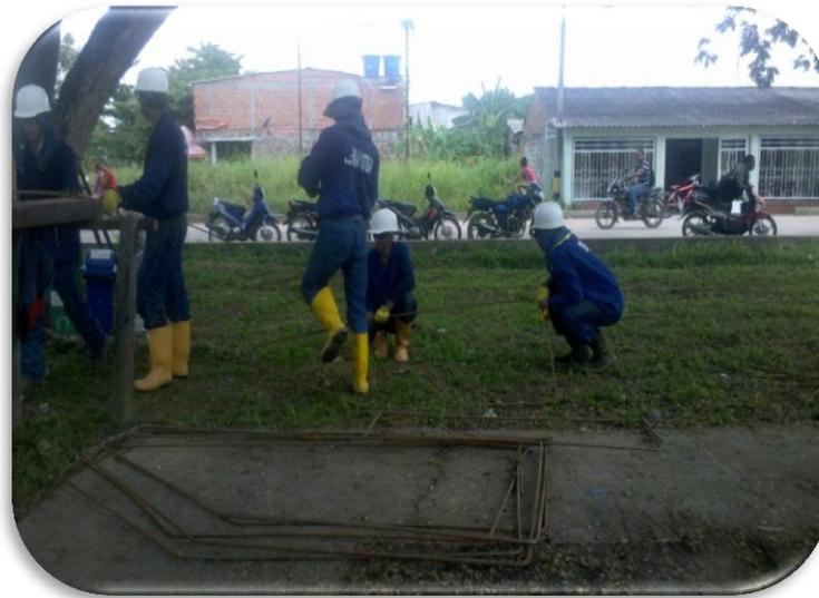
**Figura 113. Amarre de acero de refuerzo junto con embebido metálico 4”**
