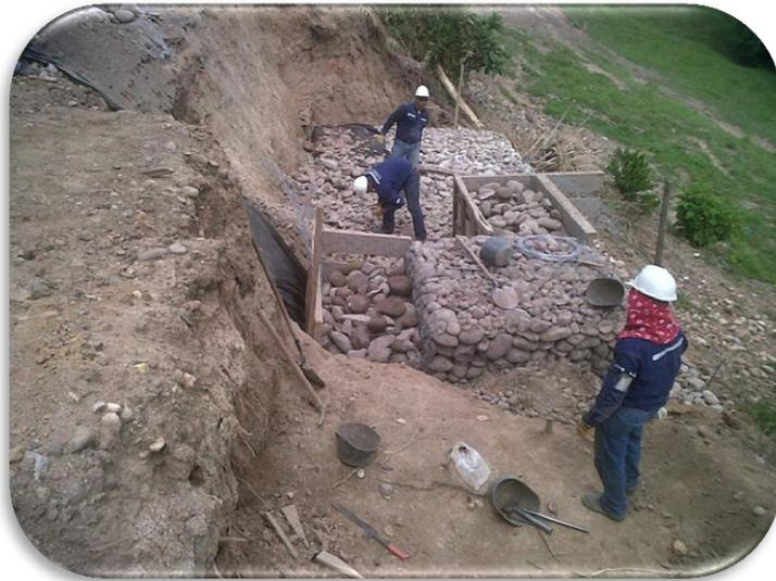
**Figura 88. Utilización de geotextil como polisombra k3+500, Peñas Blancas**
