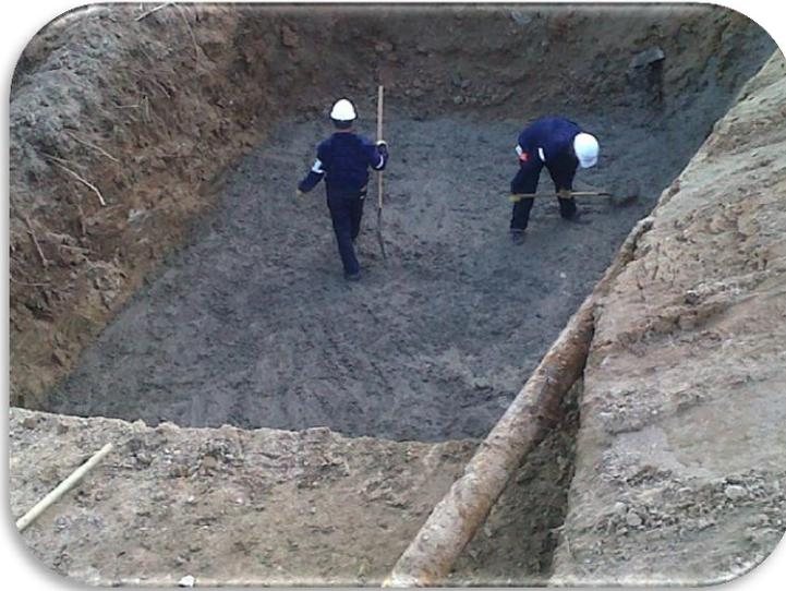
Como habíamos mencionado anteriormente, en la figura 68, se ve claramente el agregado pétreo para la elaboración de concreto ciclópeo, que tuvo un espesor de 40 cm. “<sup>7</sup>Se utilizó ciclópeo debido a que es un elemento estructural que resiste esfuerzos de compresión por peso de la estructura”.
