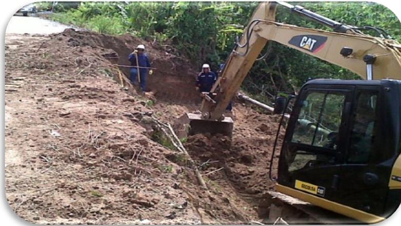
Durante la ejecución de la actividad, la interventoría solicitó que se ampliara la vía (ver figura 66), aprovechando que se tenían las máquinas in situ, para facilitar el acceso de las volquetas y del trabajo como tal. Además, al ampliar la vía, era más sencillo dar paso a las cisternas y/o vehículos con equipos de ECOPELROL S.A que transitaban por ese sector.
