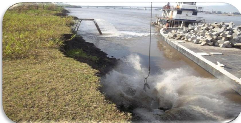
**Figura 43. La instalación de los hexápodos va hasta el borde superior del talud**
