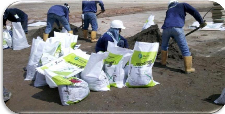
**Figura 58. Conformación dique de protección pozo productor**
