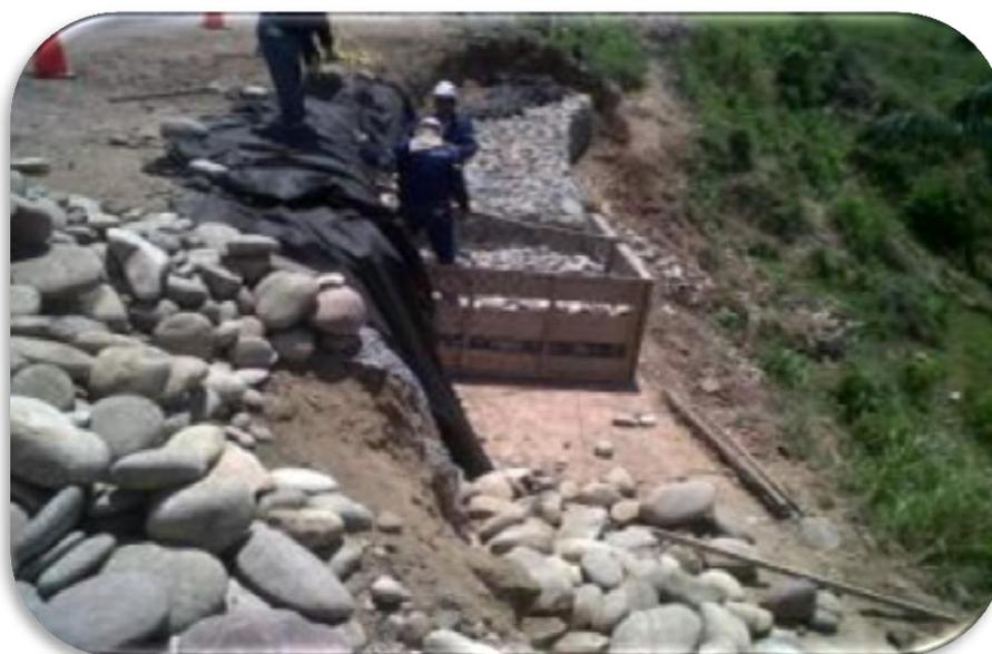
**Figura 80. Construcción segundo nivel gavión k4+500, Peñas Blancas**
