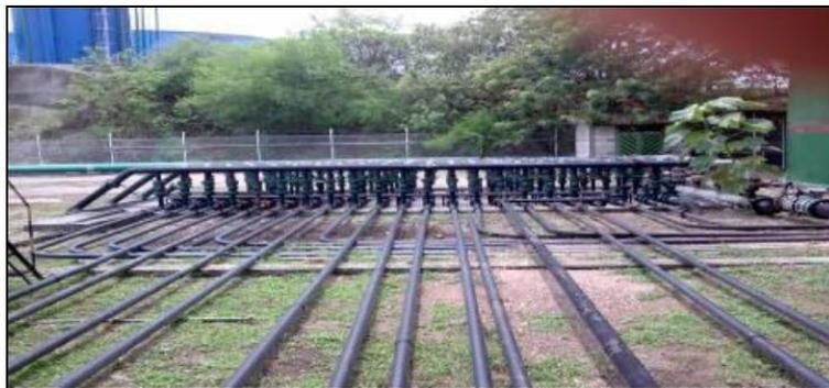
Figura 8. Manifold de recepción de crudo en una Planta de Tratamiento.
