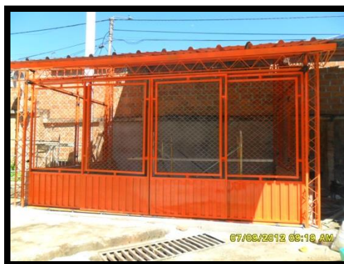
Figura 8. Cuarto de almacenamiento temporal para residuos peligrosos.
