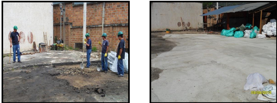
Figura 4. Metodología utilizada para dicho procedimiento: limpieza, extracción y disposición final del suelo contaminado.
