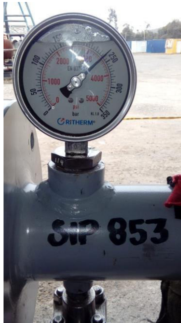
Ilustración 5: mantenimiento Actuador hidráulico
