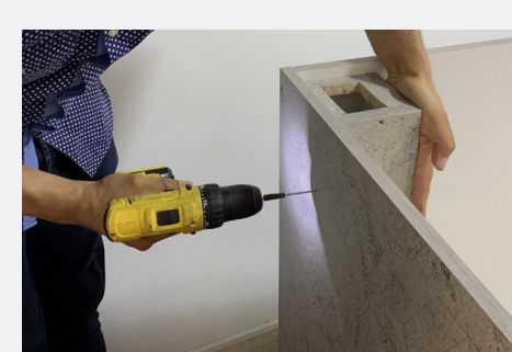
Ensamble torre de conexión
