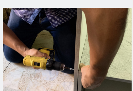
Asegurar las dos bases centrales por el lateral izquierdo
