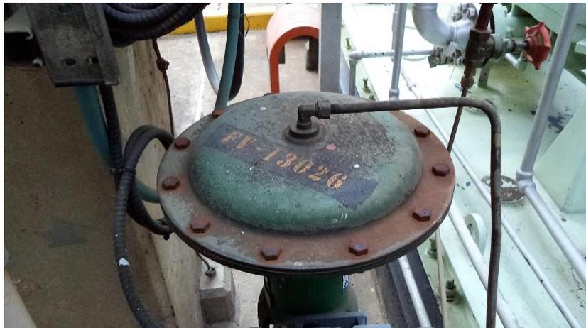
En este caso se encuentra registrada esta válvula como “Reflujo de la T-1305” y al revisar los equipos adyacentes (como se representa en el diagrama grande de control de la Fig. 10) se observa que es una válvula que
