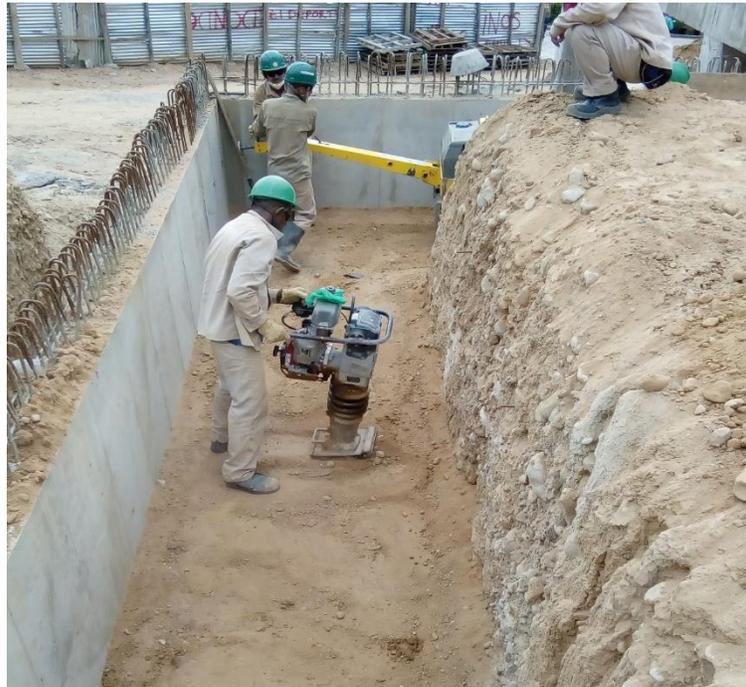
*Figura 22..* Compactación de suelo por medio de vibro compactador tipo rana Muro N°9 – Colegio Mirador de Arenales.
