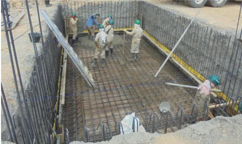
*Figura 30.. Armado de acero de fuerza tanque subterráneo – Colegio Mirador de Arenales.*
