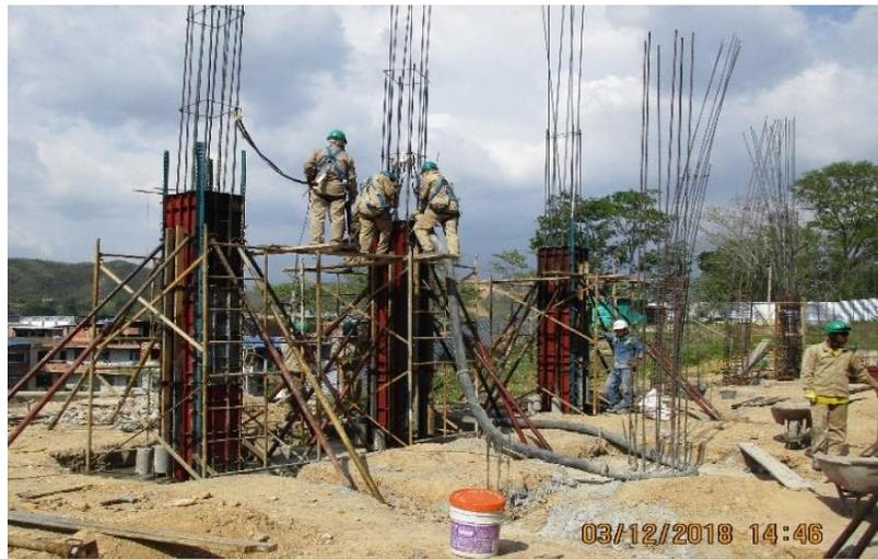
*Figura 8* Vaciado de concreto en columnas del primer nivel edificio 3 – Colegio Puerto Madero.
