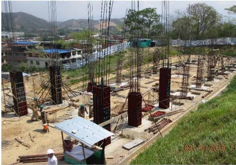
*Figura 7.* Armado de formaleta en columnas del primer nivel edificio 3 – Colegio Puerto Madero.
