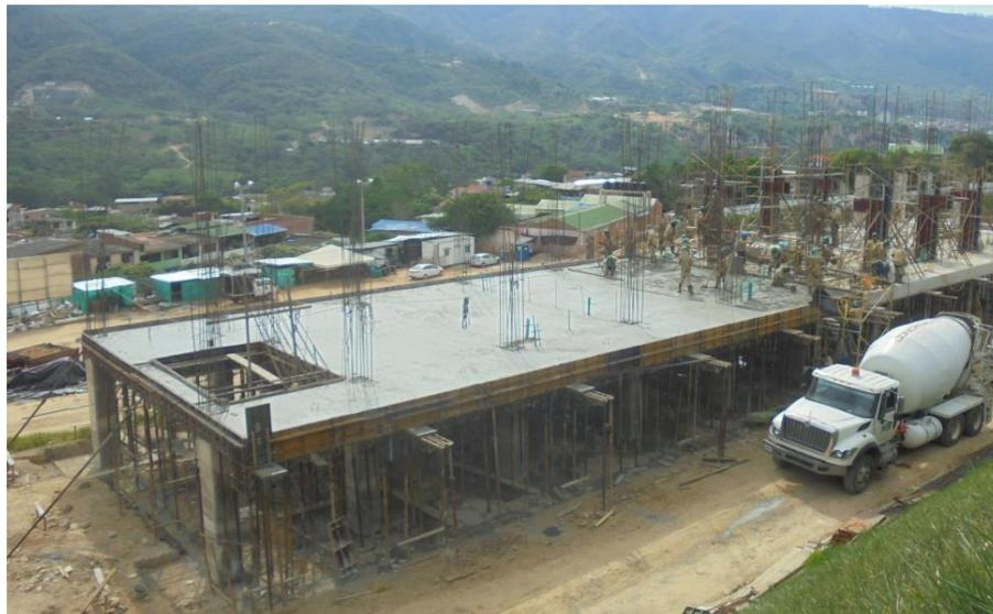
*Figura 12.* Vaciado de concreto en vigas y placa N+3,50m Modulo B - edificio 3 – Colegio Mirador de Arenales
