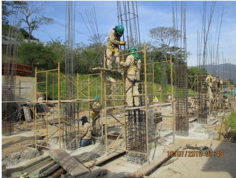
*Figura 6.* Amarre de acero en columnas edificio 2 – Colegio Puerto Madero.
