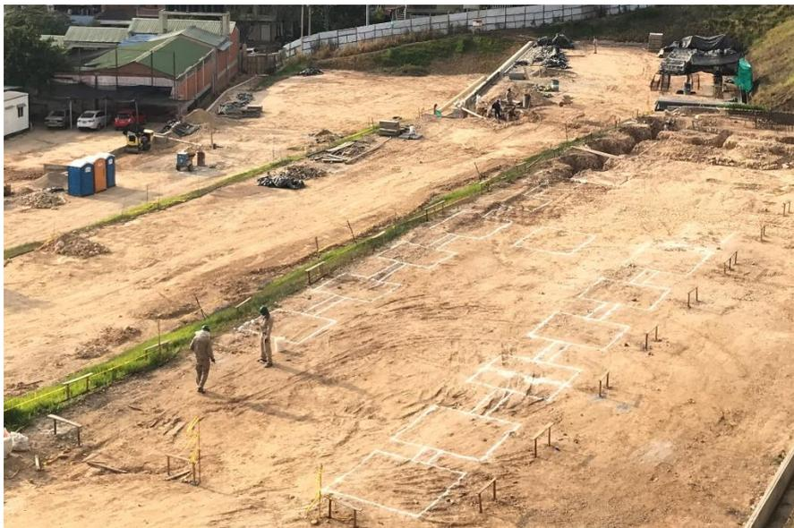
*Figura 1.* Replanteo para cimentación edificio 3 – Colegio Mirador de Arenales.
