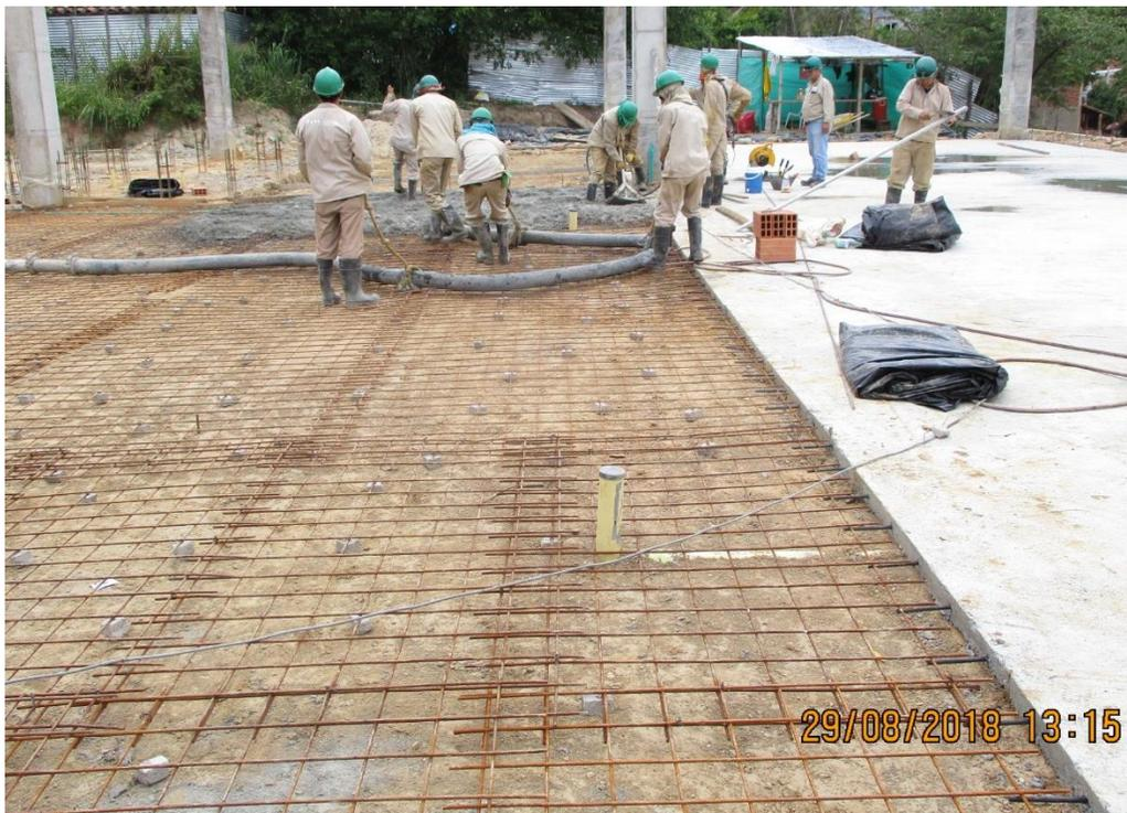
*Figura 24.* Descarga de concreto en placa de contra piso edificio 4 – Colegio Puerto Madero.
