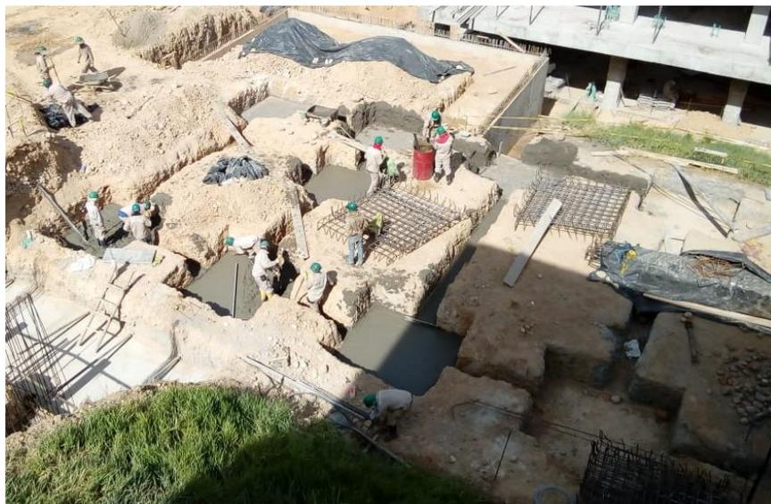
*Figura 3.* Aplicación de Concreto simple (solado) edificio 2 – Colegio Mirador de Arenales.
