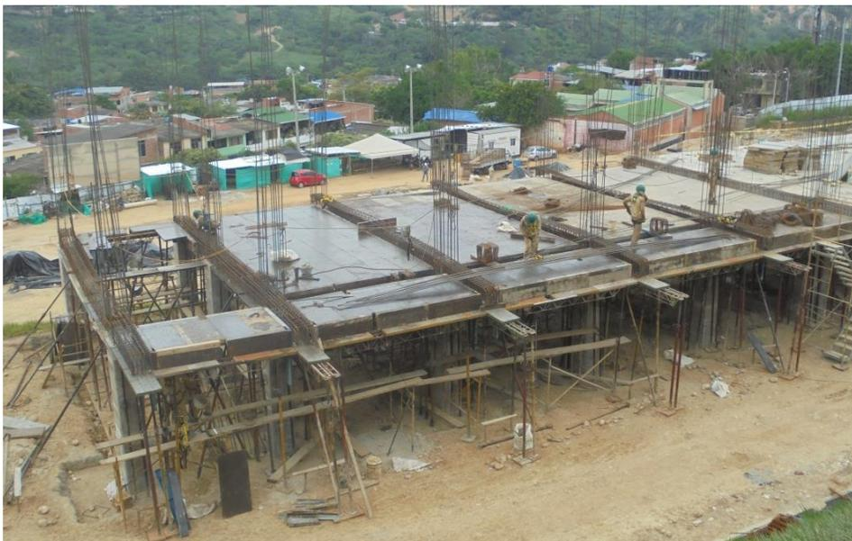
*Figura 10.* Armado de formaleta en vigas y placa N+3,50m Modulo B - edificio 3 – Colegio Mirador de Arenales.
