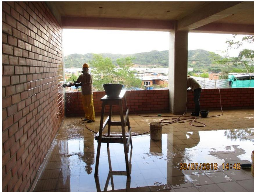
*Figura 27.* Lavado de pisos con ácido edificio 3 piso 2 – Colegio Puerto Madero.
