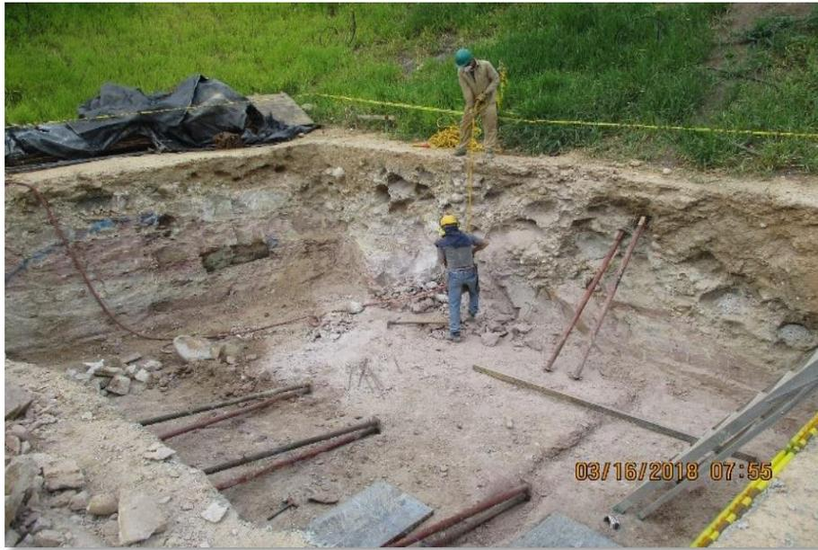
*Figura 29.* Demolición de rocas presentes en la excavación, tanque subterráneo – Colegio Puerto Madero.
