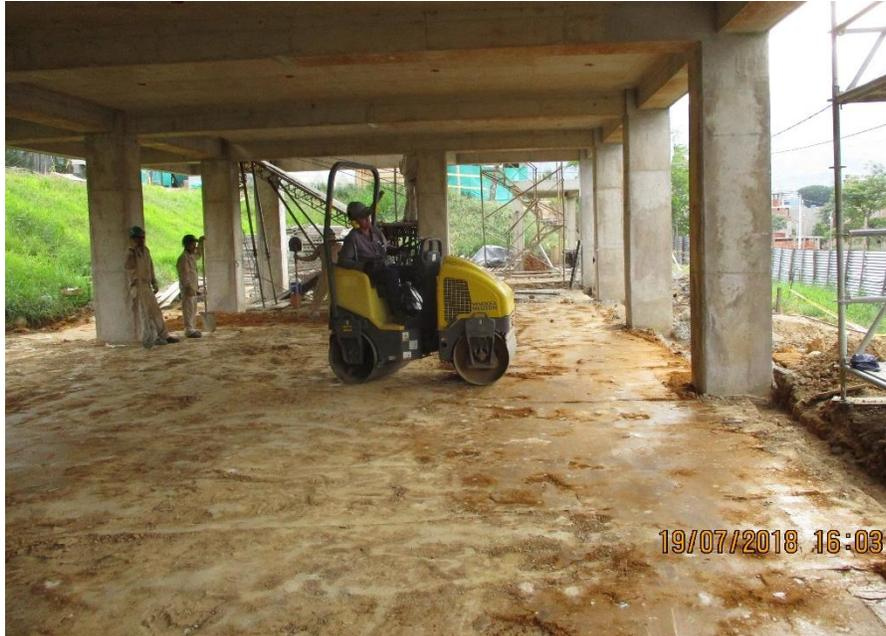
*Figura 21.* Compactación de suelo por medio del compactador en tándem vibrante articulado edificio 1 – Colegio Puerto Madero.
