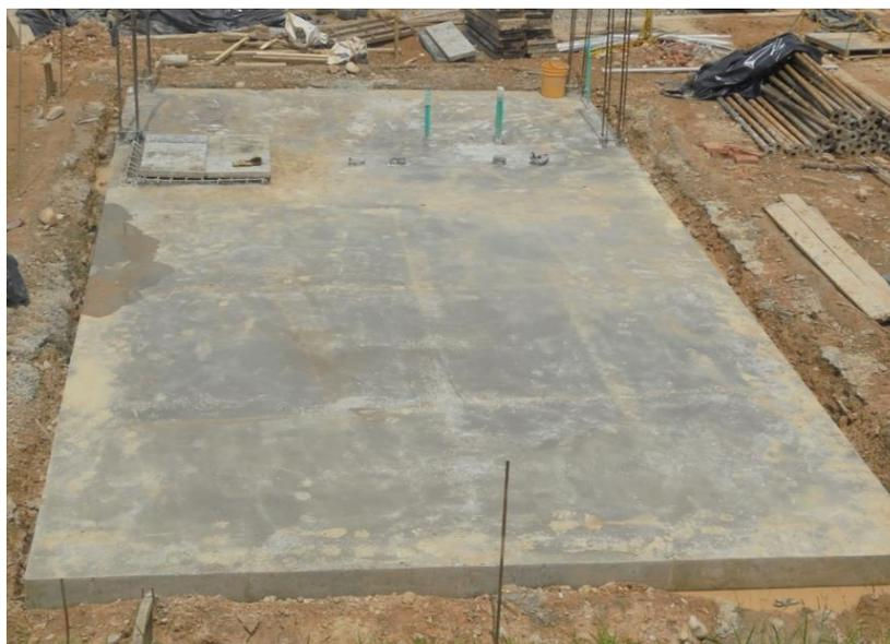
*Figura 34.* Placa aligerada superficial del tanque fundida en concreto – Colegio Puerto Madero.
