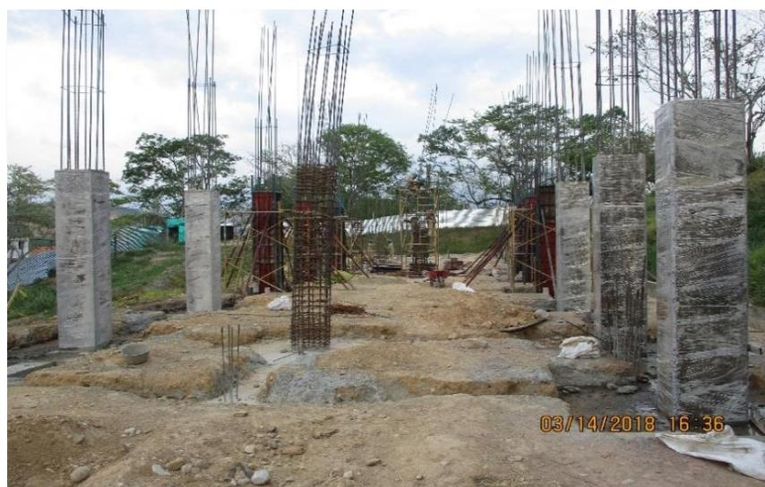
*Figura 9* Curado del concreto con Vinipel en columnas del primer nivel edificio 3 – Colegio Puerto Madero.
