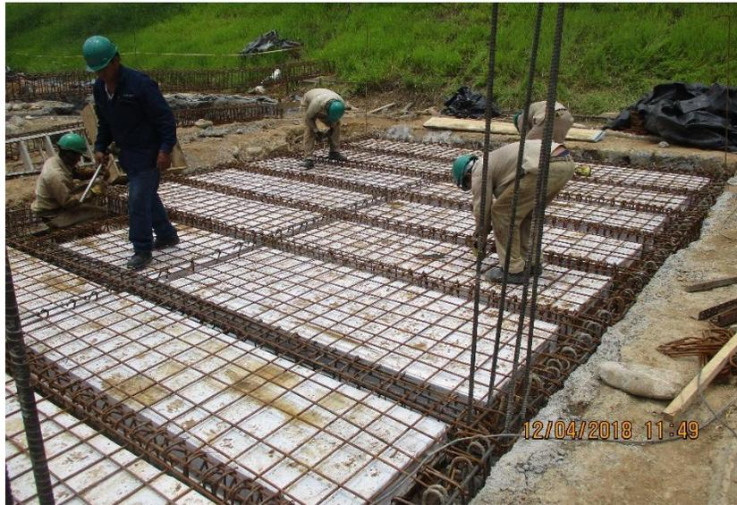
*Figura 33.* Armado de acero de fuerza para placa aligerada superficial del tanque – Colegio Puerto Madero.
