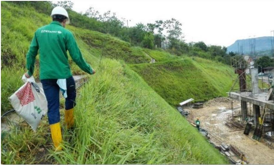
*Figura 36.* Labores de aplicación de abono en taludes – Colegio Mirador de Arenales.
