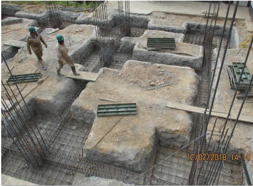
*Figura 4.* Amarre de acero cimentación edificio 2 – Colegio Mirador de Arenales.
