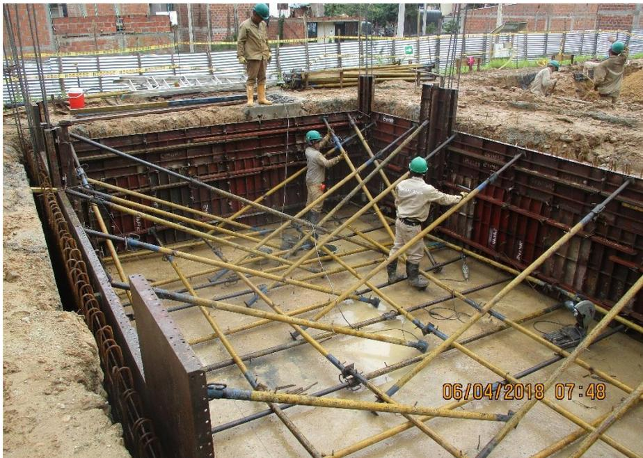
*Figura 32.* Armado de formaleta para las paredes del tanque subterráneo – Colegio Puerto Madero.
