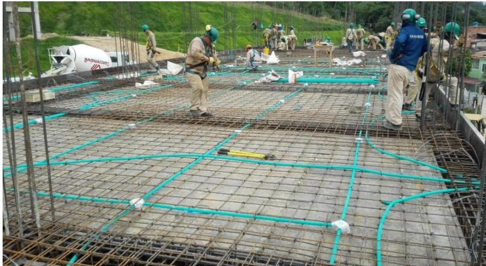
*Figura 11.* Armado de acero en vigas y placa N+3,50m Modulo B - edificio 3 – Colegio Mirador de Arenales.
