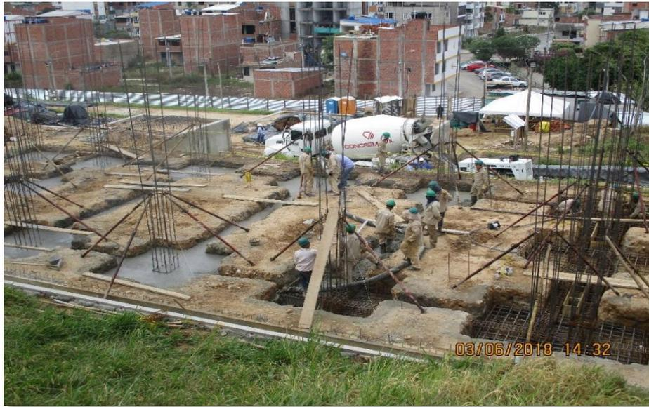
*Figura 5.* Fundida de cimentaciones edificio 3 – Colegio Puerto Madero.
