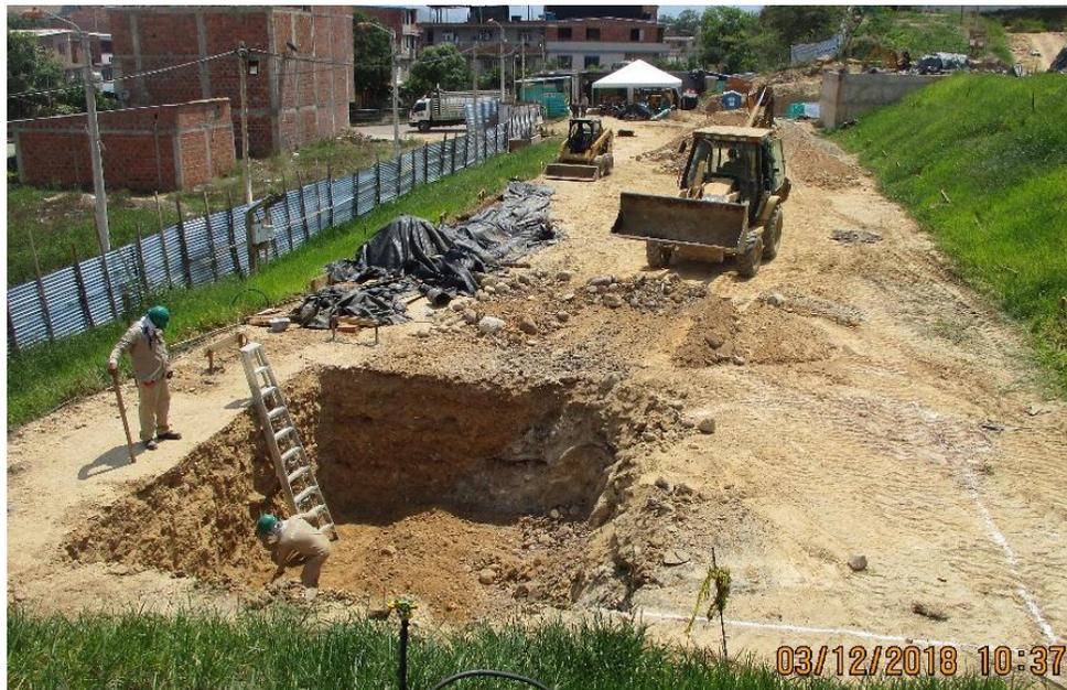
*Figura 28.* Replanteo y excavación de tanque subterráneo – Colegio Puerto Madero.
