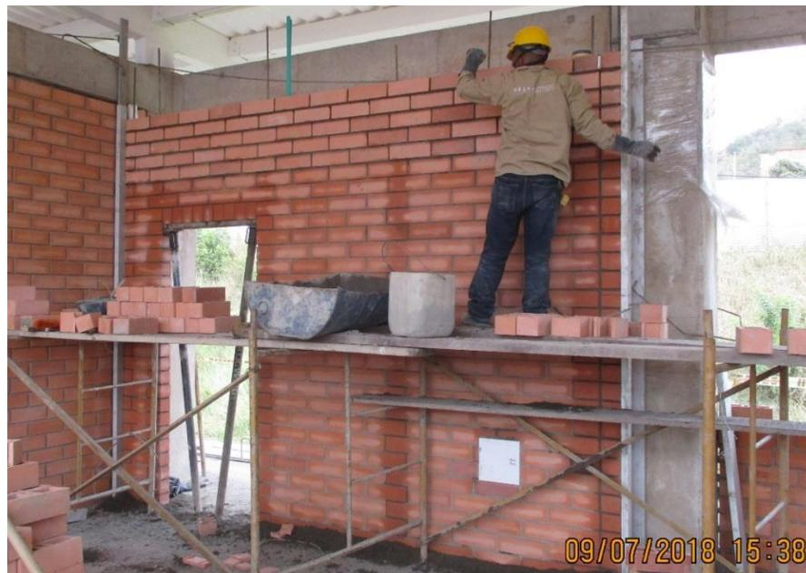
*Figura 14.* Limpieza de mampostería estructural edificio 3 piso 3– Colegio Puerto Madero.
