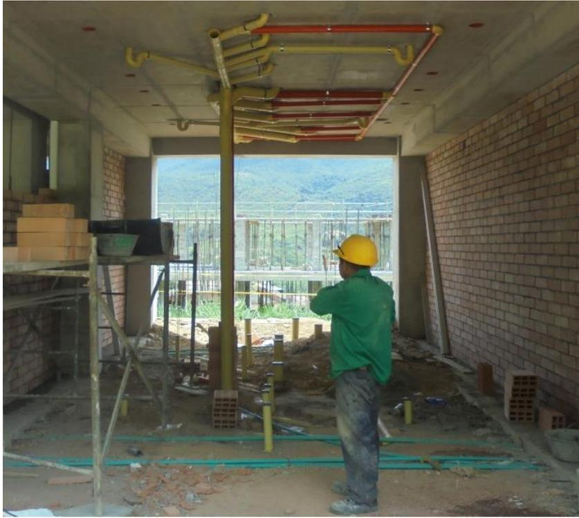
*Figura 16.* Instalación de tubería PVC edificio 3 piso 1 – Colegio Puerto Madero.
