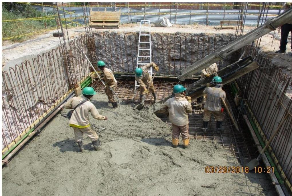
*Figura 31..* Vaciado de concreto en el fondo del tanque subterráneo – Colegio Puerto Madero
