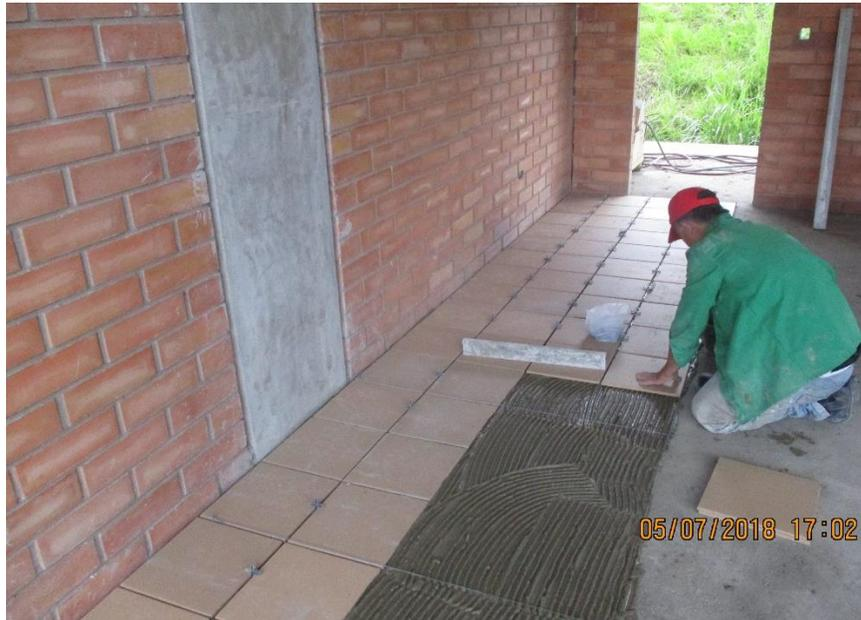
*Figura 26.* Pegado de enchape en piso edificio 3 piso 2 – Colegio Puerto Madero.
