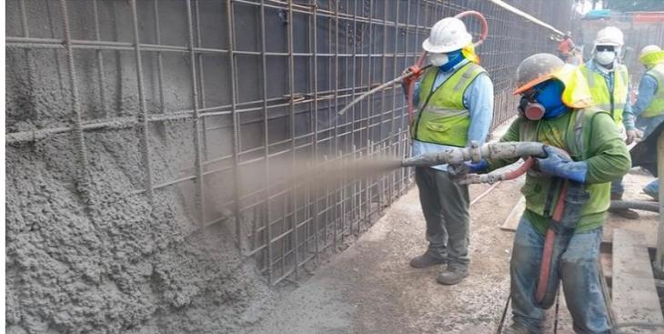
*Figura 1 . Concreto lanzado [22]*
