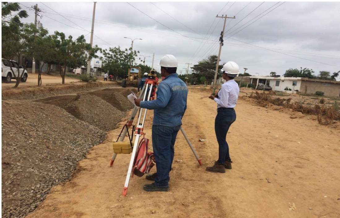
Imagen 10 nivelación de sub-base
