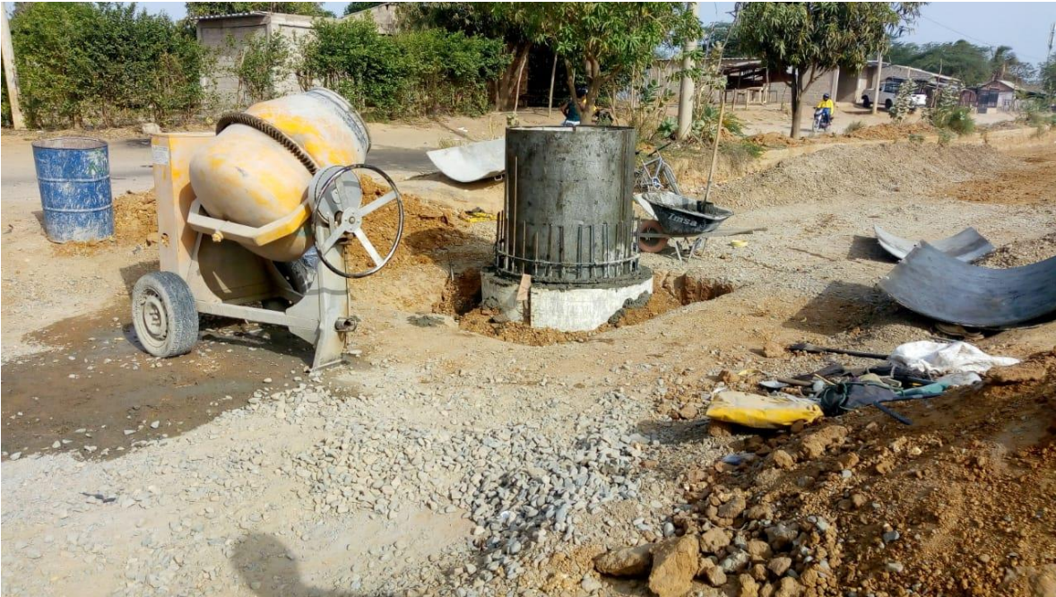
Imagen 13 fundida de cuerpo reforzado de pozo de inspección
