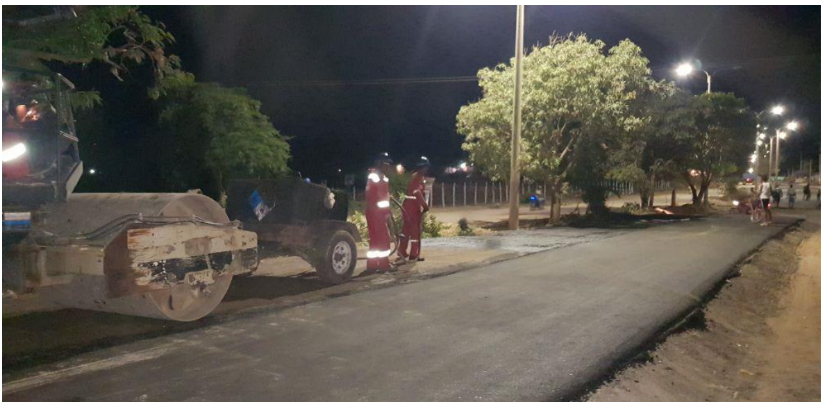
Imagen 20 instalación de mezcla asfáltica MCD 2
