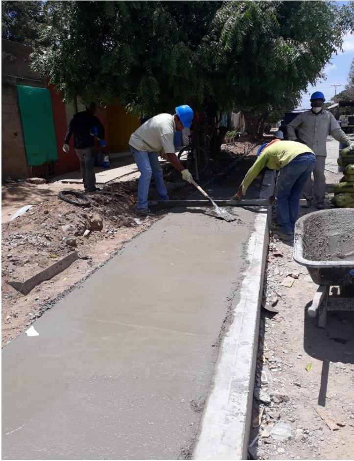
Imagen 21 instalación de andenes y bordillos
