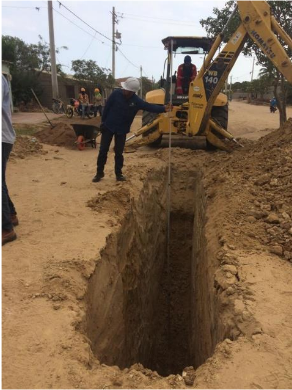
Imagen 1 excavación para alcantarillado
