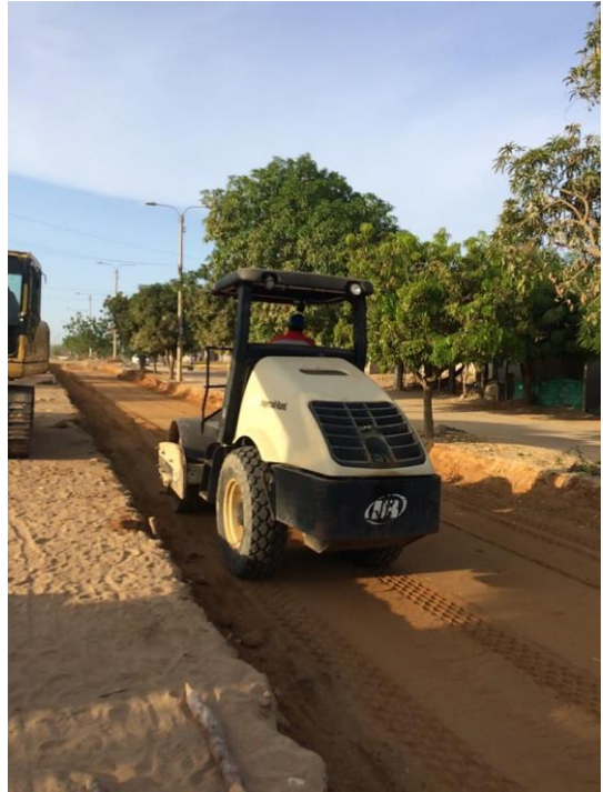
Imagen 7 compactación de sub-rasante
