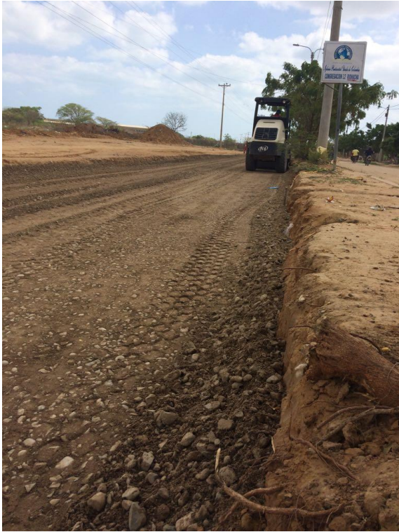
Imagen 14 compactación de la sub-base
