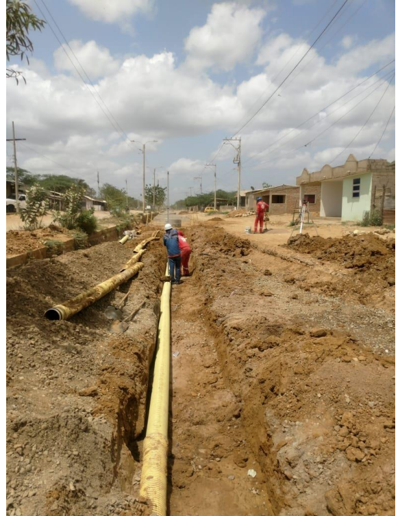
Imagen 18 instalación tramo faltante
