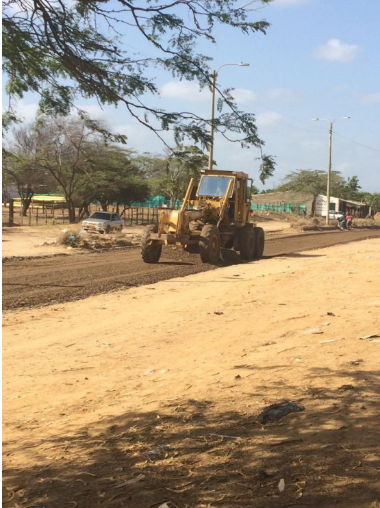
Imagen 11 conformación de sub-base
