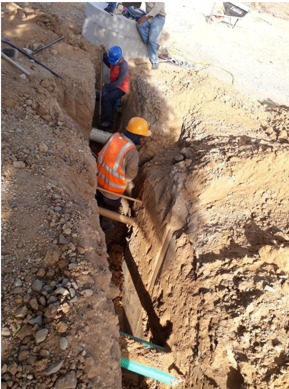
Imagen 17 excavación tramo faltante
