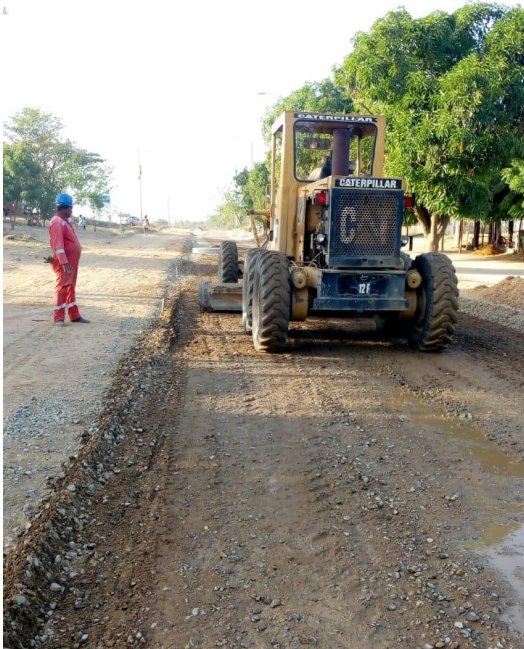
Imagen 16 conformación capa I de base
