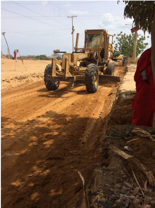
Imagen 8 conformación de sub-rasante
