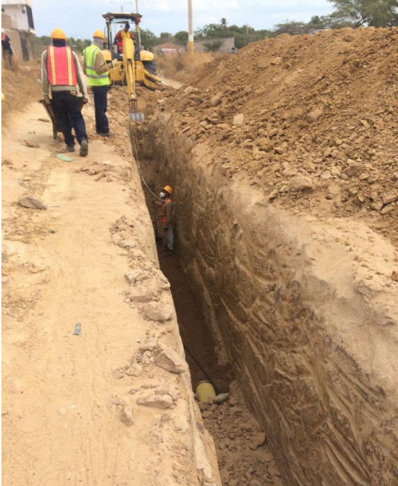
Imagen 3 instalación de tubería.
