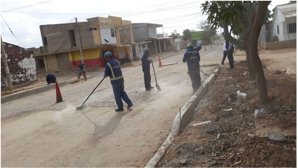
Imagen 19 limpieza para aplicación de emulsión.
