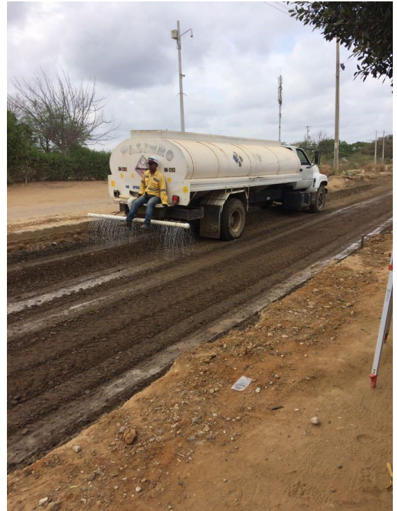
Imagen 9 humectación de la sub-base
