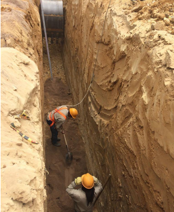
Imagen 2 instalación de cama de arena.
