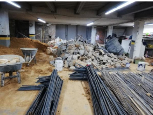
Imagen 10 Almacencnamiento de material.
