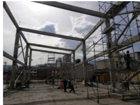
Imagen 34 Ampliación realizada para elevar la cubierta a 15,72 metros..
