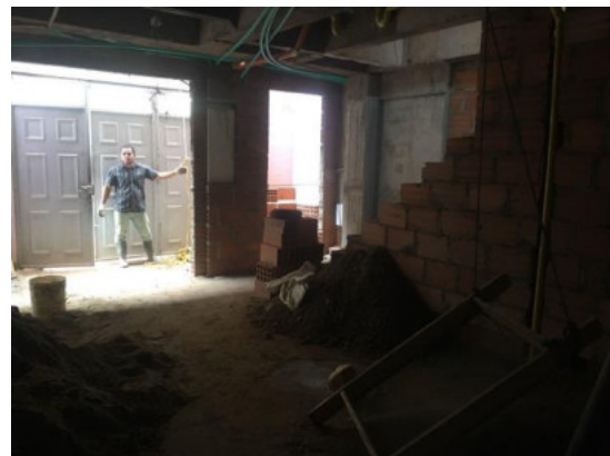
Imagen 39 Obras realizadas en el primer piso.
