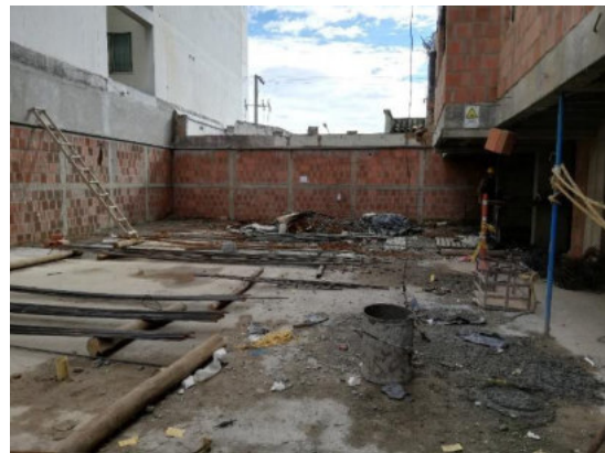
Imagen 14 Fotografía aislamiento posterior edificio Andes 22.
