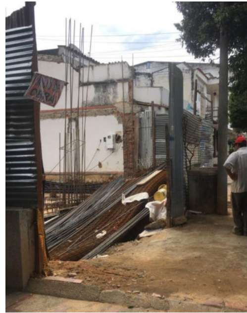
Imagen 3 Fotografía de elementos de acero almacenados dentro del cerramiento de la obra.
