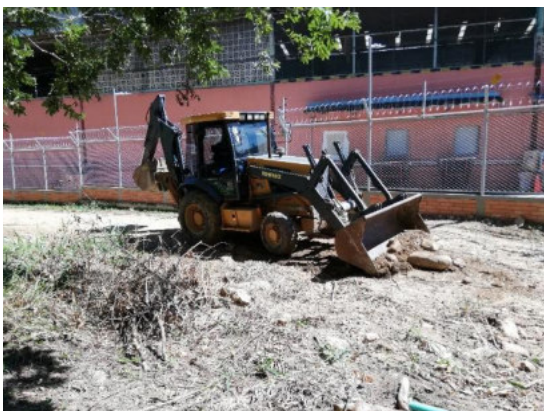
Imagen 24 Proceso de limpieza del terreno cedido.
