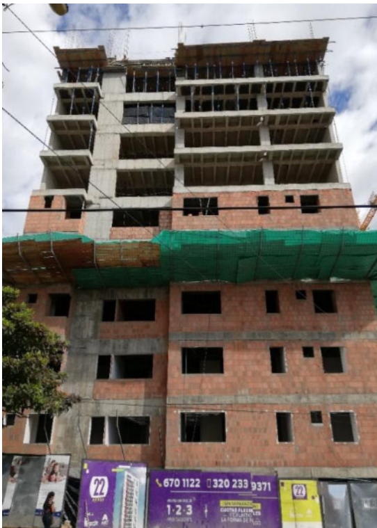
Imagen 13 fachada principal edificio Andes 22.
