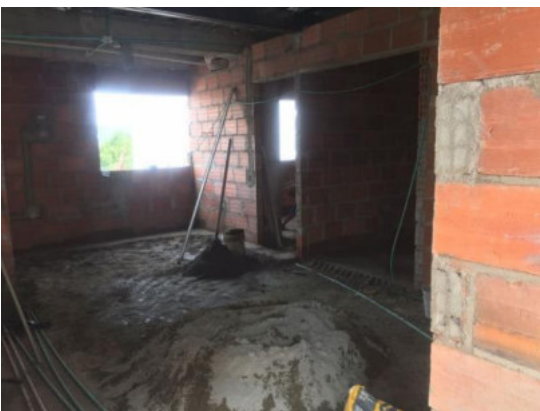
Imagen 37 Obras realizadas en Segundo piso.
