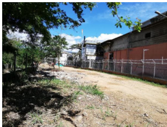
Imagen 25 Nuevo cerramiento y terreno cedido al AMB.
