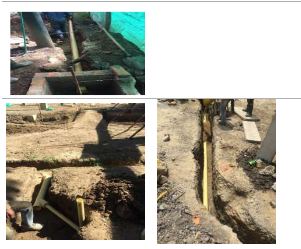
Ilustración 17. Memorias fotográficas de la instalación de la red hidrosanitaria. (Fuente: Autor)
