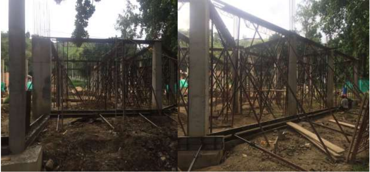
Ilustración 14. Armado de fondos para las vigas áreas sección 1- N+3,70 m
