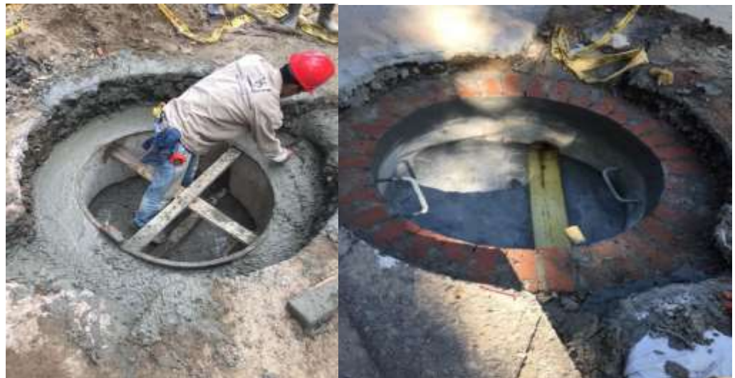
Ilustración 5 Construcción del pozo de inspección \Phi=1,20 m
