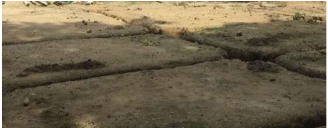
Ilustración (Fuente: Autor) 4 Zanjas para las vigas de amarre
