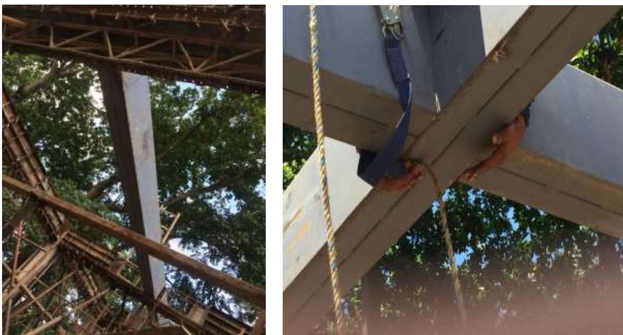
Ilustración 25. Instalación de perlínes en obra
