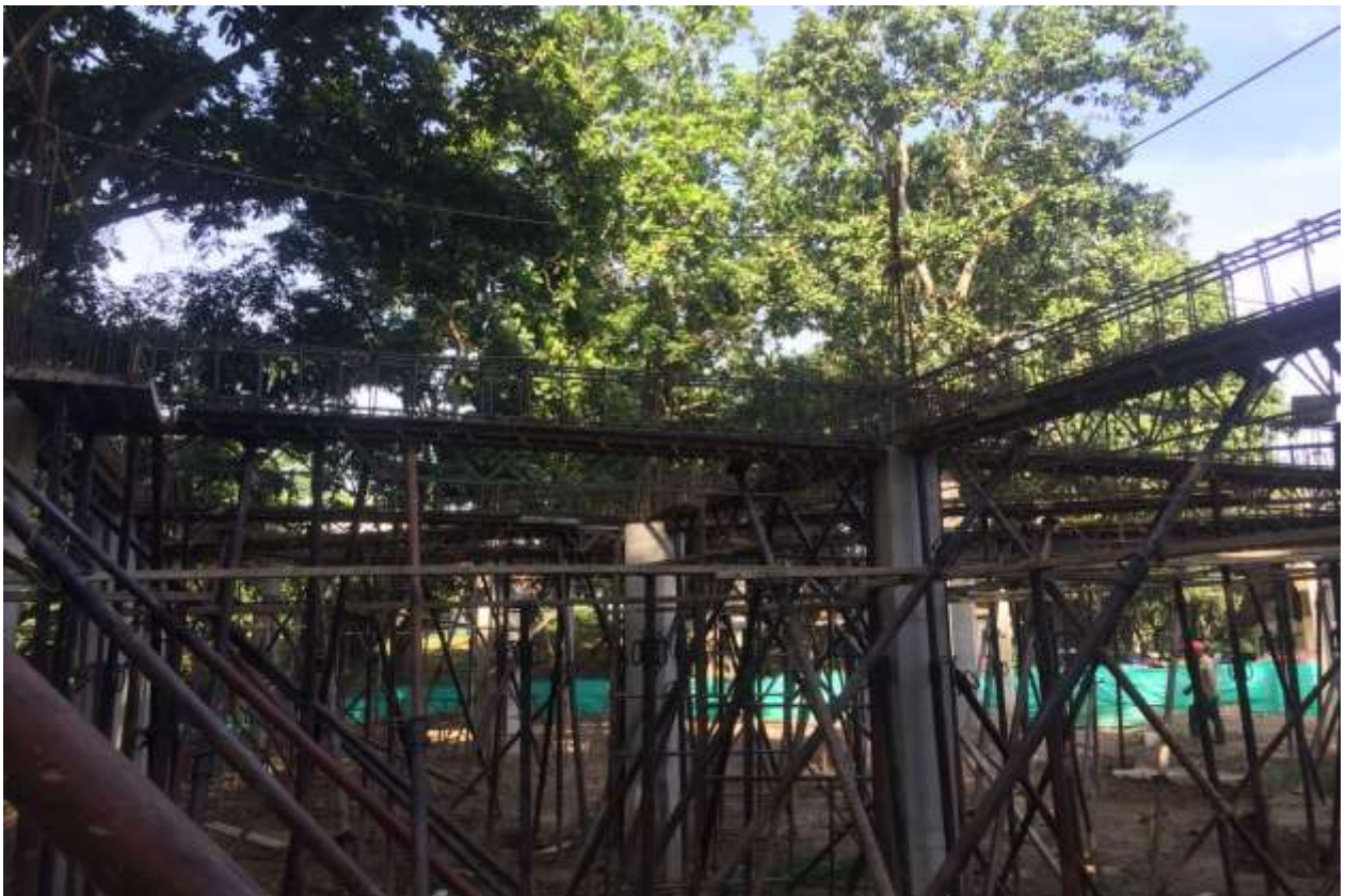
Ilustración 15. Armado vigas aéreas sección 1- N+3,70m
