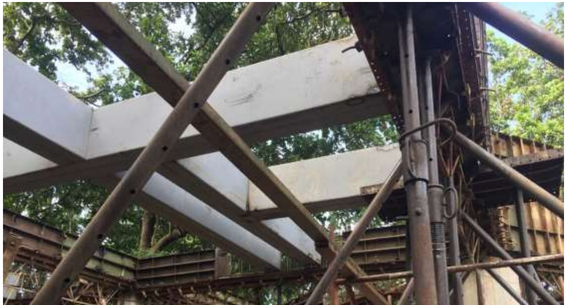
Ilustración 22. Unión tipo riostra-viga en perlin. Fuente: Plano E-002, 02/04, Detalle placa cubierta, Diseño de Jorge E Cuadros.
