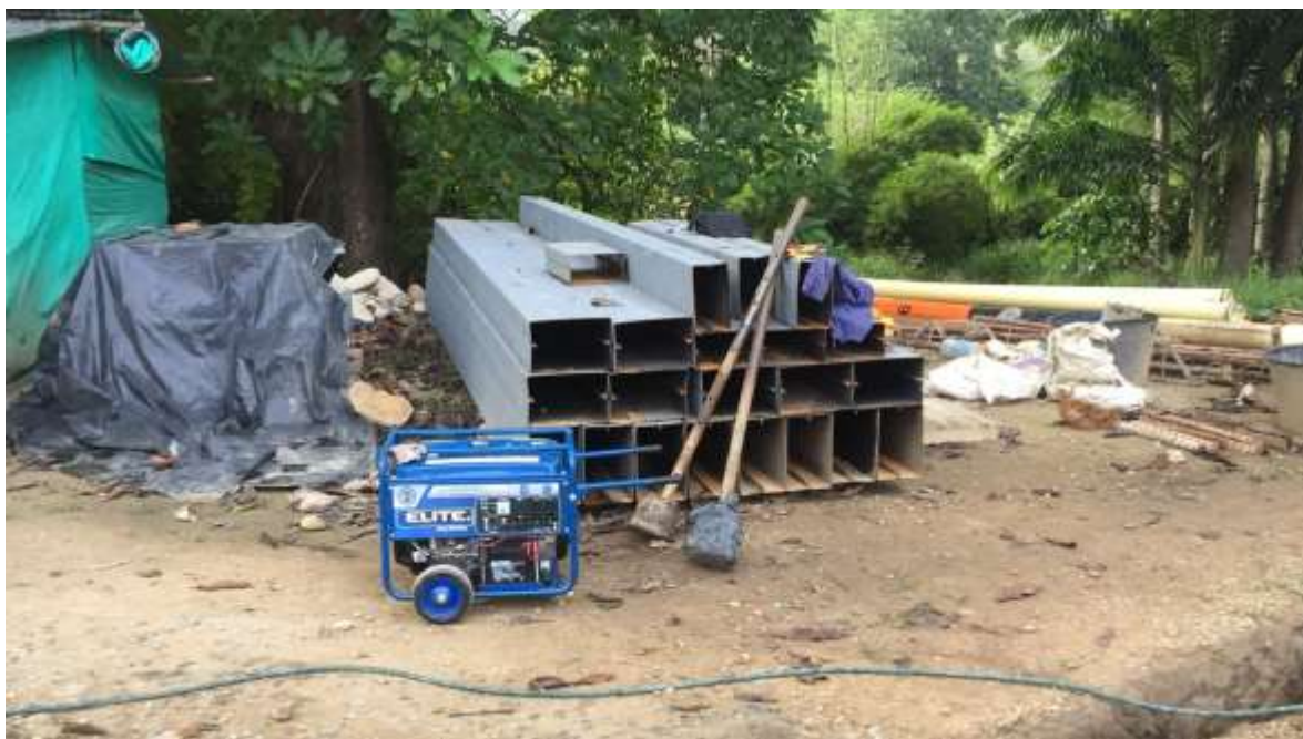
Ilustración 24. Perlínes en obra
