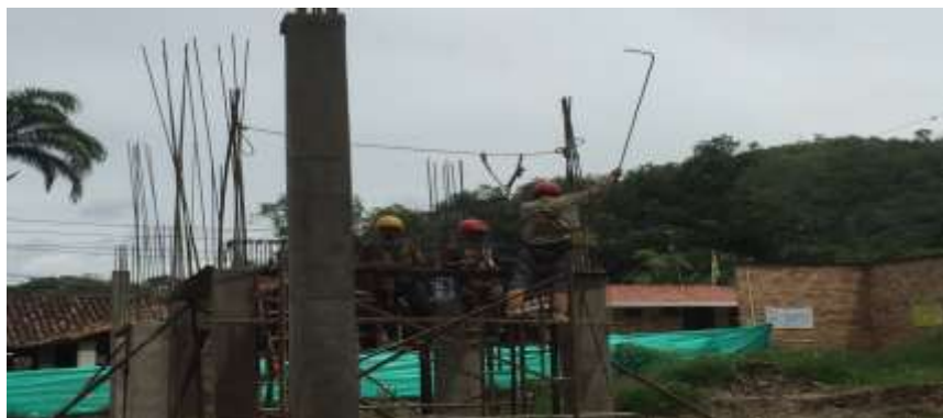
Ilustración 13. Armado vigas aéreas sección 1- N+3,20m
