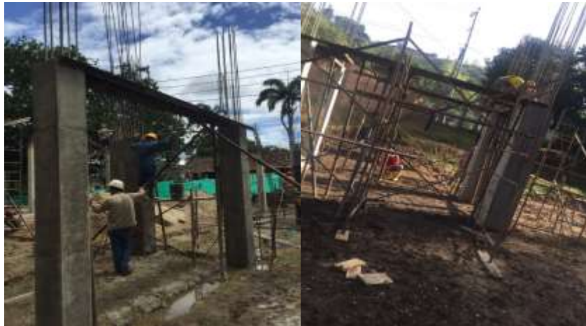
Ilustración 12. Armado de fondos para las vigas áreas sección 1- N+3,20 m
