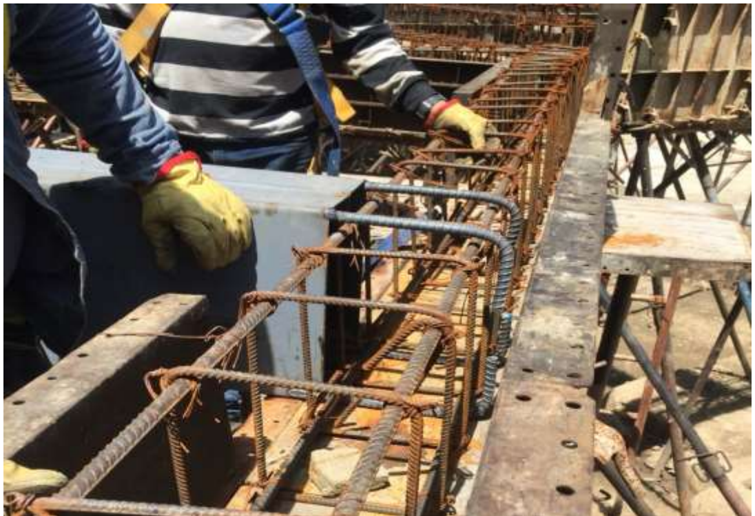
Ilustración 21. Anclaje puesto en obra.
