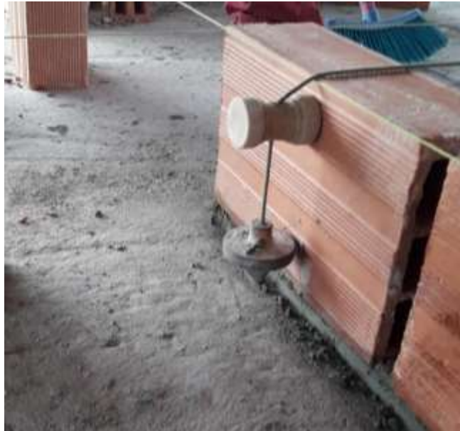
Figura 19: Aplomo de ladrillo
