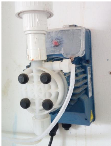
Imagen 14. Bomba dosificadora de cloro
