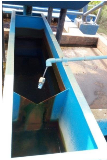
Imagen 5. Canal de paso y vertedero
