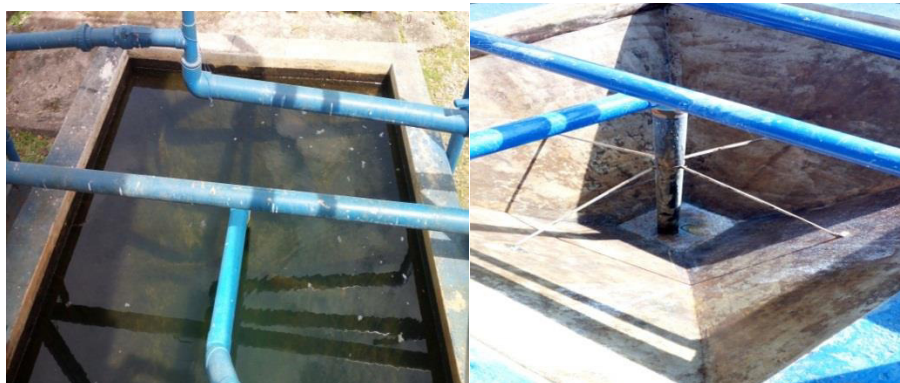
Imagen 7. Unidad de Floculación Hidráulica
