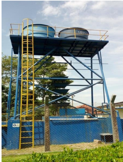
Imagen 15. Tanques de Reserva de agua tratada
