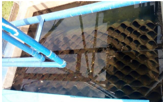
Imagen 8. Sedimentador de Alta Tasa
