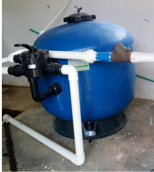
Imagen 13. Filtro anaerobio de flujo ascendente
