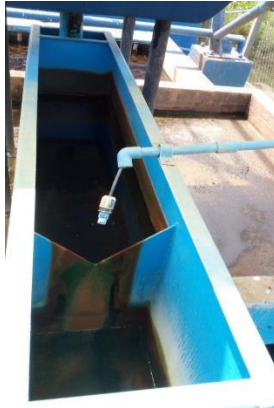
Imagen 7. Canal de paso y vertedero
