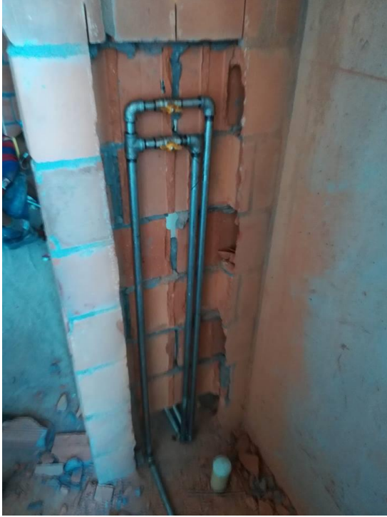
Ilustración 18. Fijación de la tubería en sitio
