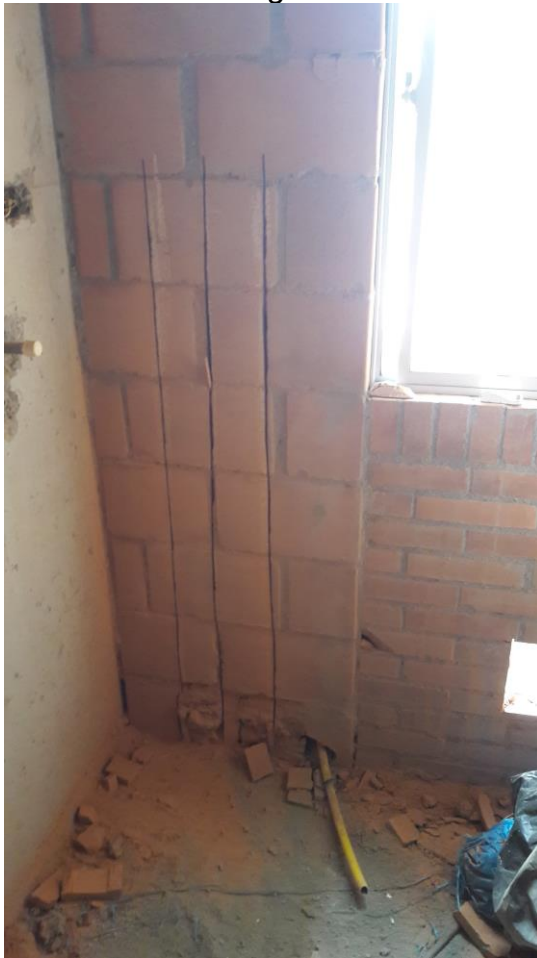
Ilustración 12. Regateo de los muros
