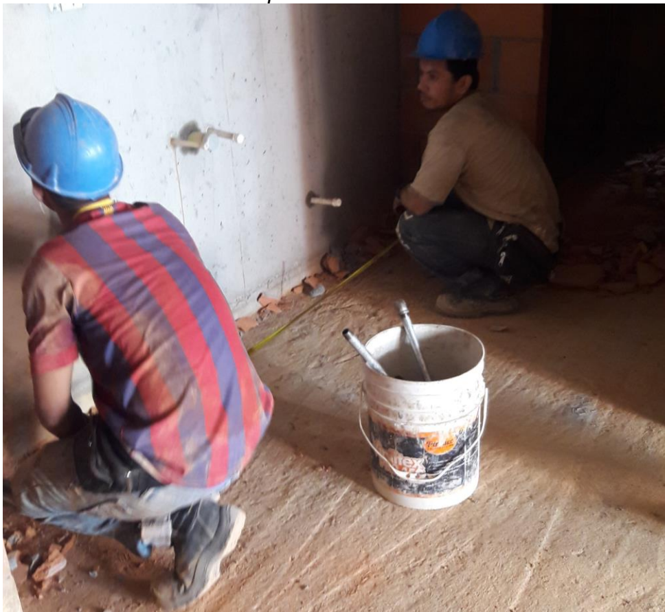
Ilustración 13. Toma de medidas para corte de tuberías
