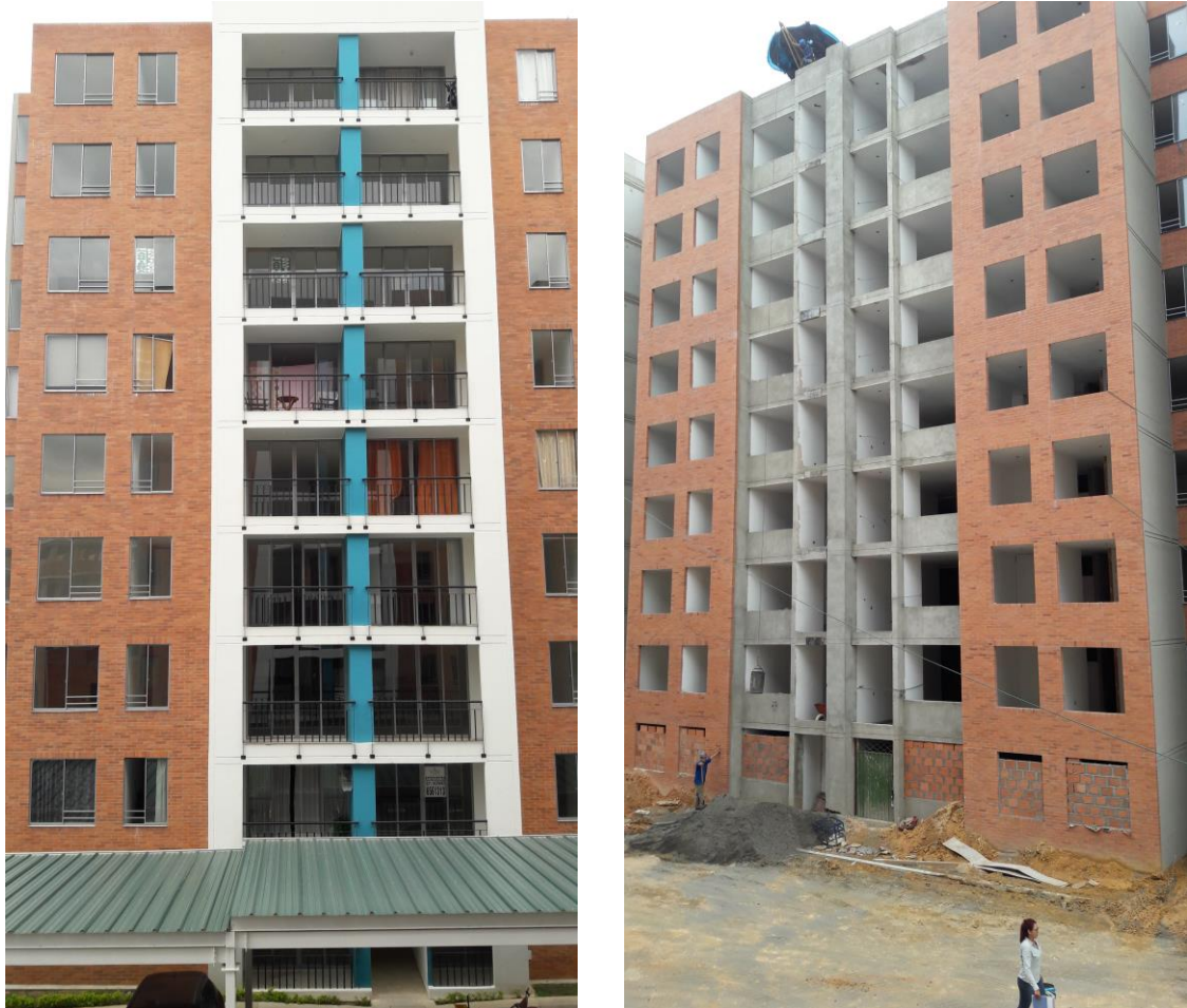
Ilustración 10. Estados de avance en la construcción de las torres
