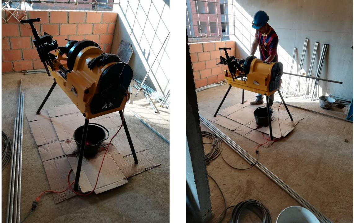
Ilustración 15. Elaboración del roscado de la tubería
