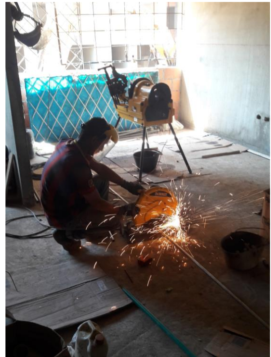
Ilustración 14. Corte de la tubería con tronzadora industrial
