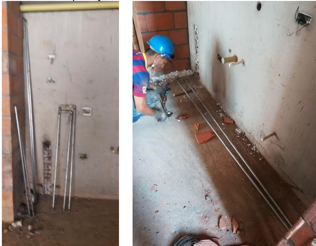
Ilustración 17. Transporte y Ubicación de la tubería
