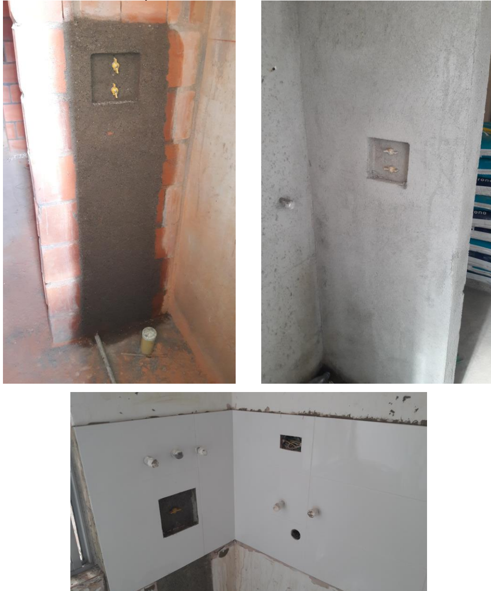
Ilustración 20. Acabados para tuberías embebidas
