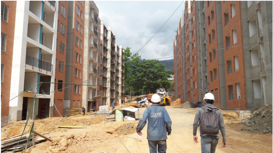
Ilustración 9. Instalación de redes internas en torres de apartamentos
