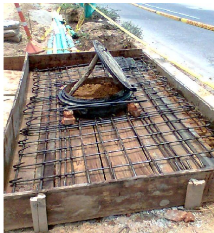
Figura 20. Armado losa superior
