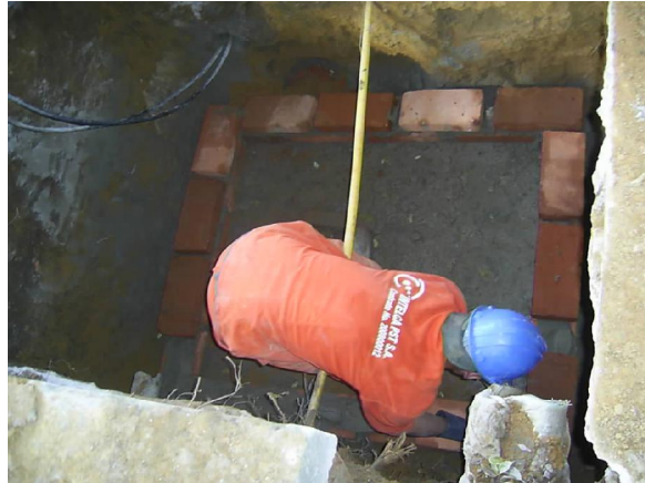
Figura 17. Mampostería cámara tipo D
