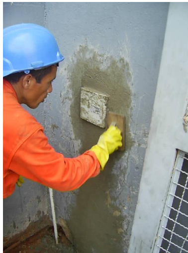
Figura 25. Instalación de acometidas.
