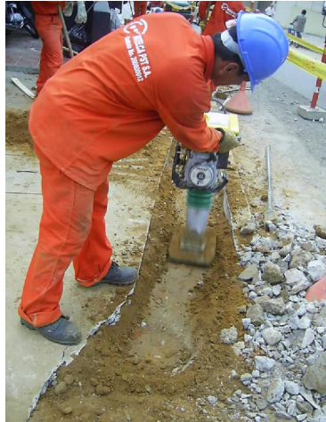
Figura 23. Compactación mecánica.
