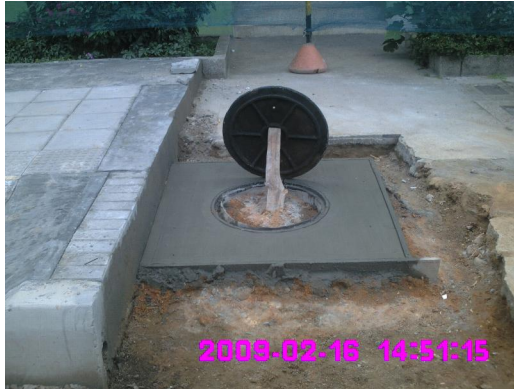
Figura 21. Tapa requerida para acceso a las cámaras.
