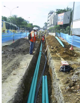
Figura 5. Zanja única carrera 27.
