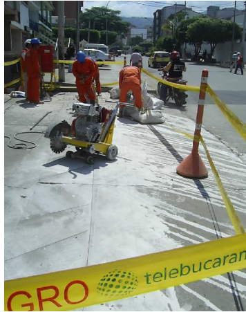
Figura 6. Localización y corte de zanja.
