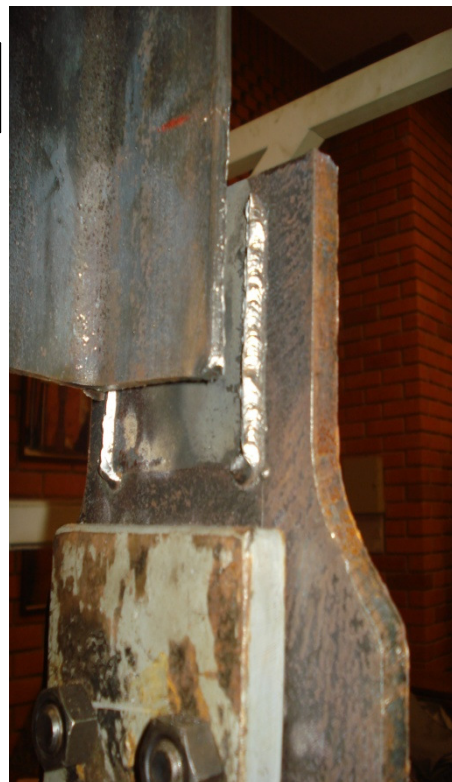
Foto N° 11. Ruptura de ct -65
