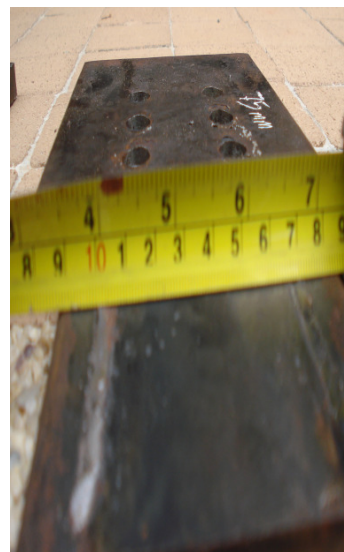
Foto N° 19. Garganta de soldadura
