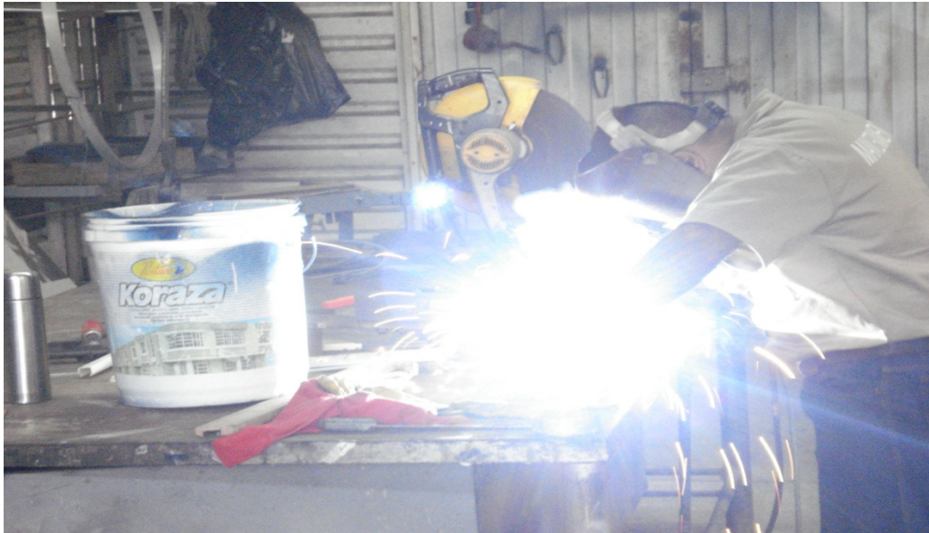
Foto N° 5. Proceso de soldadura de platinas con perfiles angulares
