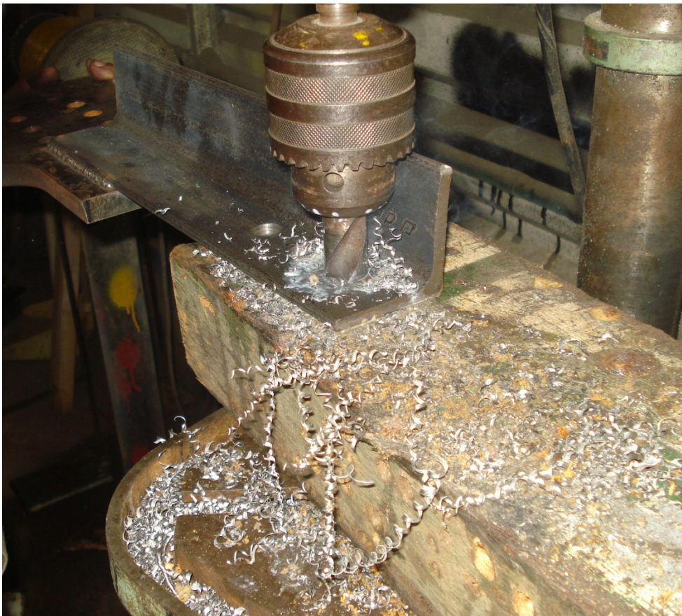
Foto N° 12. Proceso de aumento de diámetro de perforaciones
