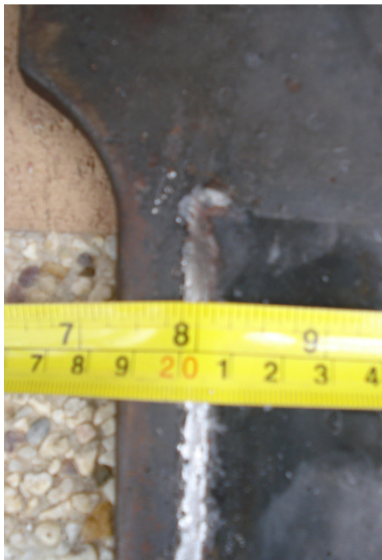
Foto N° 18. Garganta de soldadura
