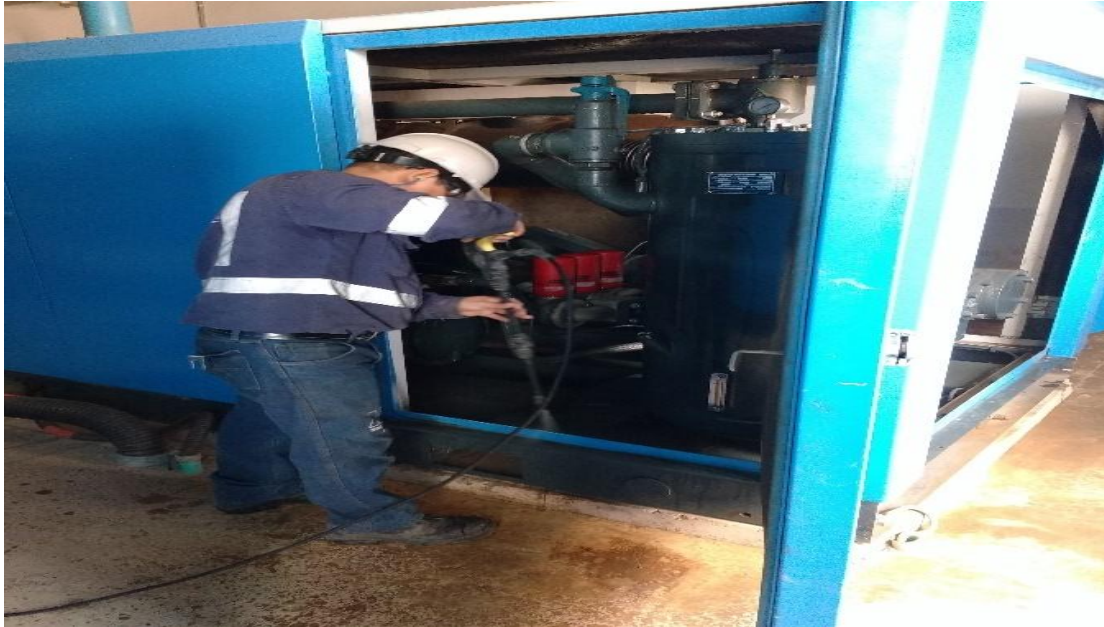
Figura 13. Limpieza compresores.
