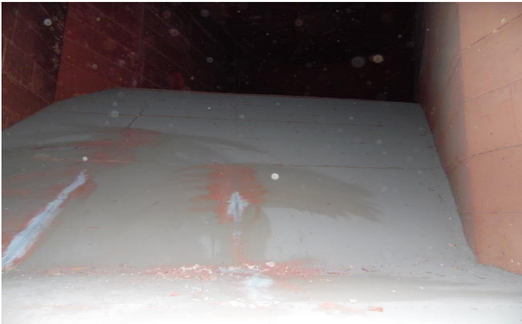
Figura 37. Refractario paso posterior reparado.
