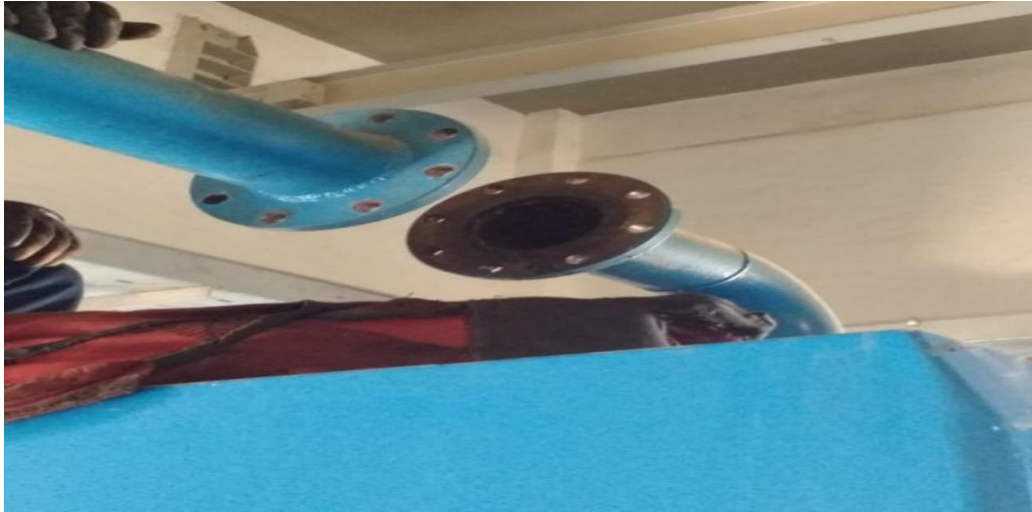
Figura 23. Desmonte junta expansiva.
