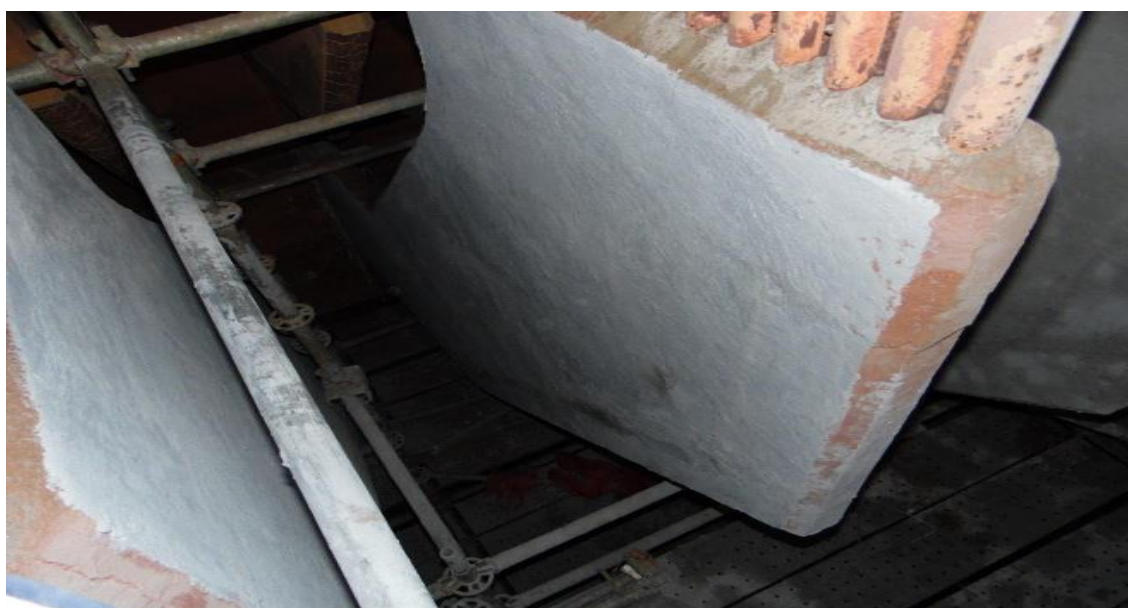
Figura 33, Paredes recalentadores de media reparadas.
