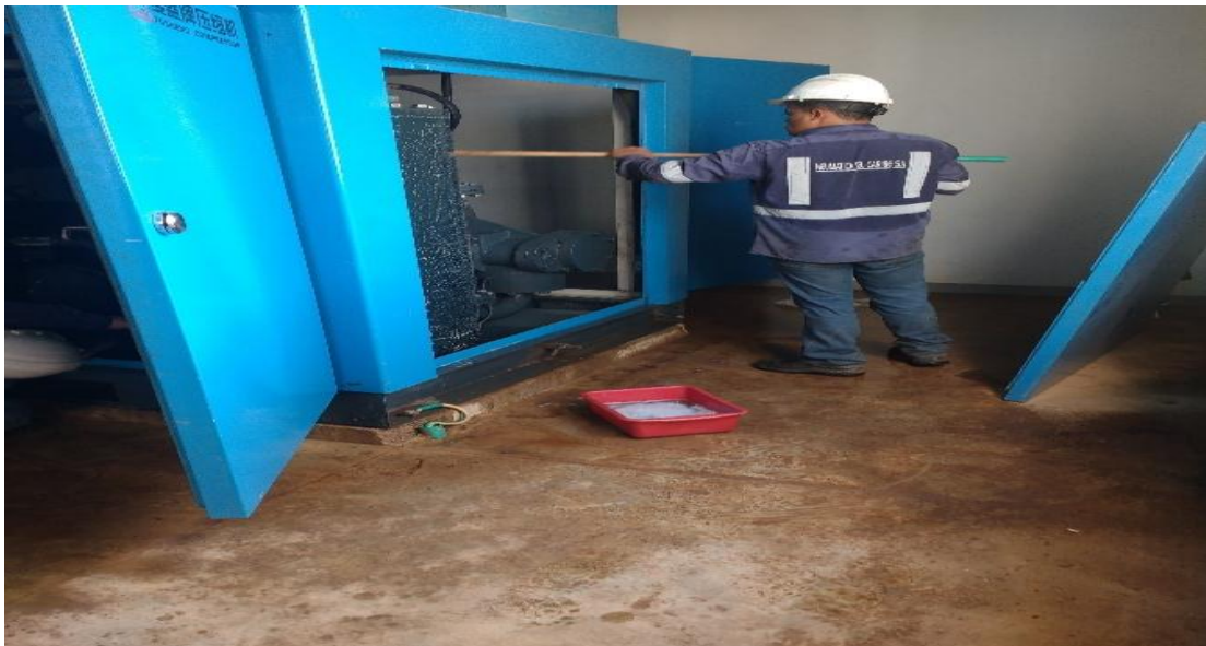
Figura 14. Limpieza general compresores.
