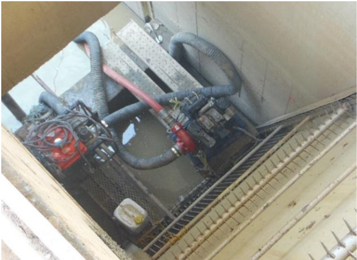
Figura 38. Dragado piscina exterior de bocatoma.
