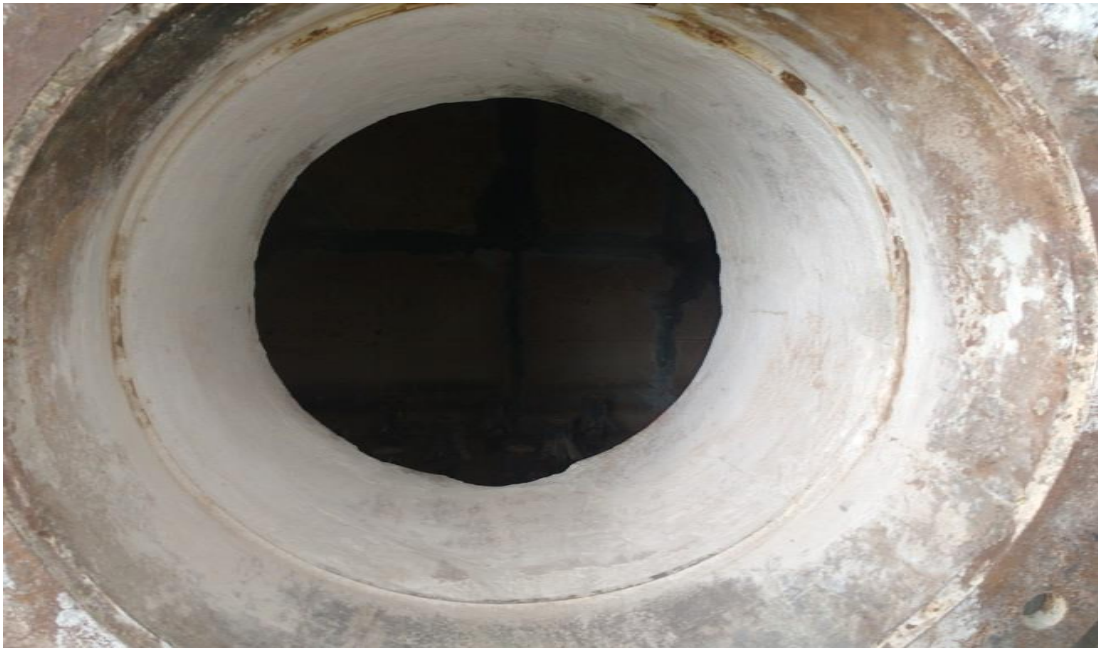
Figura 35. Manhole reparado.
