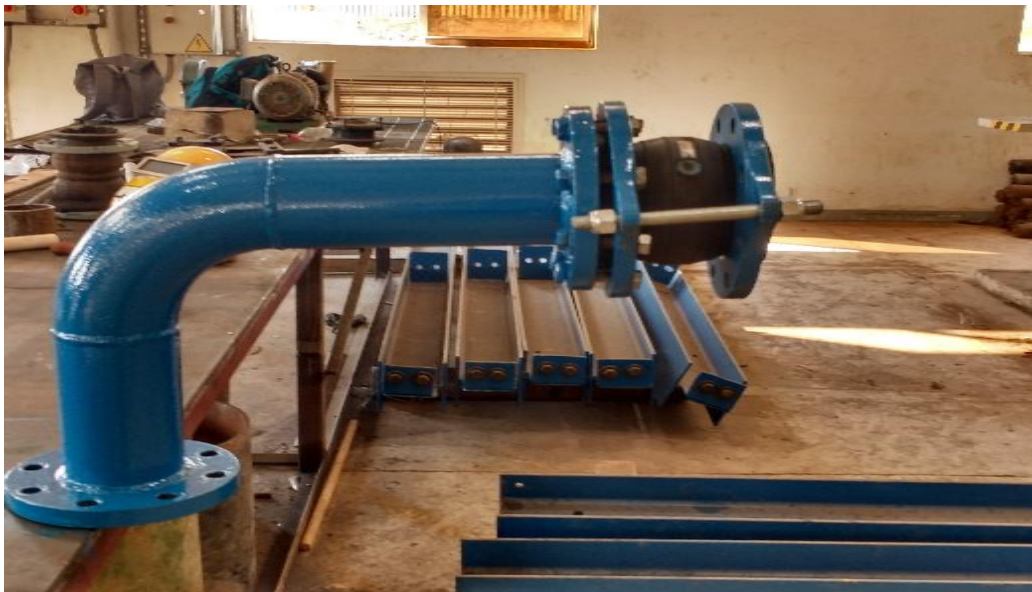
Figura 24. Mantenimiento tubería de junta expansiva.
