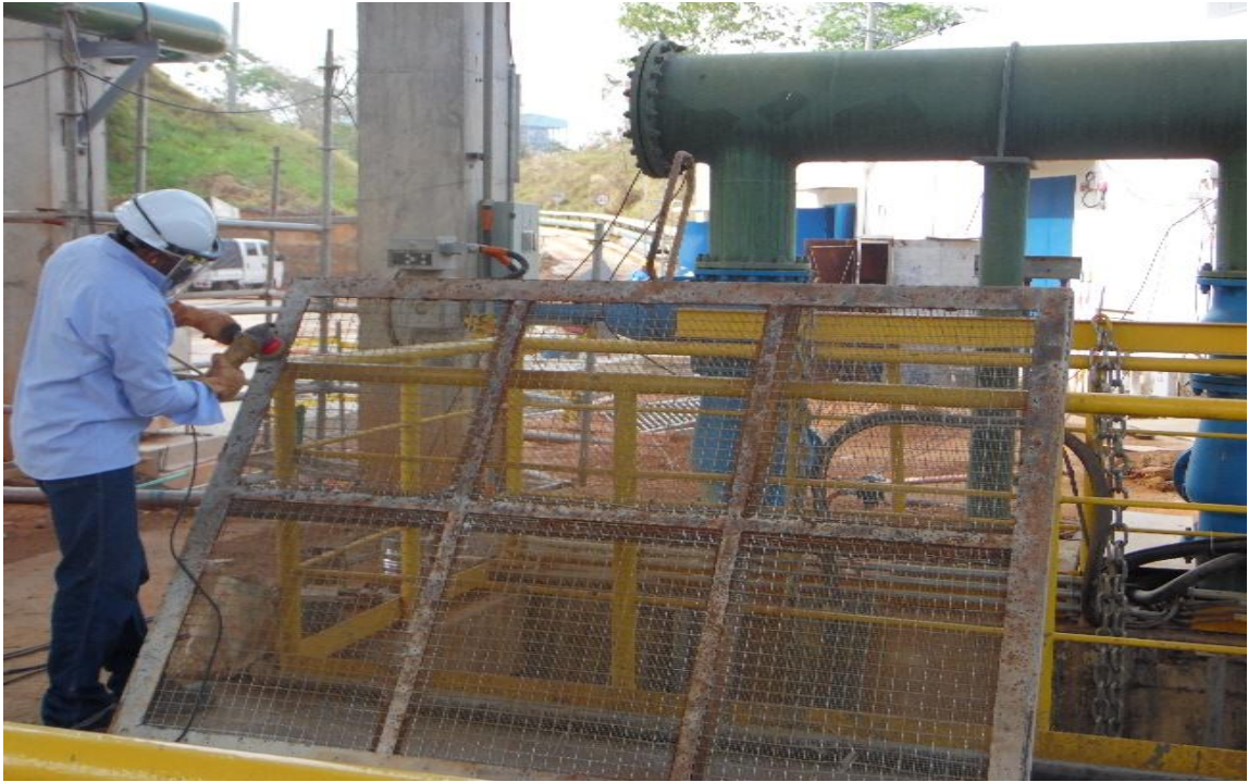
Figura 39. Mantenimiento rejilla de filtración.
