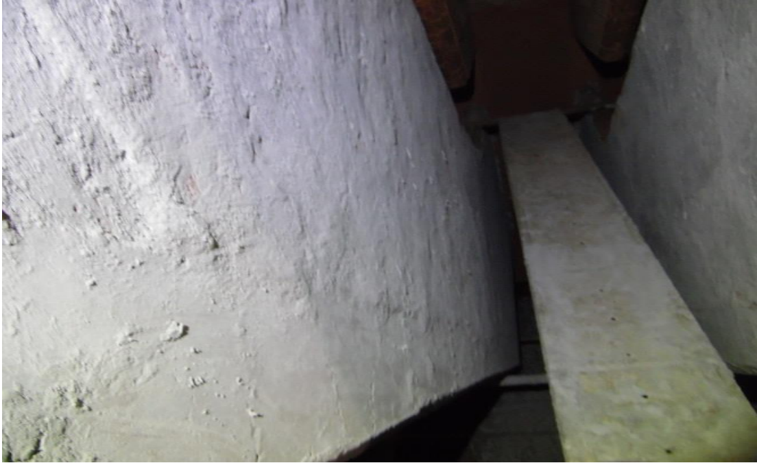
Figura 34. Paredes recalentadores de alta reparados.
