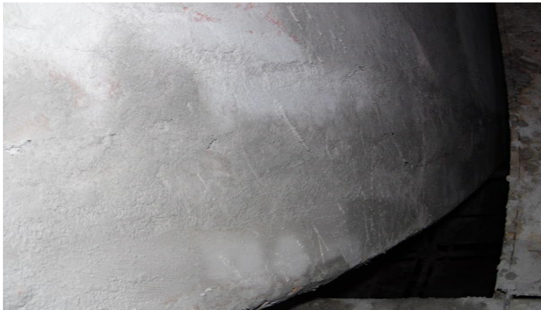
Figura 32. Paredes recalentador reparadas.
