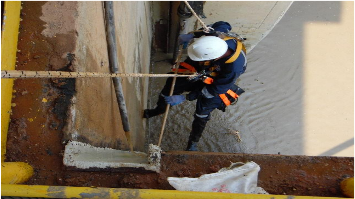
Figura 41. Mantenimiento de rieles compuerta principal.
