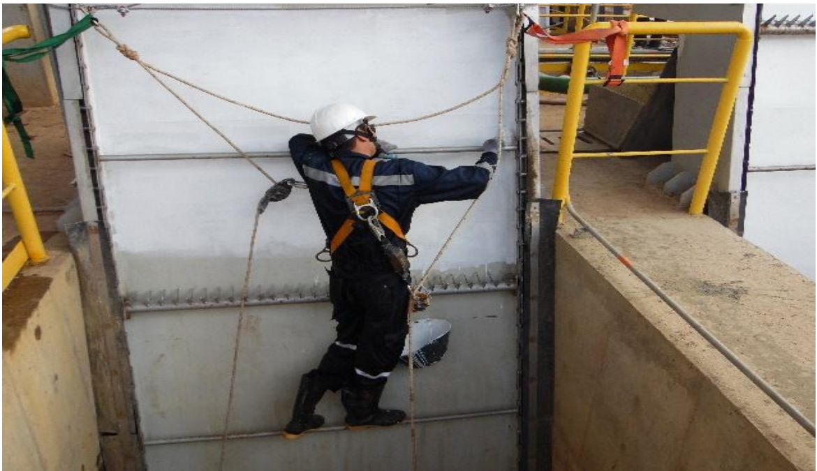
Figura 42. Pintura de rastrillo giratorio.
