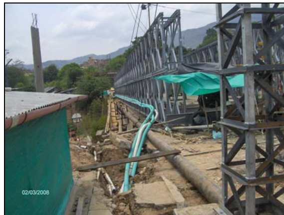
Figura 3. Reparación puente Flandes, Palenque-Girón
