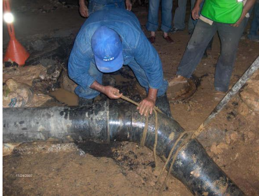
Figura 2. Daño puente cañaveral
