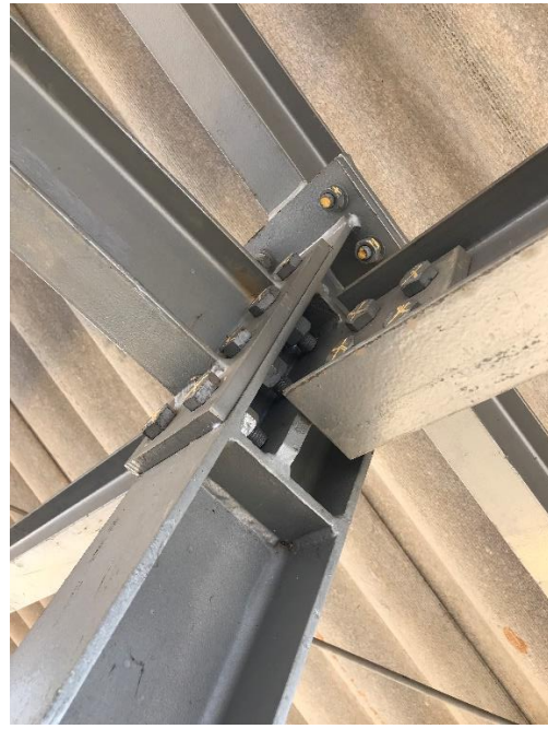
Ilustración 24. Visita de obra.
