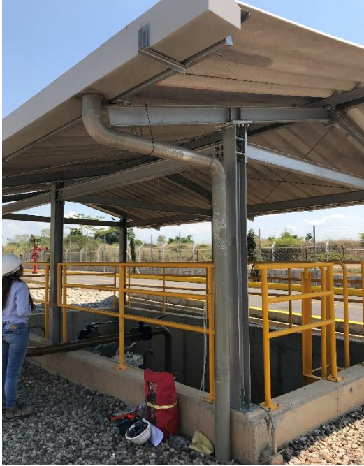
Ilustración 23. Visita de obra
