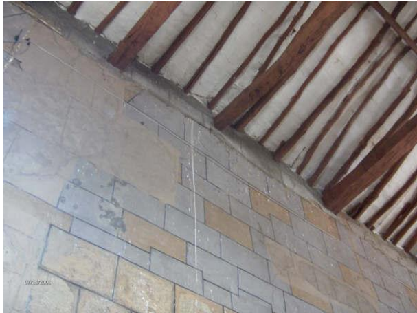
Figura 17. Empalme Cubierta y Muro Lateral Derecho.
