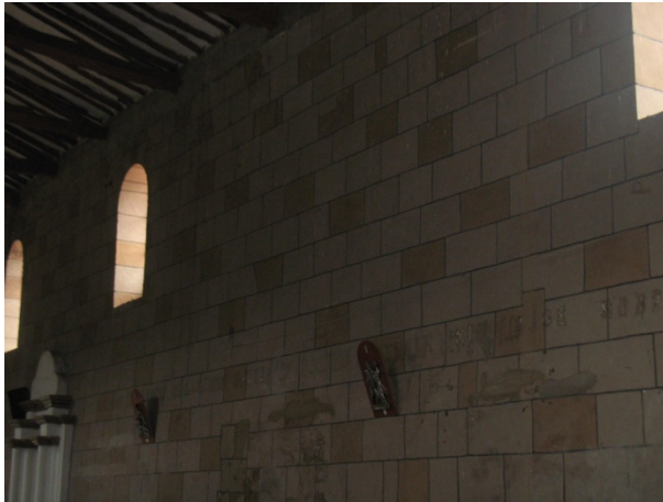
Figura 15. Muro Lateral Derecho
