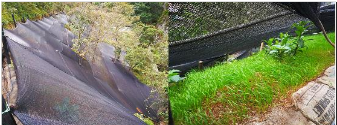
Fotografía 6: poli-sombra en el talud y germinación de la semilla
