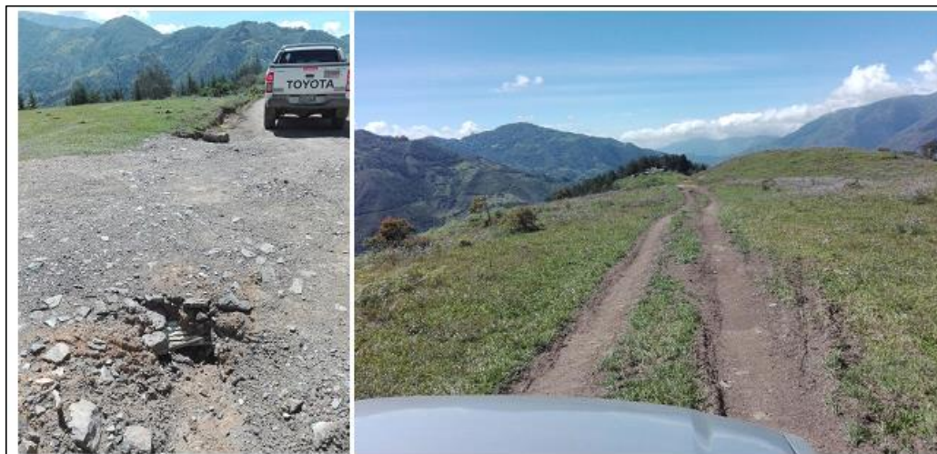
Fotografía 10: Estado del sistema de drenaje (izquierda), estado de la vía (derecha)
