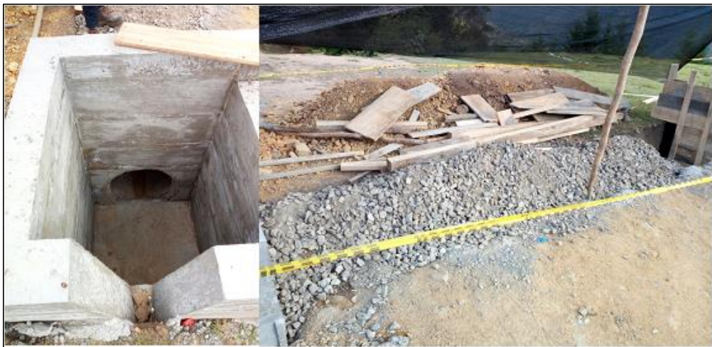
Fotografía 14: retiro de formaleta y aplicación del material de relleno.
