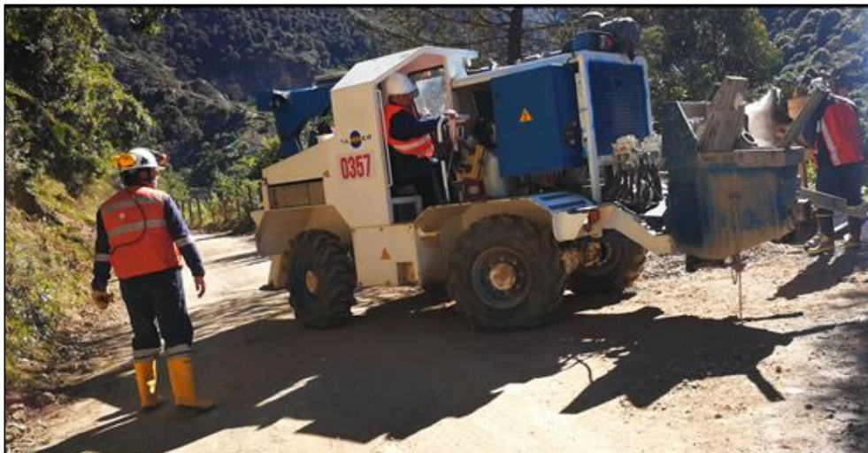
Fotografía 16: maquina empleada para el bombeo del concreto. Robot shotcrete Alpha20
