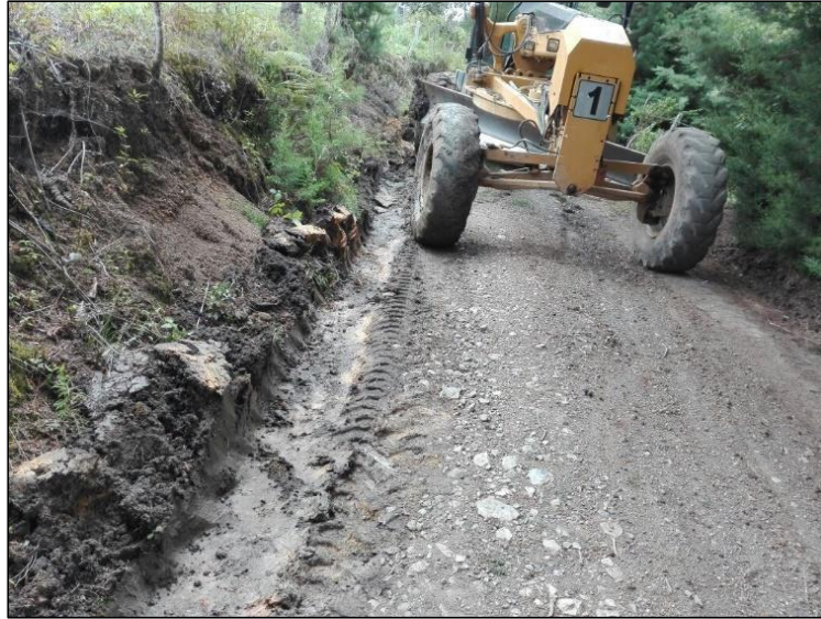
Fotografía 11: motoniveladora desarrollando trabajo limpieza de cuneta y nivelación de la vía
