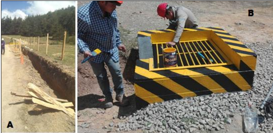
Fotografía 15: A) delimitación con horcones y alambre de púa. B) pintada de la alcantarilla
