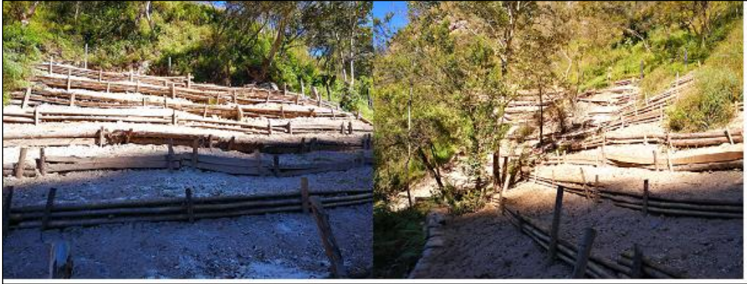
Fotografía 5: terrazas para la estabilización del talud para biotecnología.
