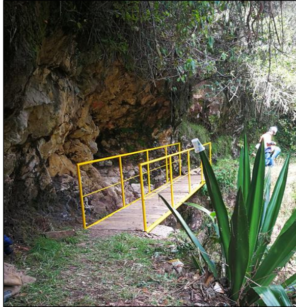
Fotografía 8: Puente metálico provisional para paso del personal de obra.
