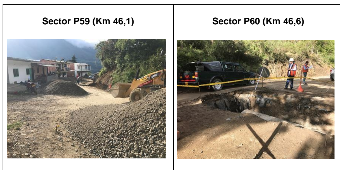
Ilustración 16: trabajos sobre la vía a fecha de 9 de julio de 2017
