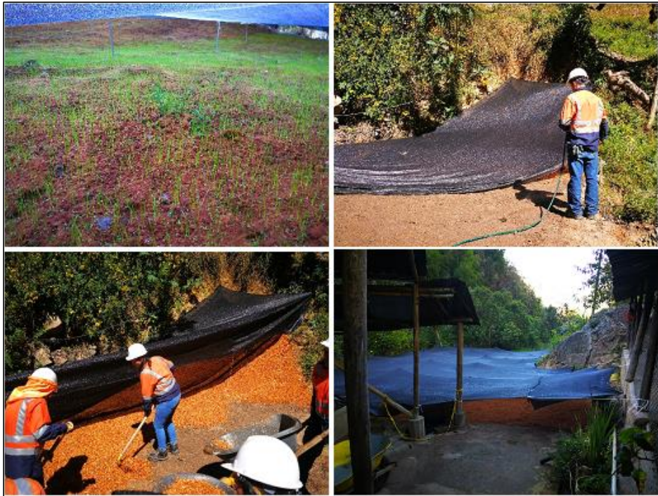
Fotografía 4: Germinación semilla, hidratación, extensión de la mezcla y puesta de la poli-sombra
