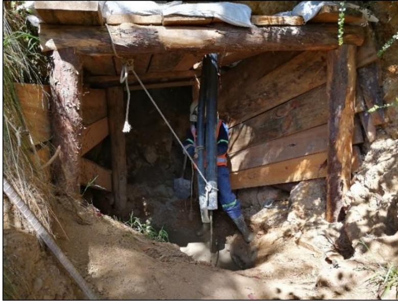
Fotografía 17: maniobras del auxiliar con tubería de bombeo del concreto y de la grava
