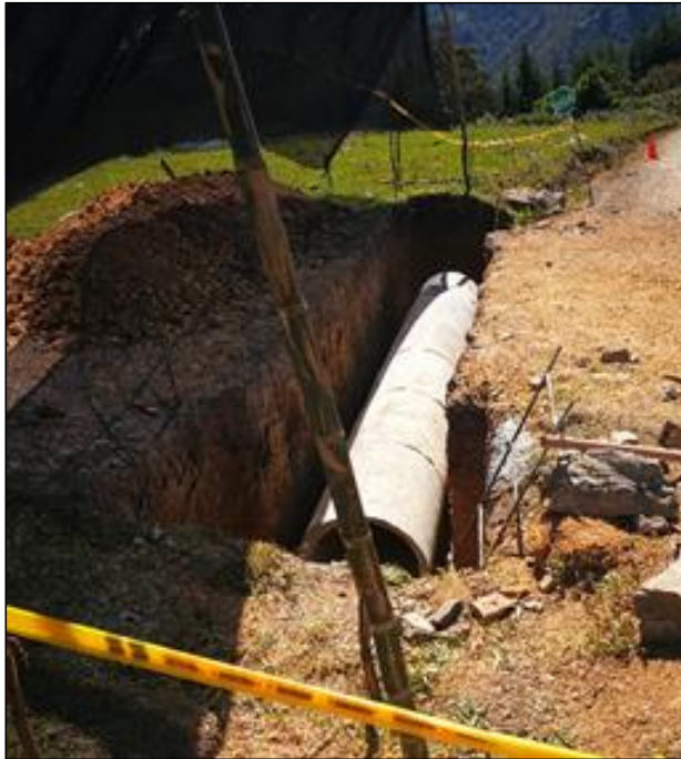
Fotografía 12: posicionamiento de la tubería de concreto de 600mm
