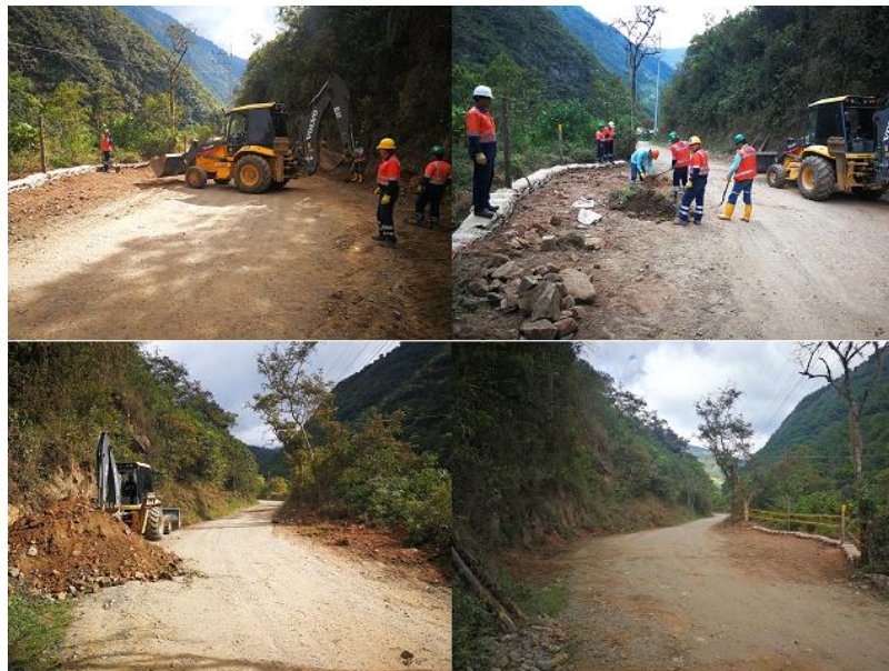
Fotografía 18: personal ejecutando las actividades de adecuación de la vía.
