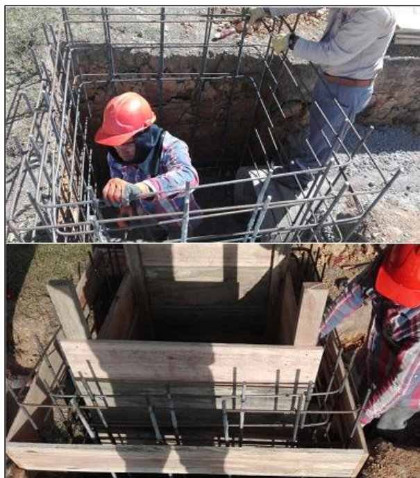
Fotografía 13: instalación acero de refuerzo y formaleta en madera para fundida alcantarilla
