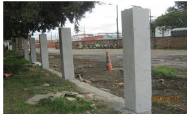
2018-06-08_Viernes / panorámica de la fundido de las 9 primeras columnas con concreto pre-mezclado de CEMEX (4 columnas en el nivel inferior [calle 13/17] y 5 columnas en el nivel superior)
