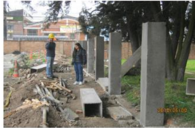
2018-06-08_Viernes / panorámica de la fundido de las 9 primeras columnas con concreto pre-mezclado de CEMEX (4 columnas en el nivel inferior [calle 13/17] y 5 columnas en el nivel superior)
